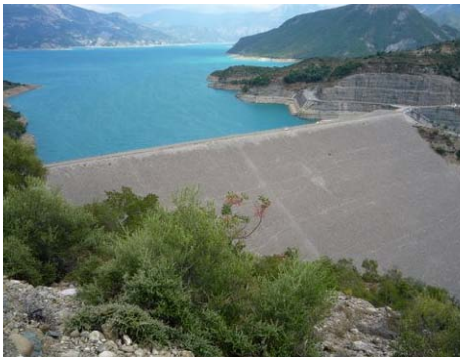
Εικ. 10.6 Φράγμα Κρεμαστών από τα νοτιοδυτικά.
