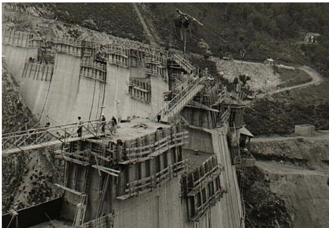
Εικ. 9.3 Το Δεκέμβριο του 1955 εγκαινιάστηκε το έργο και ξεκίνησε η κατασκευή του φράγματος Ταυρωπού.
