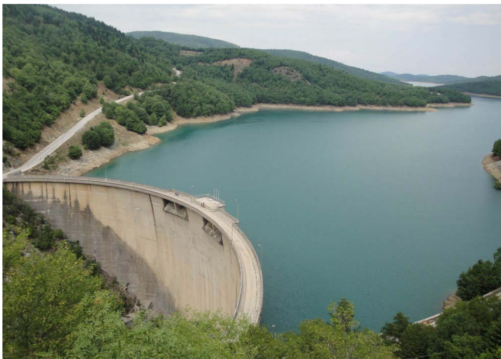
Εικ. 9.4 Άποψη του φράγματος Ταυρωπού
