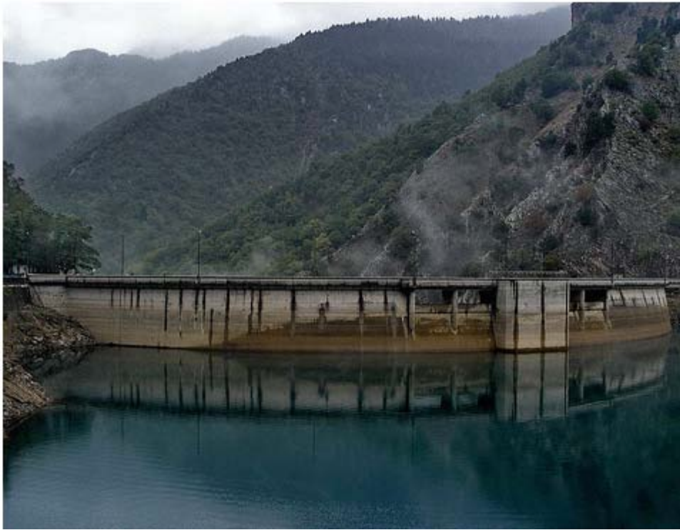
Εικ. 10.5 Το Φράγμα Ταυρωπού.
