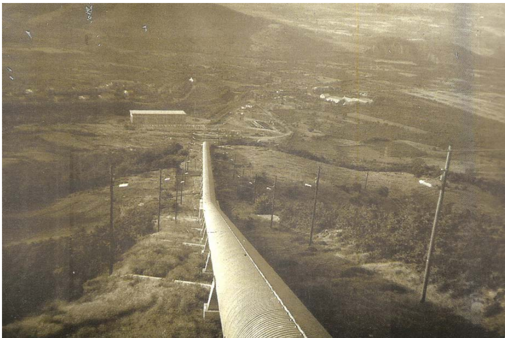
Εικ. 9.6 Το νερό της Λίμνης Πλαστήρα μεταφέρεται στο υδροηλεκτρικό εργοστάσιο μέσω αγωγού. Το ύψος πτώσης του νερού που κινεί τους υδροστροβίλους είναι 577 μέτρα.
