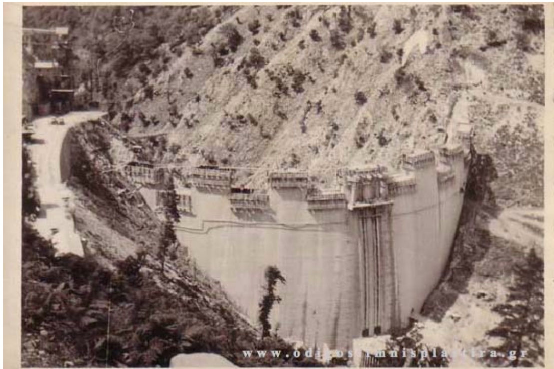
Εικ. 10.3 Το φράγμα του Ταυρωπού υπό κατασκευή.
