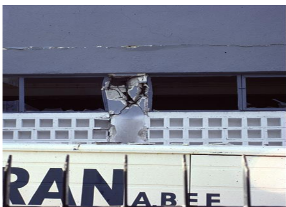
Εικόνα 3.4: Αστοχία κοντού υποστυλώματος(Πηγή: Γιαννόπουλος Ι., 2005)
