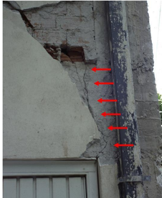
Εικόνα 4.30: Ανεπαρκής αγκύρωση πάνω & κάτω ράβδων δοκού(Πηγή: Γιαννόπουλος Ι., 2005)
