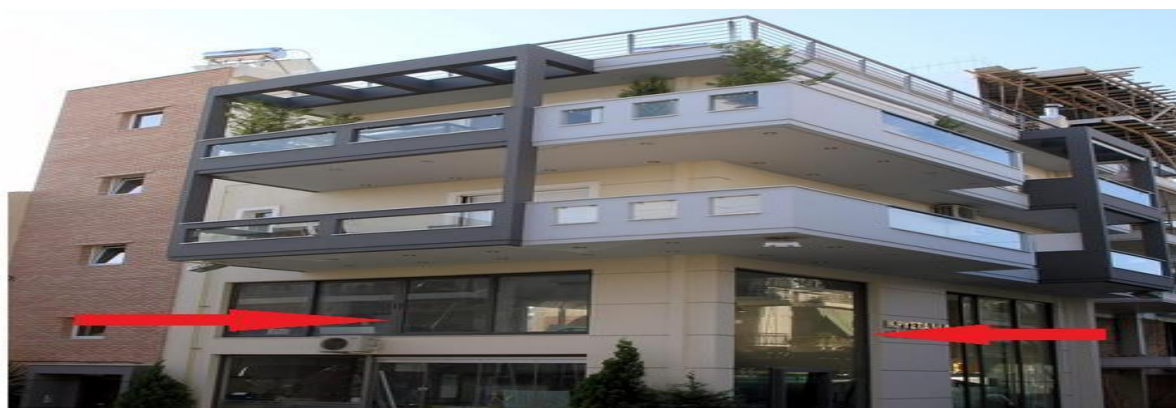
Εικόνα 3.1 : Γωνιακή οικοδομή με ασύμμετρη διάταξη τοιχοποιίας (Πηγή: http://kallasarchitects.gr/portfolio/polikatoikia-korydallos2006/ )
