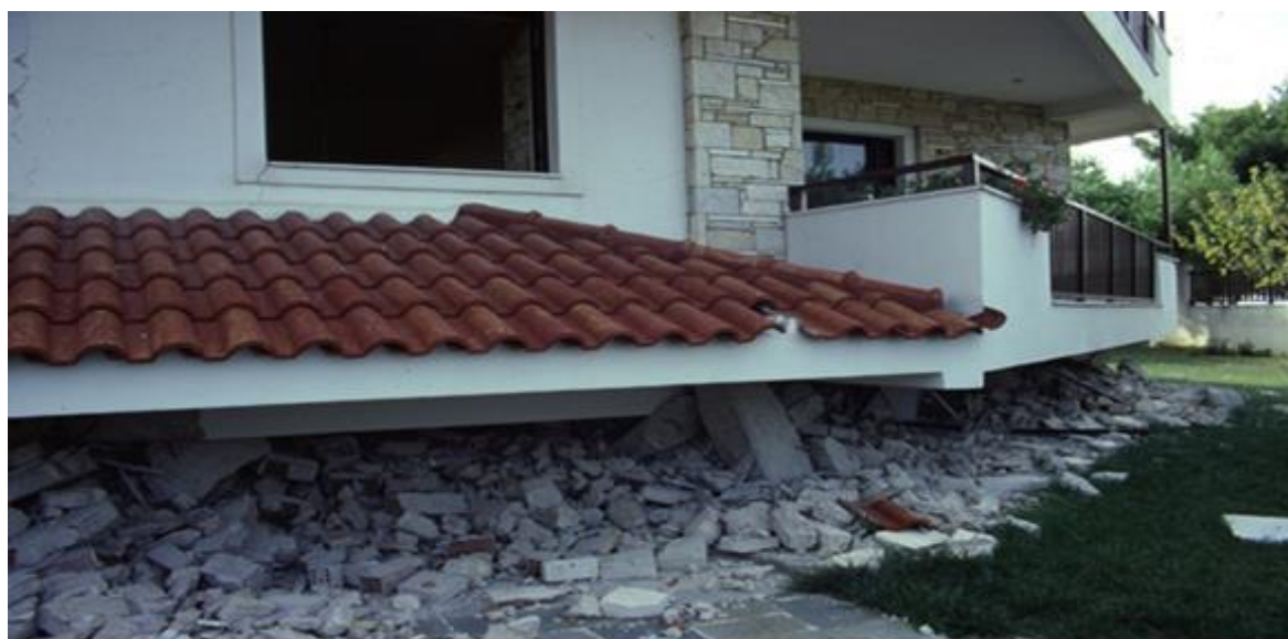
Εικόνα 4.27: Απώλεια Ισογείου (Πηγή: Γιαννόπουλος Ι., 2005)
