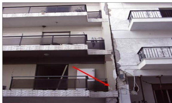
Εικόνα 3.11: Εμβολισμός υποστυλώματος από την πλάκα γειτονικού κτιρίου(Πηγή: Γιαννόπουλος Ι., 2005)
