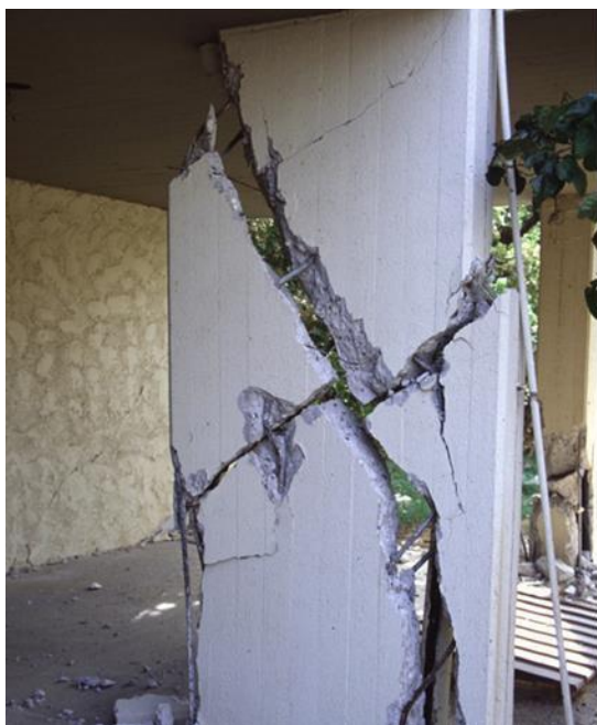
Εικόνα 4.40: Διατμητική αστοχία τοιχώματος με μεγάλες παραμορφώσεις(Πηγή: Γιαννόπουλος Ι., 2005)
