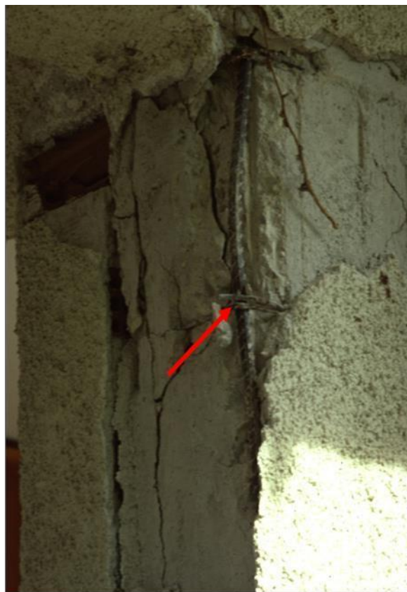
Εικόνα 4.25: Άνοιγμα συνδετήρων με κάμψη άκρων κατά 90ο μετά την αποφλοίωση της επικάλυψης των οπλισμών(Πηγή: Γιαννόπουλος Ι., 2005)
