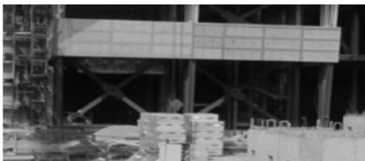
Εικόνα 5.33: Αντισεισμική ενίσχυση κατασκευής με χιαστί διαγωνίους συνδέσμους (Πηγή: Σπυράκος,2004)
