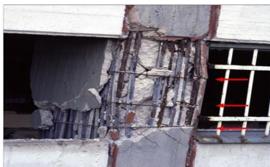
Εικόνα 3.3: Αστοχία κοντού υποστυλώματος (Πηγή: Γιαννόπουλος Ι., 2005)
