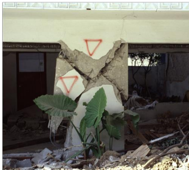
Εικόνα 4.40: Διατμητική αστοχία τοιχώματος με μεγάλες παραμορφώσεις(Πηγή: Γιαννόπουλος Ι., 2005)
