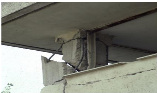
Εικόνα 3.3: Αστοχία κοντού υποστυλώματος (Πηγή: Γιαννόπουλος Ι., 2005)
