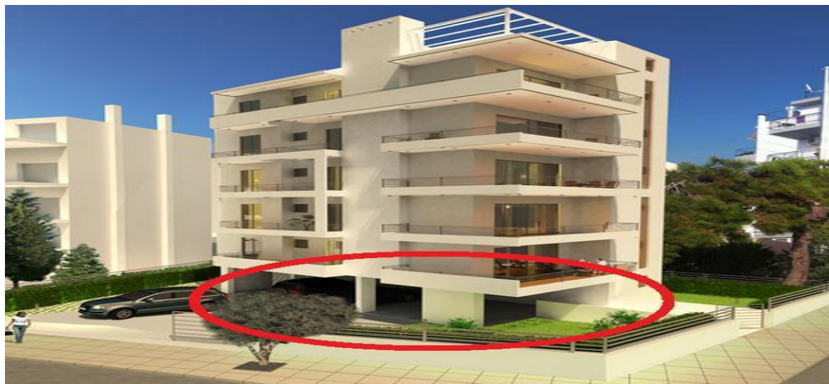
Εικόνα 3.2 : Πολυκατοικία με πιλοτή (Πηγή: http://www.evertch.gr/el/έργα/πολυκατοικίες/ )
