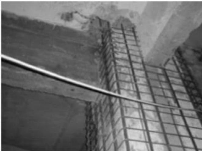
Εικόνα 5.23: Όπλιση μανδύα στην περιοχή του κόμβου δοκού – υποστυλώματος (Πηγή: Σπυράκος, 2004)
