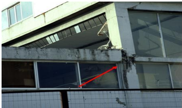
Εικόνα 3.11: Εμβολισμός υποστυλώματος από την πλάκα γειτονικού κτιρίου(Πηγή: Γιαννόπουλος Ι., 2005)
