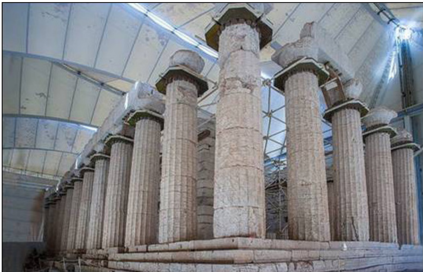
Εικόνα 20: Εσωτερική άποψη του στεγάστρου
