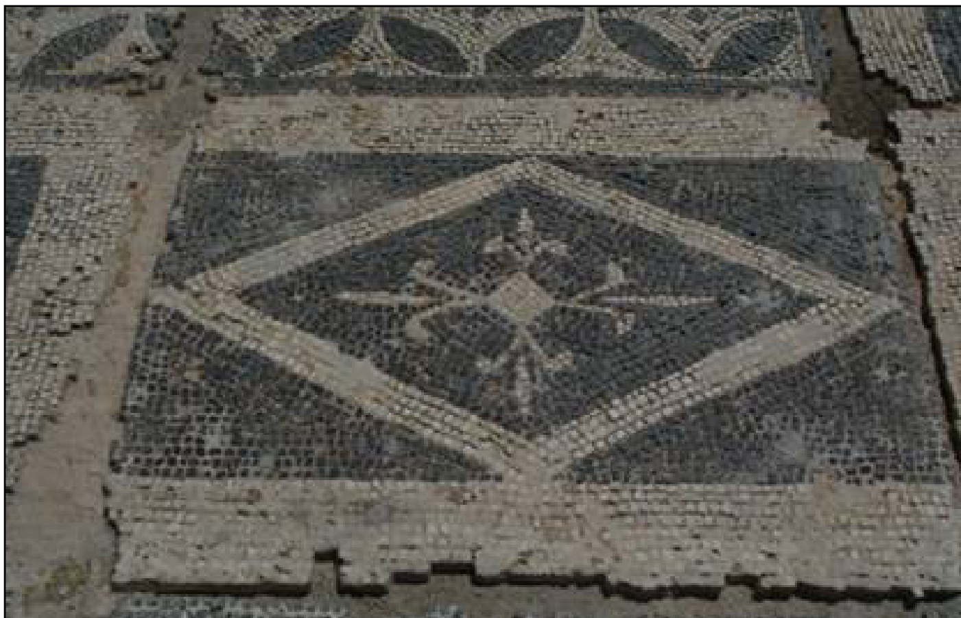
Εικόνα 23: Κατάσταση διατήρησης του ψηφιδωτού . Είναι ορατές οι περιοχές με απώλειες ψηφιδών
