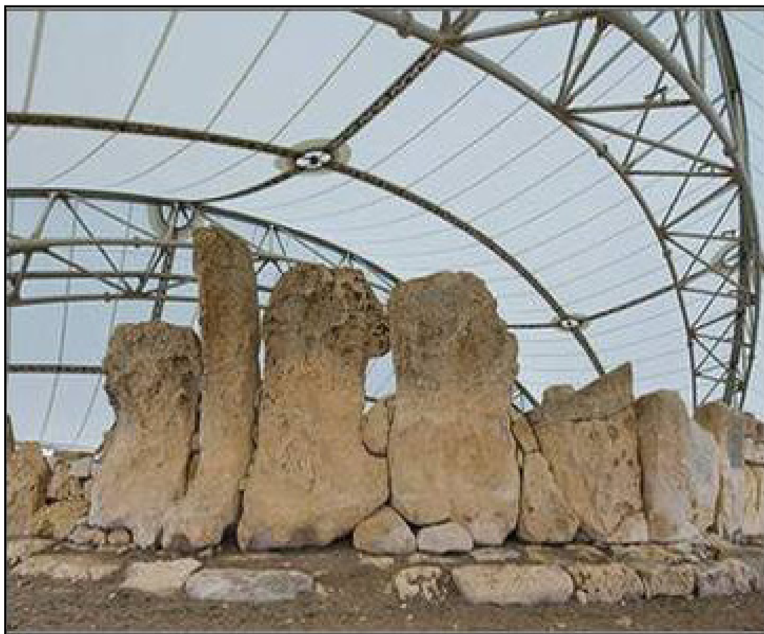
Εικόνα 49: Εσωτερική άποψη του συγκροτήματος των ναών Hagar Qim μετά την κατασκευή του στεγάστρου
