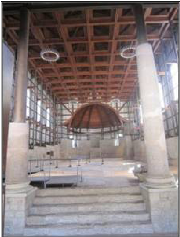
Εικόνα 32: Εσωτερική άποψη του στεγάστρου
