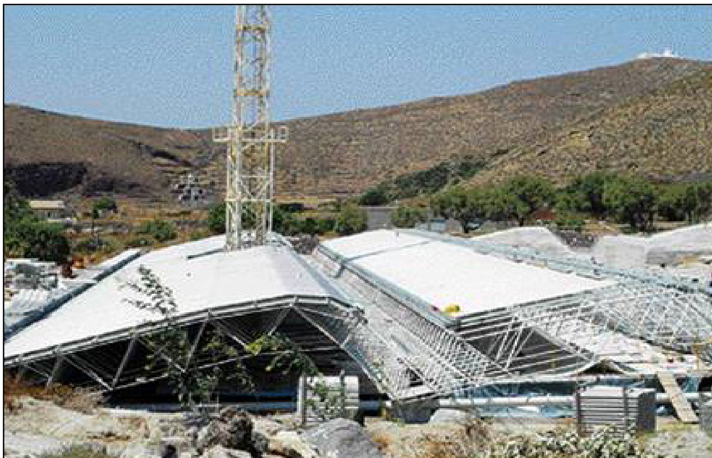
Εικόνα 14: Το υπό κατασκευή στέγαστρο του 1999
