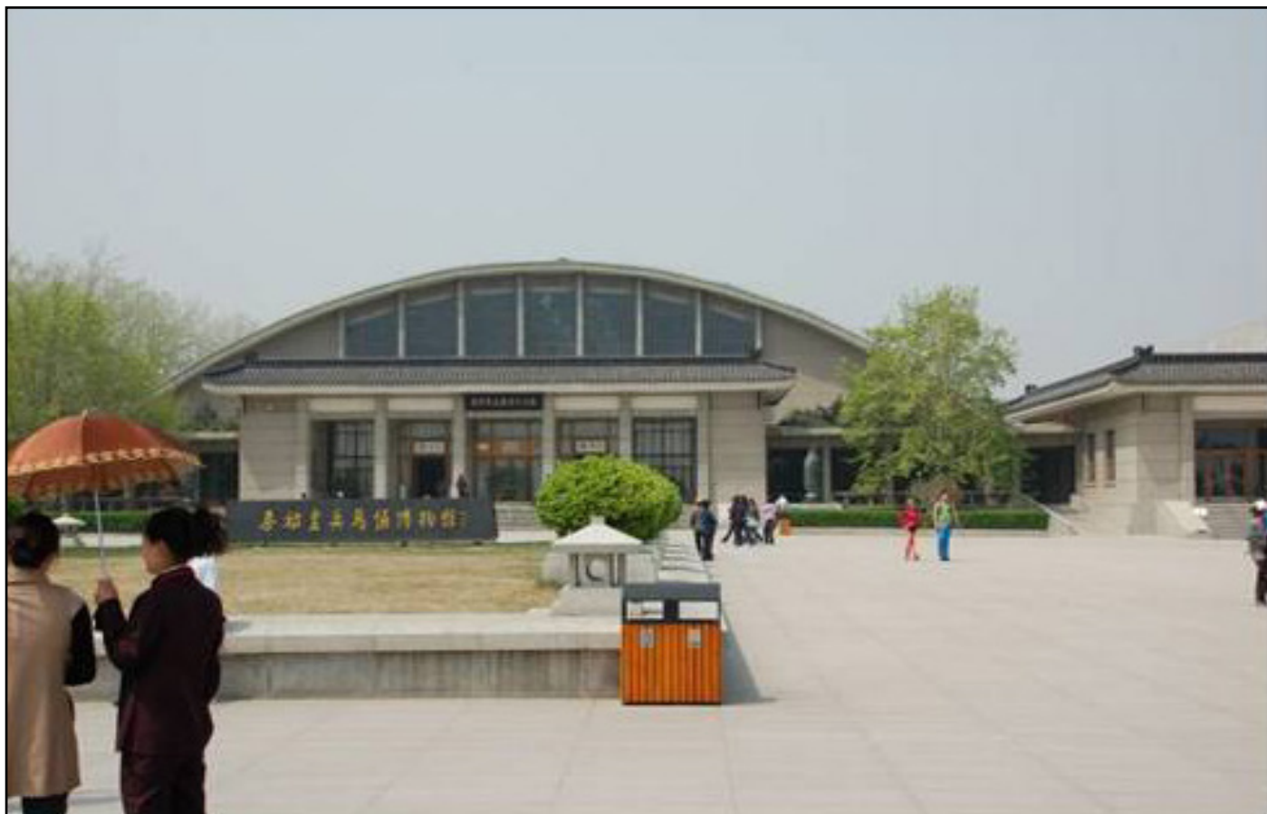
Εικόνα 33: Εξωτερική άποψη του κτιρίου που στεγάζει το όρυγμα 1 από το 1979
