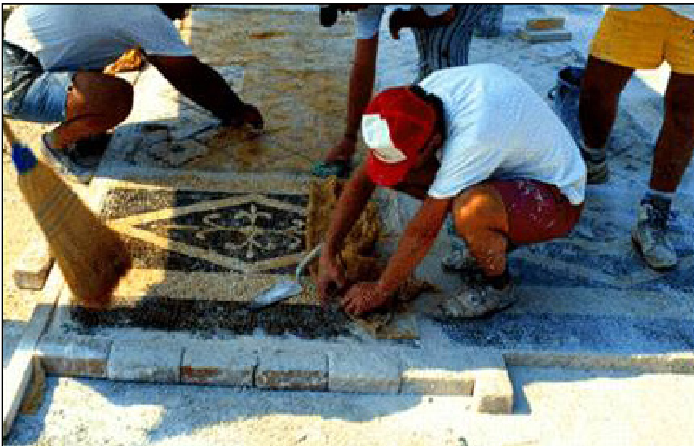
Εικόνα 26: Εργασίες επανατοποθέτησης του ψηφιδωτού
