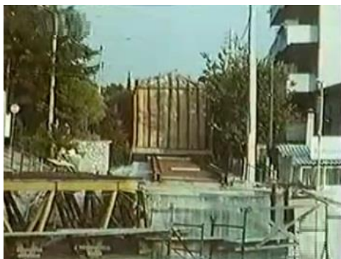
Εικ.38 Η διαδικασία της μεταφοράς του ναού
