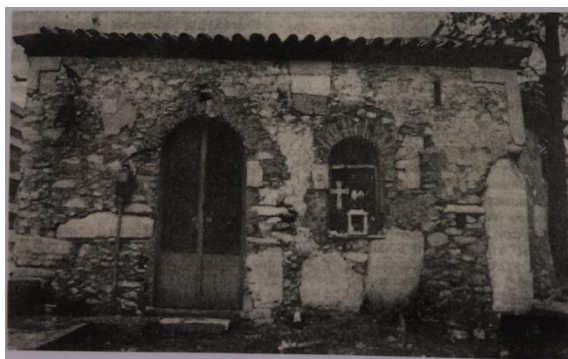
Εικ.35 Νότια πλευρά του ναού (1989)
