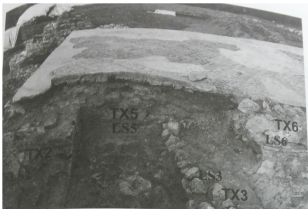
Εικ.134 Τοιχοποιία από οπτόπλινθους της ΒΔ γωνίας του κεντρικού κτίσματος της έπαυλης Πηγή φωτογρ.: Στρατής Α., Ιστορικά κονιάματα από την «Έπαυλη του Ηρώδη Αττικού», σ.283, εικ.1
