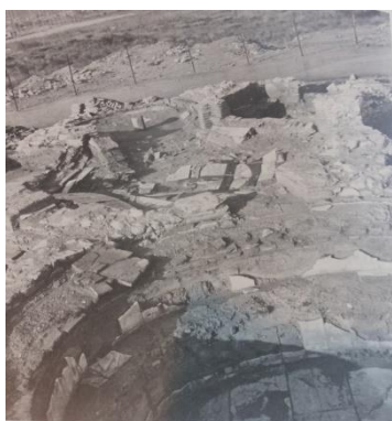
Εικ.249ι Χώρος XI του Βαλανείου Πηγή φωτογρ.: Αραπογιάννη Ξ., ΑΕ 1993, εικ.26, σ.156
