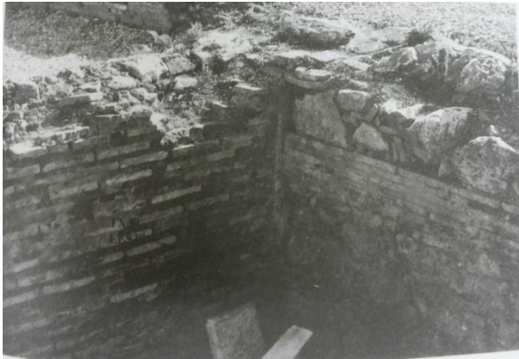
Εικ.135 Τοιχοποιία από αργούς λίθους και κεραμίδια της ΝΑ γωνίας του κεντρικού κτίσματος της έπαυλης Πηγή φωτογρ.: Στρατής Α., Ιστορικά κονιάματα από την «Έπαυλη του Ηρώδη Αττικού», σ.283, εικ.2
