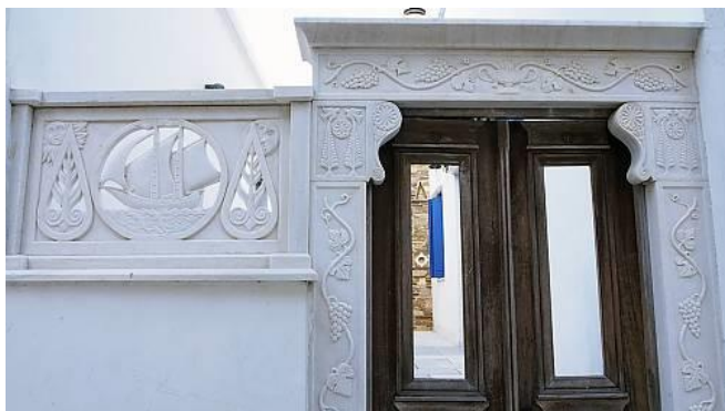
Εικόνα 15 - Υπέρθυρο σε σπίτι στον Πύργο Τήνου, Υπουργείο Πολιτισμού και Αθλητισμού (2014).
