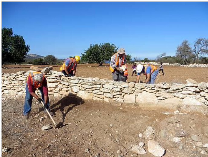
Εικόνα 22 - Κατασκευή τοίχου με την τεχνική ξερολιθιάς, Antonia Theodosiou (2016).
