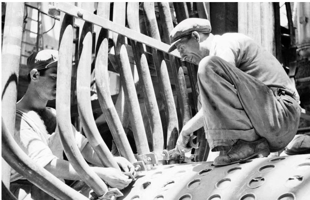
Εικόνα 1: Εργασίες στον νέο λέβητα του Σταθμού Νέου Φαλήρου, Ιούνιος 1950, Ιστορικό Αρχείο ΔΕΗ [2]
