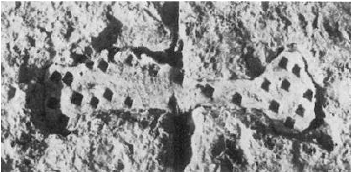
Εικ. 50. Σύνδεσμος σχήματος Η στη βάση του κίονα στη νοτιοδυτική γωνία του αναθήματος των Ατταλιδών (Roux 1987, πιν. 94c).
