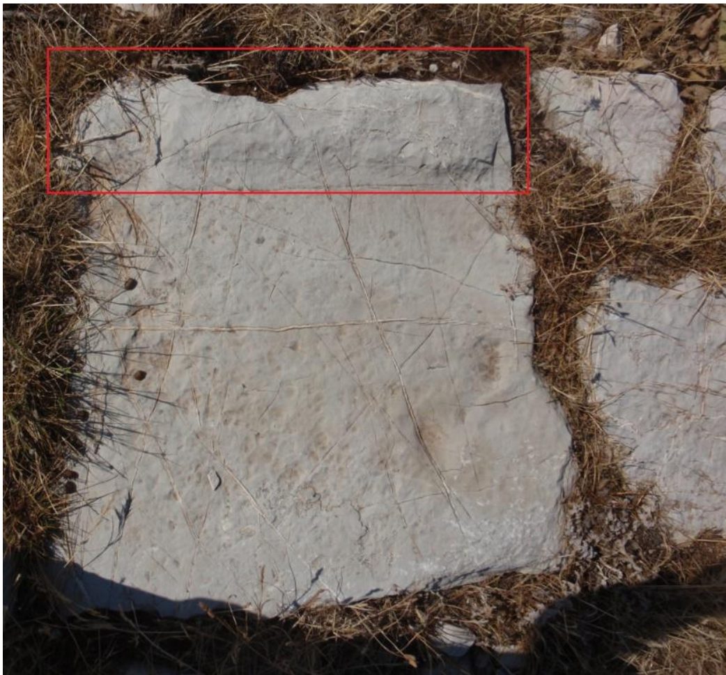
Εικ. 25. Λίθος της βόρειας ευθυντηρίας με άπεργο στην άνω επιφανειά του. Φωτ. Ειρήνη Σπυροπούλου
