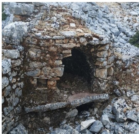
Εικόνα 83. Λίθινες βοηθητικές κατασκευές σε αυλές κατοικιών στα Λαταβινάτα (φούρνος) και τα Πουλάτα (στέρνα), για την καλύτερη στερέωσή τους χρησιμοποιείται συνδετικό κονίαμα.
