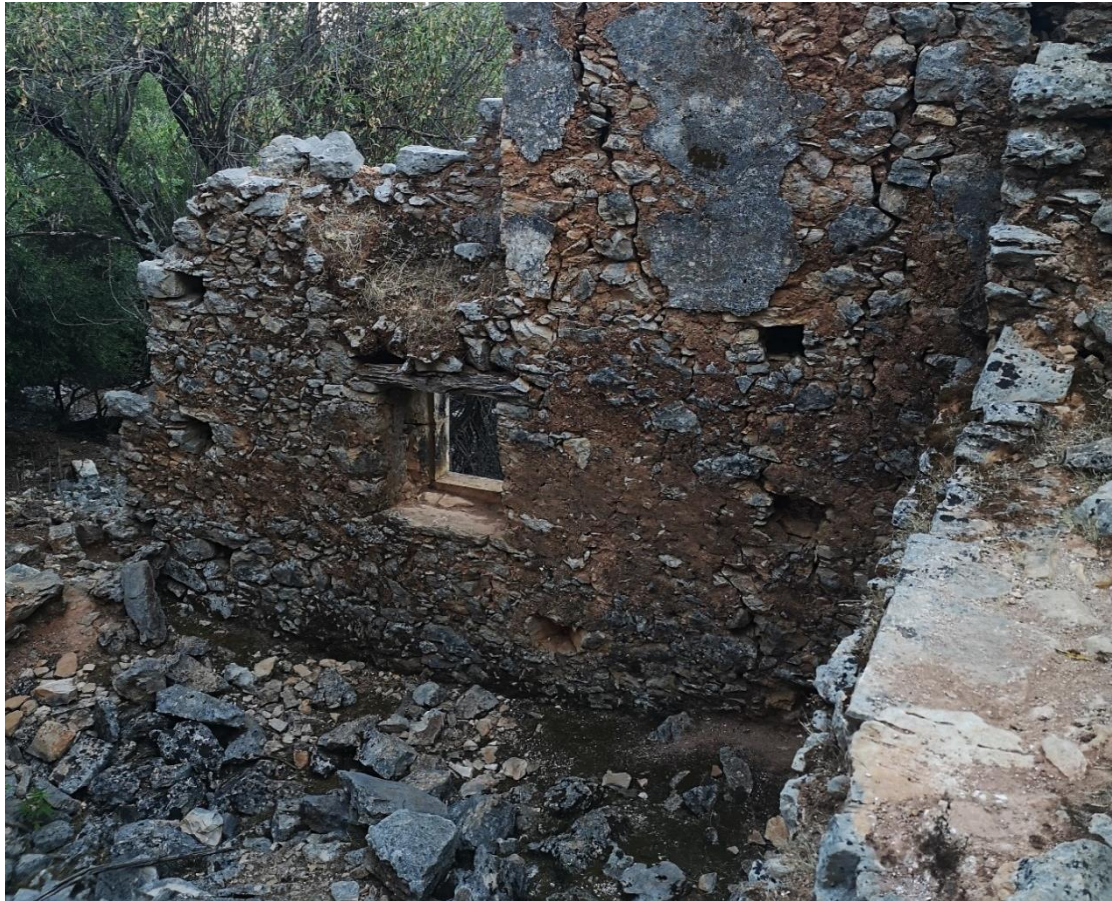
Εικόνα 82. Οπές στον τοίχο ισόγειας κατοικίας πιθανόν για την στήριξη των δοκαριών της ξύλινης στέγης.
