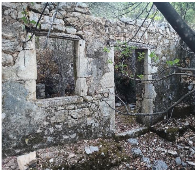
Εικόνα 78. Ανοίγματα με πλαίσιο από λαξευμένες πέτρες σε οικίες στους οικισμούς Πουλάτα και Λειβαθηνάτα. Τα ανώφλια είναι μονά, ευθύγραμμα και στηρίζονται συνήθως με κορμούς ξύλων. Σε εισόδους κεντρικές σχηματίζουν αψίδα στο εσωτερικό (ρεμενέτο) όπως φαίνεται στην πάνω δεξιά φωτογραφία. Πηγή: Προσωπικό αρχείο
