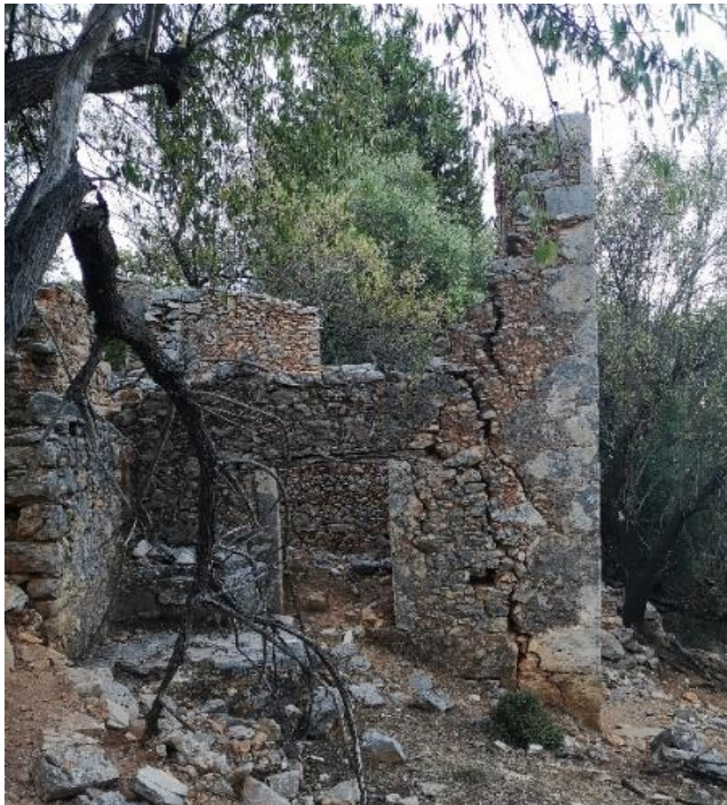
Εικόνα 87. Όψη οικίας με φανερό το επίχρισμα που έχει παραμείνει στην εξωτερική τοιχοποιία Πηγή: προσωπικό αρχείο
