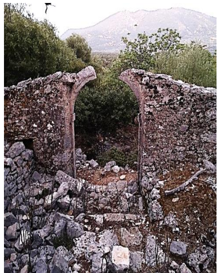
Εικόνα 78. Ανοίγματα με πλαίσιο από λαξευμένες πέτρες σε οικίες στους οικισμούς Πουλάτα και Λειβαθηνάτα. Τα ανώφλια είναι μονά, ευθύγραμμα και στηρίζονται συνήθως με κορμούς ξύλων. Σε εισόδους κεντρικές σχηματίζουν αψίδα στο εσωτερικό (ρεμενέτο) όπως φαίνεται στην πάνω δεξιά φωτογραφία. Πηγή: Προσωπικό αρχείο
