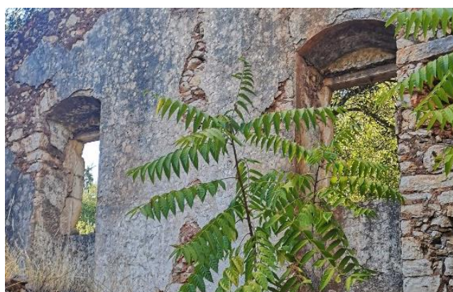
Εικόνα 81. Τυπολογία ανωφλιών που συναντώνται στους προσεισμικούς οικισμούς : με χρήση ξύλου για καλύτερη στήριξη, αλλά και ανακουφιστικά τόξα.
