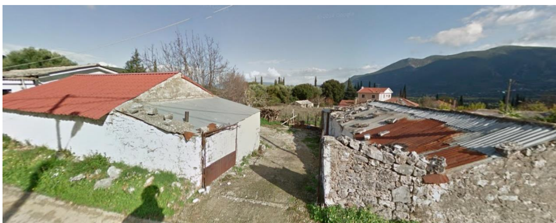
Εικόνα 63. Κτίσματα σε χαμηλότερη στάθμη σε σχέση με το οδικό δίκτυο, που συνήθως εξυπηρετούν αγροτικές και κτηνοτροφικές εργασίες. Πηγή: προσωπικό αρχείο
