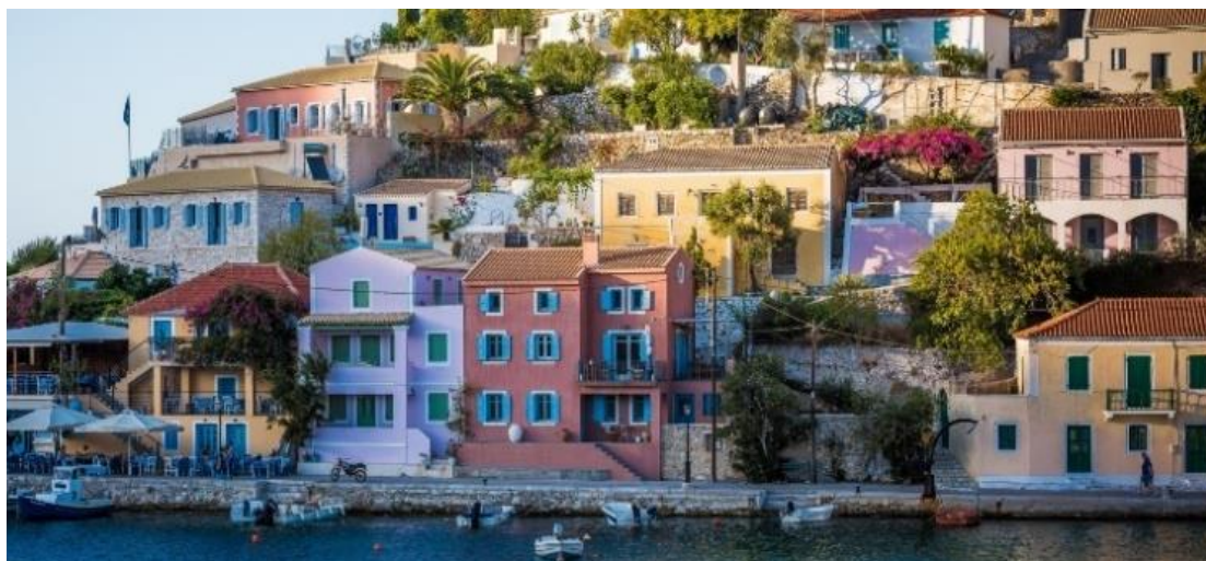
Εικόνα 29. Διατηρητέος οικισμός από τους πρώτους που χαρακτηρίστηκαν ήταν το Φισκάρδο της Κεφαλονιάς. (Πηγή : https://visitkefallonia.com )
