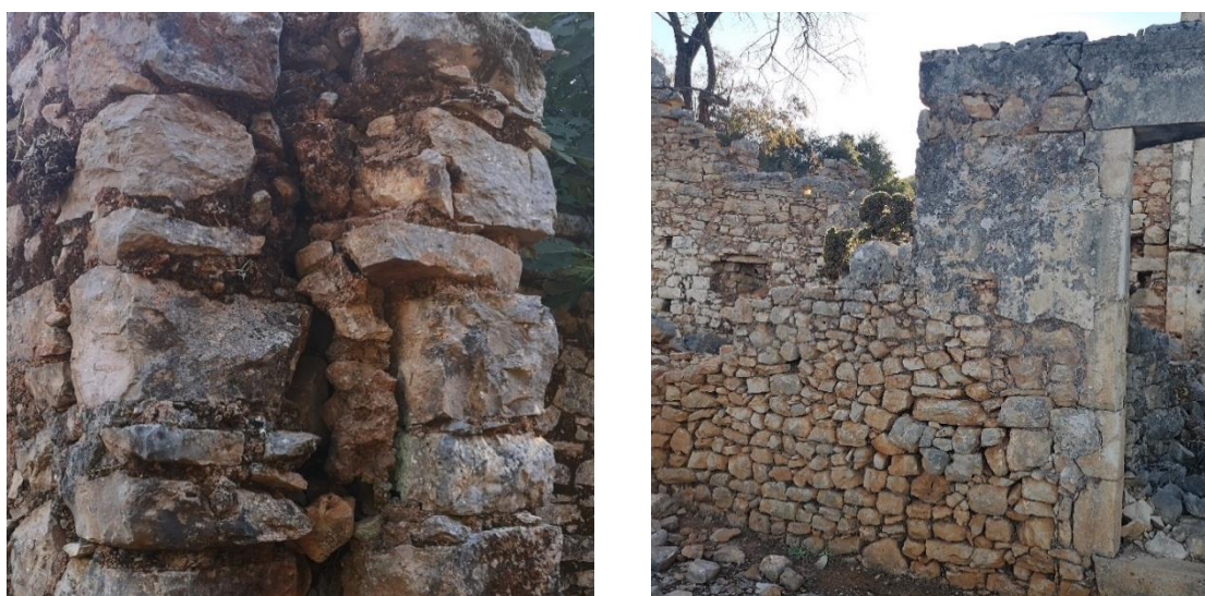
Εικόνα 80. Αργολιθοδομή με συνδετικό κονίαμα από μικρότερες πέτρες και χώμα (αριστερά), Ξερολιθική κατασκευή τοίχου κατοικίας καλυμμένος με ασβεστοκονίαμα (δεξιά).
