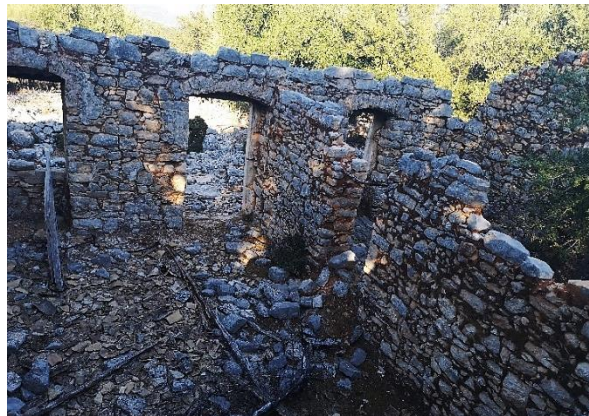
Εικόνα 89. Λεπτομέρειες και ίχνη από δοκούς στήριξης ορόφων οι οποίοι έχουν με τον καιρό καταρρεύσει και αλλειωθεί.
