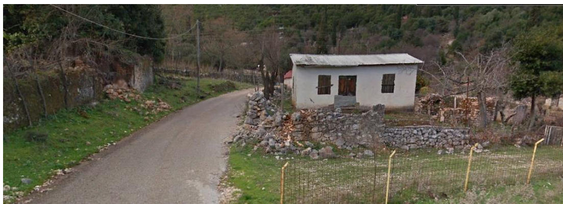
Εικόνα 65. Ο επαρχιακός δρόμος από Σάμη προς τα Πουλάτα. Το παλιό χωριό διαμορφώνεται από την αριστερή πλευρά του πλατώματος του δρόμου και ενώνεται με αυτόν με ένα παράδρομο.
