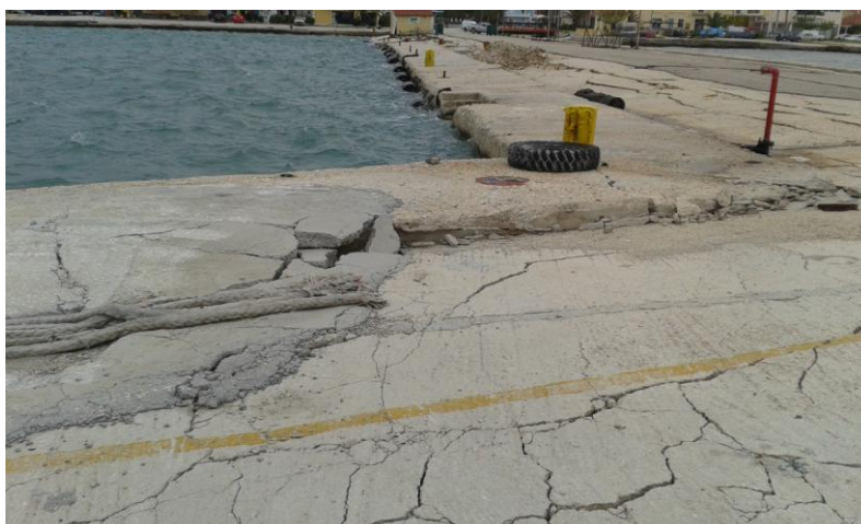
Εικόνα 3.21: Λιμάνι Ληξουρίου – Κεφαλονιά (2014)
