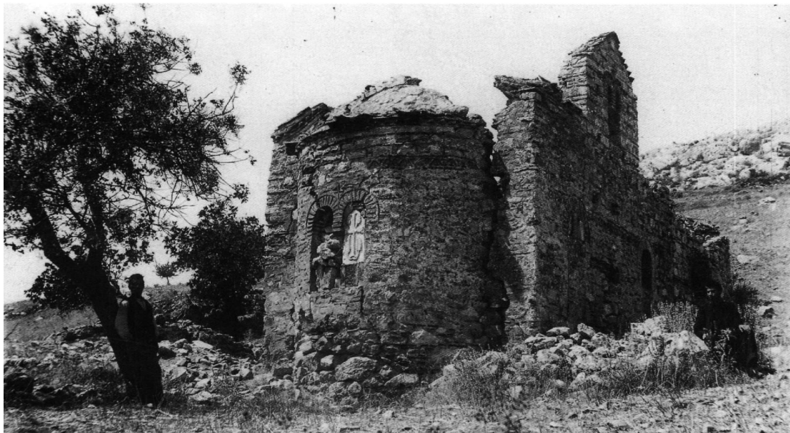
Εικ.24 Γαλαξίδι, Μεταμόρφωση Σωτήρος, Βορειοανατολική άποψη
