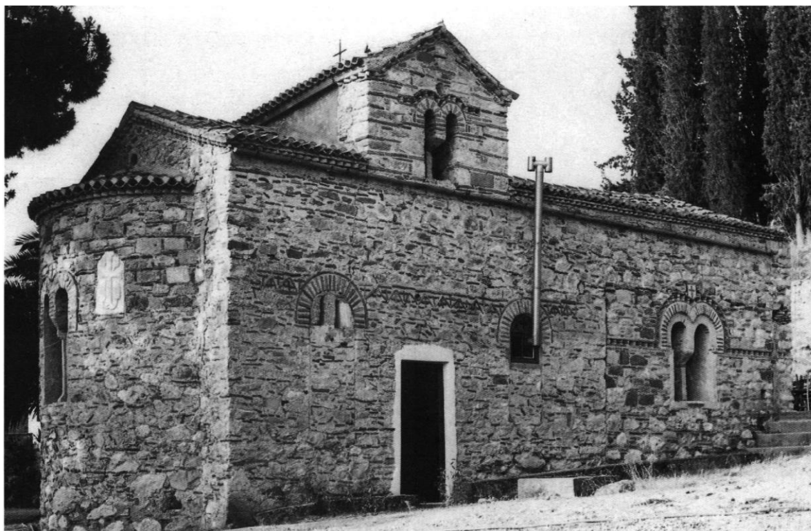
Εικ.26 Γαλαξίδι, Μεταμόρφωση Σωτήρος, Βορειοανατολική άποψη
