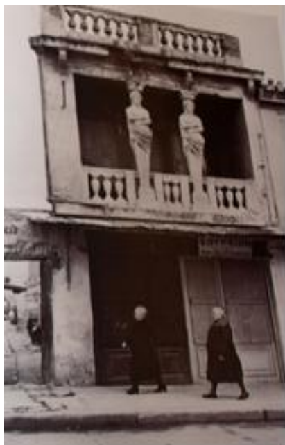
Εικόνα 90. Αθήνα, οδός Ασωμάτων. 1953. Φωτογράφος Henri Cartier Bresson.
