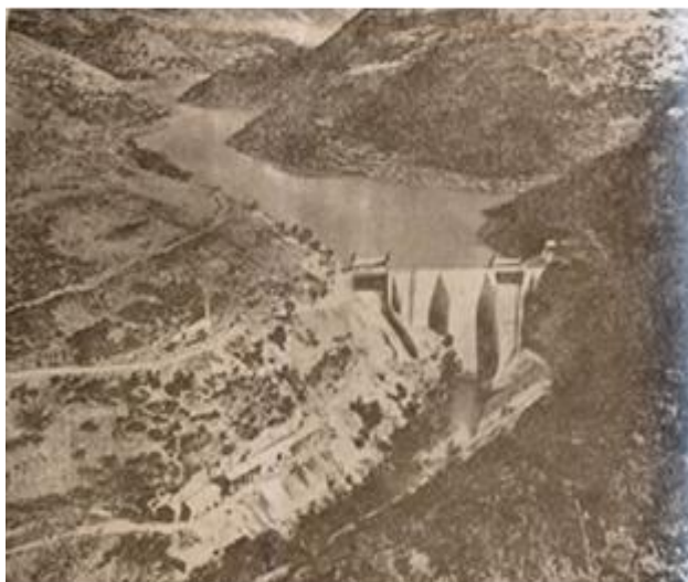
Εικόνα 342. Γενική άποψις φράγματος επί του Λάδωνος, τύπου βαρύτητας μετά κοιλωμάτων και τεχνητής λίμνης. 15 Φεβρουαρίου – 1 Μαρτίου 1956.
