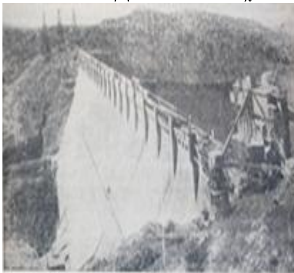
Εικόνα 208. Ευθύγραμμο κτιστό φράγμα του Elephant Butte εν Νέω Μεξικό. Απρίλιος 1923.
