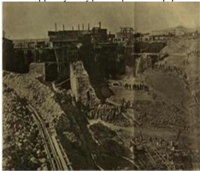
Εικόνα 195. Δεξαμενές επισκευής λιμένος Πειραιώς. Στάσεις έργων κατά το τέλος 1906. Αρχιμήδης. Ιανουάριος 1908.
