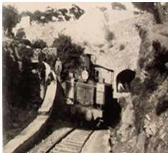
Εικόνα 134. 1880. Η πρώτη σιδηροδρομική σήραγγα της Ελλάδος στην γραμμή της ελληνικής εταιρείας μεταλλουργιών Λαυρίου που είχε κατασκευασθεί το 1870 και είχε μήκος 265 μέτρων. Φωτογράφος άγνωστος.
