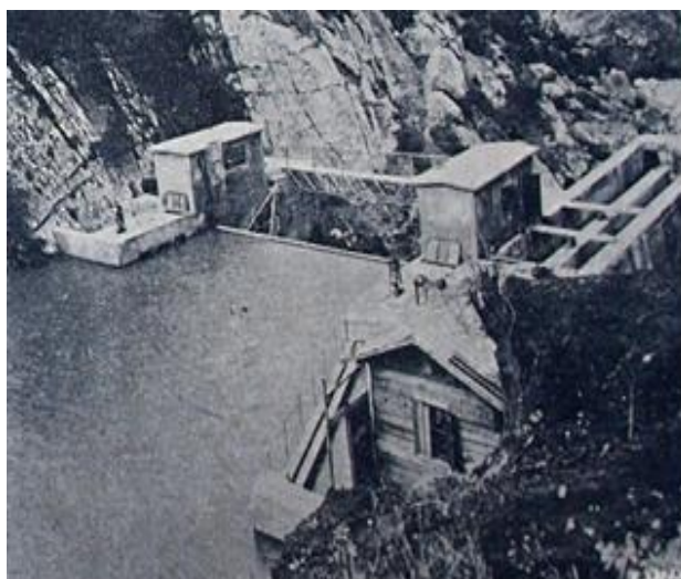
Εικόνα 244. Αι υδροηλεκτρικαί εγκαταστάσεις του ποταμού Γλαύκου. Πάτρα. Γενική άποψις του φράγματος εκ των ανάντη. 30 Μαΐου 1927.
