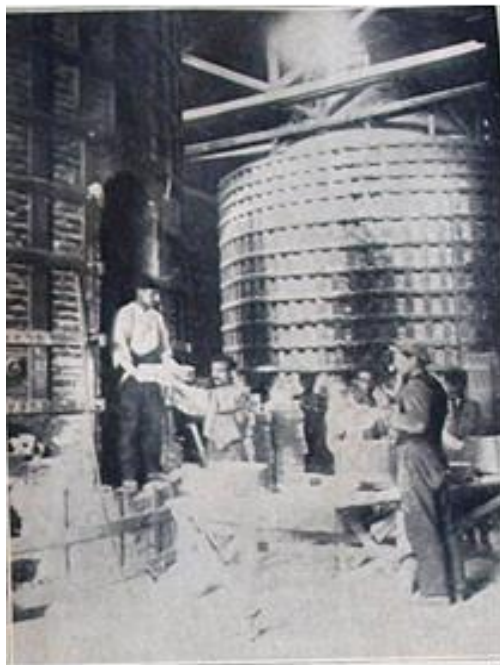
Εικόνα 222. Εργοστάσιο Κεραμεικού. Αι δύο παλιοί κάμινοι. Φόρτισης της καμίνου της δευτέρας εψήσεως και τα Πυροδοχεία. 15 Ιουνίου 1925.
