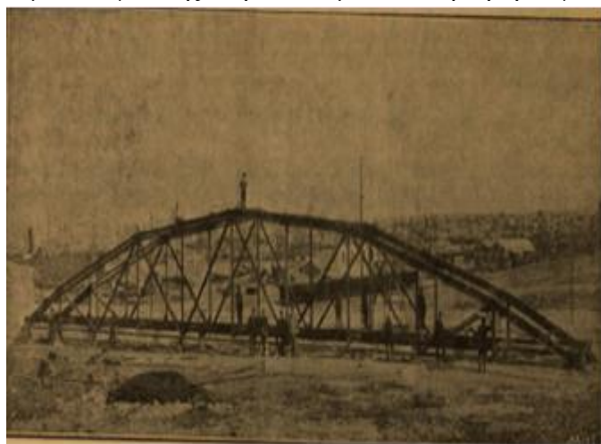
Εικόνα 197. Γέφυρα μεταλλική ανοίγματος 41 μέτρων επί του ποταμού Κόκκινου εν Ναυπακτία. Μάιος 1908.
