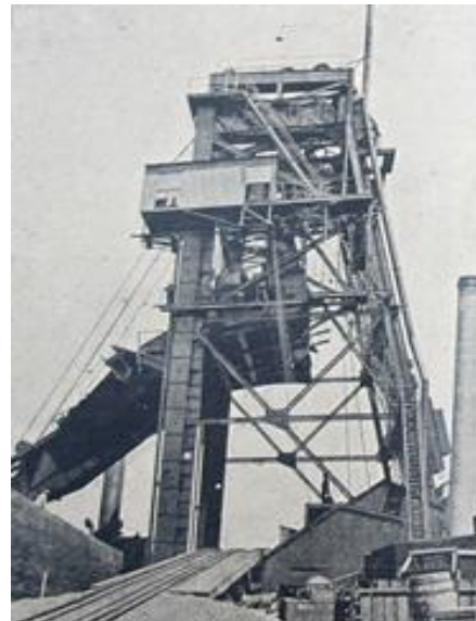
Εικόνα 259. Εκκενωτήρ βαγονιών άνθρακος Brown - Hoist Co ηλεκτροκίνητος, εγκατασταθείς εν Toledo των Ηνωμένων Πολιτειών. Βαγόνια 50 τόνων άνθρακος υψώνονται και ανατρέπονται εκ των πλαγίων εντός κεκλιμένου σύρτου, οπόθεν ο άνθραξ καταπίπτει εις το κύτος του πλοίου. 30 Οκτωβρίου 1928.
