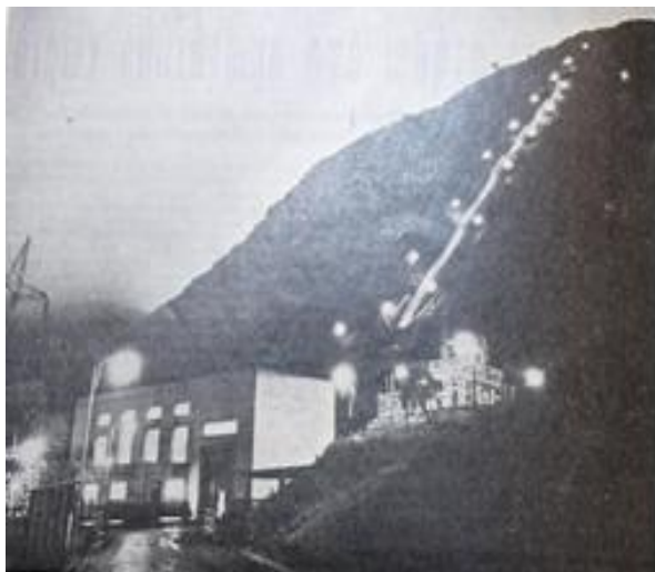
Εικόνα 394. Εκεί ψηλά στη Γορτυνία η ΔΕΗ έχει στήσει ένα πρωτότυπο χωριό. Ο σταθμός κατάφωτος το βράδυ όπως και η σήραξ που σκαρφαλώνει στο βουνό, αποτελούν ένα πραγματικά φαντασμαγορικό σύνολο. Αύγουστος 1961.
