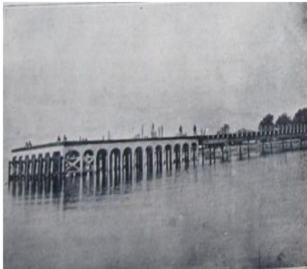
Εικόνα 200. Αποβάθρα σιδηροδρόμου Λάρισας εν Αγία Μαρίνη εκ σιδηροπαγούς σκυροκονιάματος. Ιούλιος 1910.
