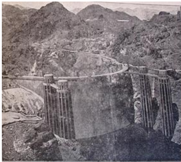
Εικόνα 307. Το φράγμα Boulder. Εκατέρωθεν διακρίνονται οι τέσσερις πύργοι υδροληψίας. 15 Απριλίου 1936.
