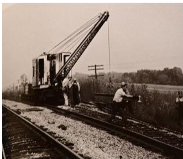
Εικόνα 123. Τροχήλατος γερανός μεταφέρει ράγες για την στρώση νέων σιδηροδρομικών γραμμών. 1950. Φωτογράφος Ιωάννης Λάμπρος.
