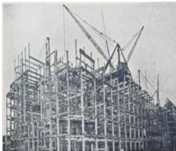
Εικόνα 273. Λονδίνο. Thames House. Συναρμολόγηση του σιδηροσκελετού. 15 Ιουλίου 1931.
