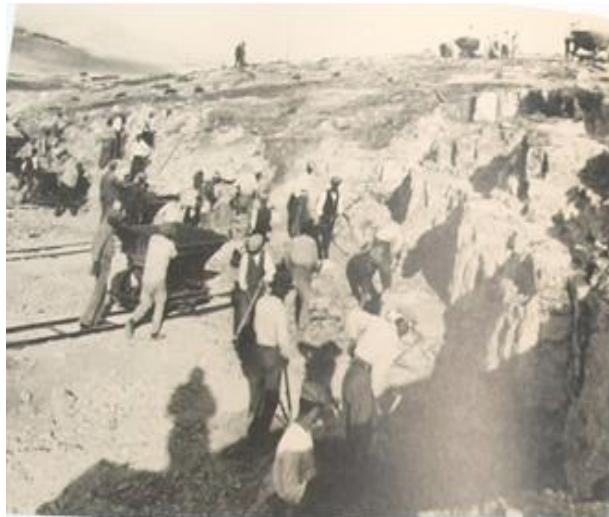
Εικόνα 151. Από την κατασκευή του κεντρικού ατμοηλεκτρικού σταθμού Αγίου Γεωργίου στο Κερατσίνι. Ιανουάριος 1927. Φωτογραφικό αρχείο ΗΕΑΠ.
