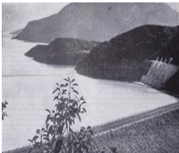
Εικόνα 401. Πανοραμική άποψη της λίμνης των Κρεμαστών, όπου ήδη είναι εγκατεστημένα και τα μεγάλα σύγχρονα υδροηλεκτρικά έργα της ΔΕΗ. Ιανουάριος 1967.
