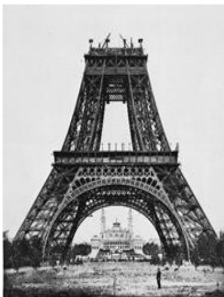
Εικόνα 127β. Ο πύργος του Αιφελ κατά την διάρκεια κατασκευής του. 1888. Φωτογράφος Louis-Emile Durandelle.
