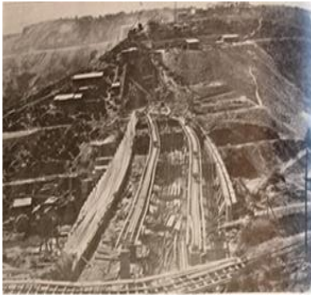
Εικόνα 296. Το φράγμα Μαραθώνος κατά την κατασκευή. 1 Ιανουαρίου 1934.
