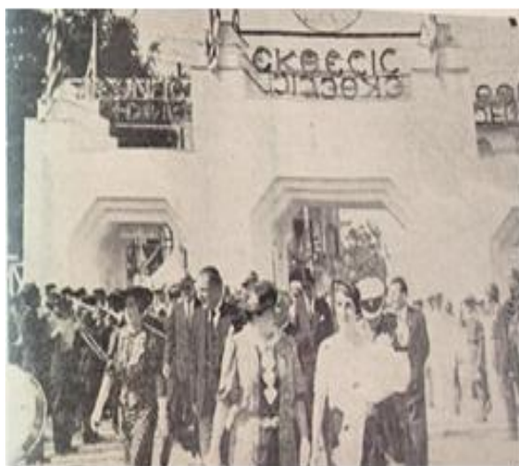
Εικόνα 12. Οι επίσημοι προσερχόμενοι εις τα εγκαίνια της εκθέσεως. Διακρίνονται οι υπουργοί κ. κ. Κυρίμης και Νικολούδης μετά των κυριών του. Περιοδικό Βιομηχανική Επιθεώρηση. Οκτώβριος 1937.
