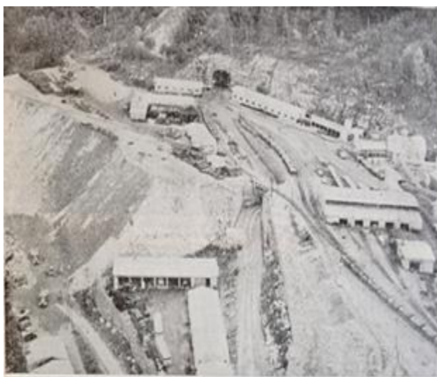
Εικόνα 347. Η οδική σύραγξ του Λευκού όρους. Άποψις από αέρος των εξωτερικών εγκαταστάσεων και του στομίου της σήραγγας. Ιανουάριος 1963.
