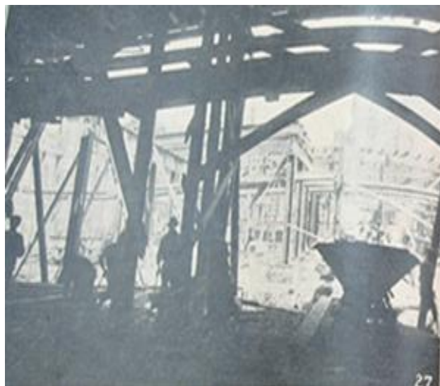
Εικόνα 407. Συναρμολόγησης σιδηροδοκών σταθμού πλατείας Ομονοίας. Περιοδικό Έργα 30 Απριλίου 1929.
