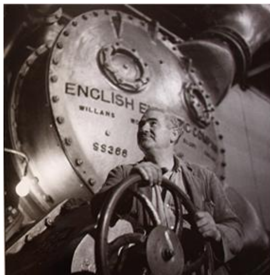
Εικόνα 153. Σταθμός Αγίου Γεωργίου στο Κερατσίνι. 1949. Φωτογραφικό αρχείο ΗΕΑΠ.
