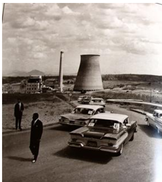
Εικόνα 154. Ατμοηλεκτρικός σταθμός Πτολεμαΐδας. 1954. Φωτογραφικό αρχείο ΔΕΗ.
