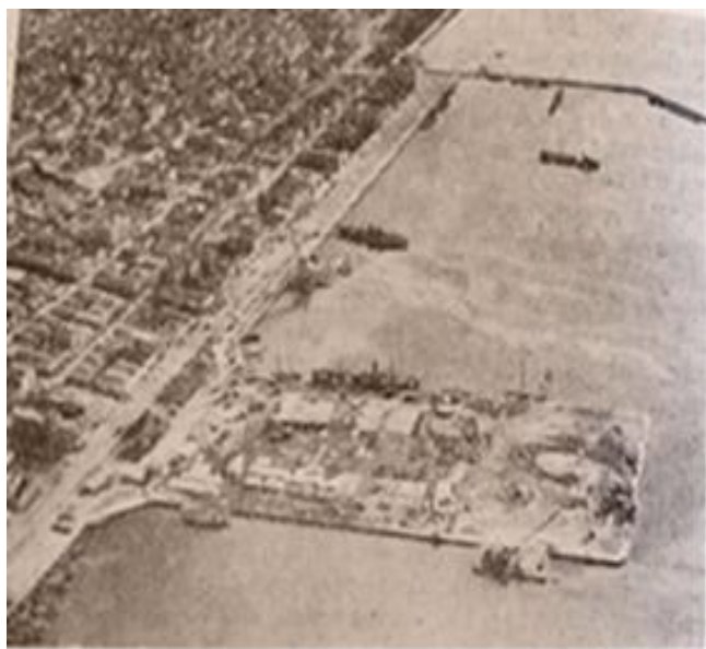
Εικόνα 333. Προβλής λιμένος Βόλου μετά την αποπεράτωση των εργασιών. Απρίλιος 1949.
