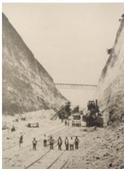
Εικόνα 6. Η διώρυγα της Κορίνθου. Εκσκαφές σε μέσο ύψος. Διακρίνονται τα βαγονέτα και οι λοκομοτιβες για την μεταφορά των χωμάτων. Περίπου 1885. Φωτογράφος άγνωστος.
