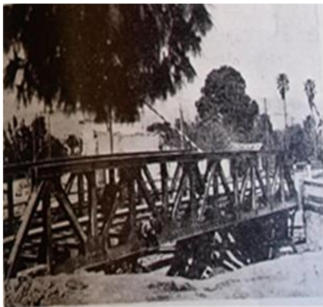
Εικόνα 330. Η γέφυρα έτοιμη μετά την αποκατάσταση του μεταλλικού ζευκτού. Οκτώβριος 1948.
