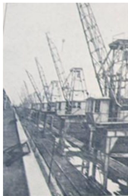
Εικόνα 274. Ηλεκτρικοί γερανοί δύο τόνων εις τον λιμένα του Πειραιώς. 15 Απριλίου 1931.
