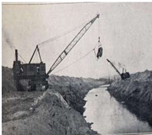
Εικόνα 177. Τμήμα της αρχής της κύριας αποχετευτικής διώρυγας του Αξιού ποταμού. Ένθεν και ένθεν οι δύο εκσκαφείς. Περιοδικό Έργα. 30 Ιουνίου 1927
