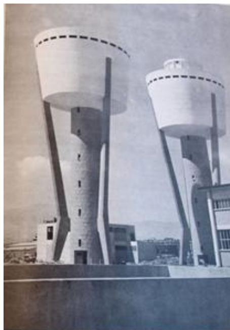
Εικόνα 350. Εργοστάσιο Αζωτούχων Λιπασμάτων Πτολεμαΐδας. Δεξαμενές νερού. Ιούνιος 1965.
