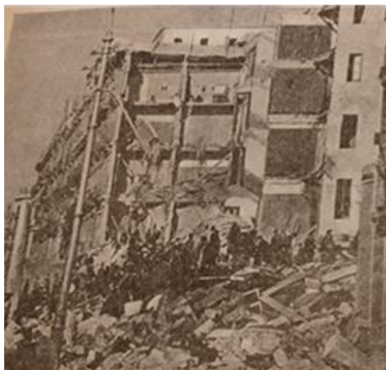
Εικόνα 315. Κατάρρευσις κτιρίων εξ εναερίου βομβαρδισμού του ισπανικού πολέμου. Εξ αυτής καταφαίνεται ο μέγας όγκος των συσσωρευομένων κατακρημνισμάτων και ο απαιτούμενος χρόνος και εργασία δια την απομάκρυνση αυτών δια την απελευθέρωση ενδεχομένως εγκλείστων εν καταφυγίω υπό τα ερείπια. 1 Αυγούστου 1938.
