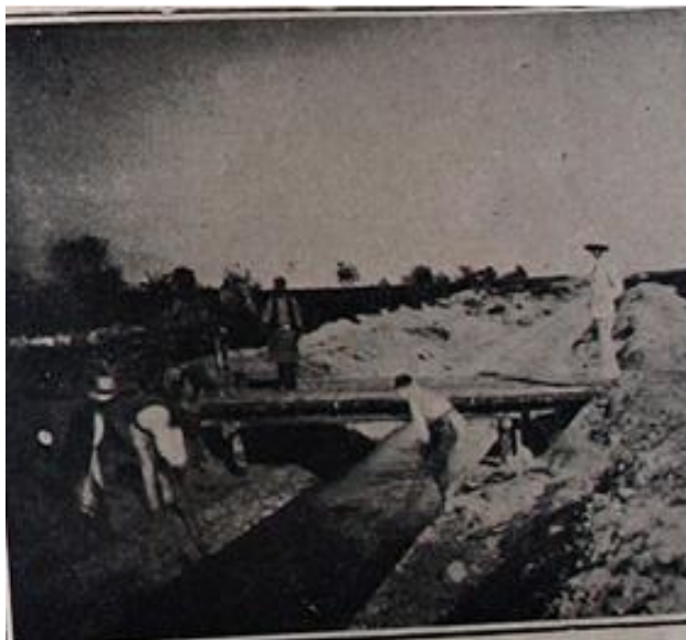
Εικόνα 231. Η αποξήρανση των ελών της Νέας Αγχιάλου. Κεντρική τάφος παρά την ξύλινη γέφυρα. 30 Νοεμβρίου 1925.
