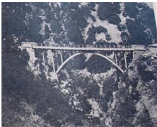
Εικόνα 58. Γέφυρα επί του ποτάμου Διποτάμου της Εθνικής οδού Καλαμών – Σπάρτης (ολ. αν. 35μ ). Περιοδικό Τεχνικά Χρονικά. 1 Οκτωβρίου – 1 Νοεμβρίου 1934.
