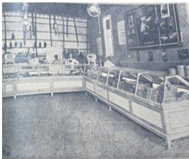
Εικόνα 250. Εντός των προθηκών του καταστήματος των τροφίμων οι ψυκτικές σωληνώσεις εξασφαλίζουν την ωπότητα των εμπορευμάτων. 30 Ιανουαρίου 1929.
