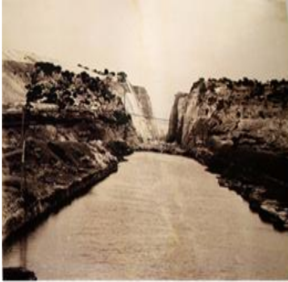
Εικόνα 133γ. Γενική άποψη του εργοταξίου στον Ισθμό της Κορίνθου. Περίπου 1885. Φωτογράφος Αναστάσιος Γαζιάδης.
