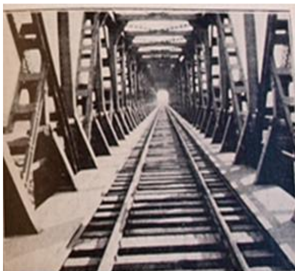
Εικόνα 291. Σιδηρά σιδηροδρομική γέφυρα Αλιάκμονος. Όψις γέφυρας εκ του εσωτερικού. 15 Φεβρουαρίου 1933.
