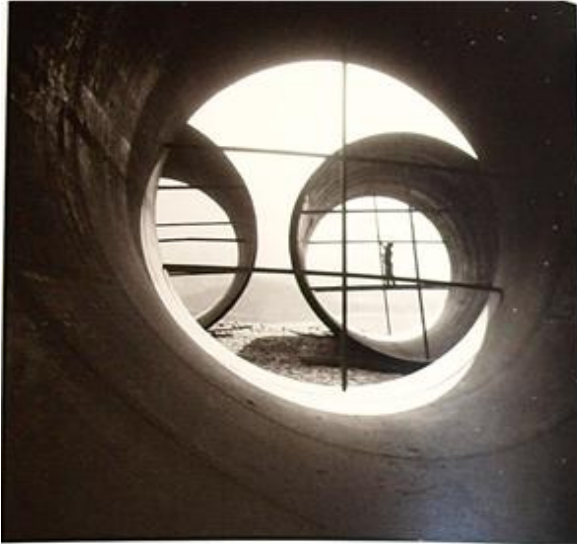
Εικόνα 161. Υδροηλεκτρικός σταθμός Κρεμαστών. Αχελώος, 1964. Φωτογραφικό αρχείο ΔΕΗ.
