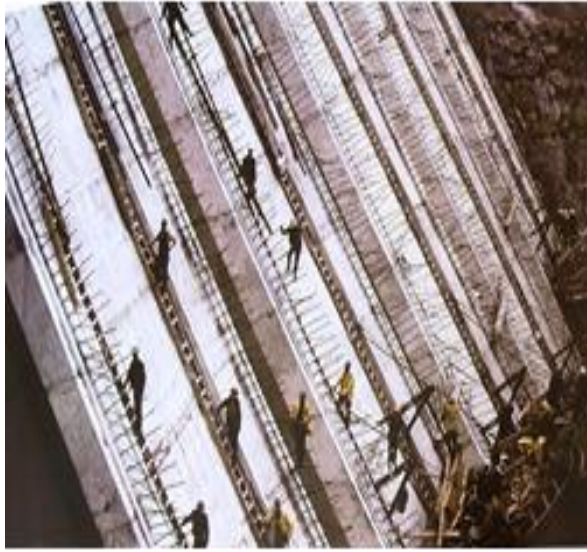
Εικόνα 165. Κατασκευή του φράγματος Κρεμαστόν στον Αχελώο. 1965. Φωτογραφία Κώστας Μπαλάφας.
