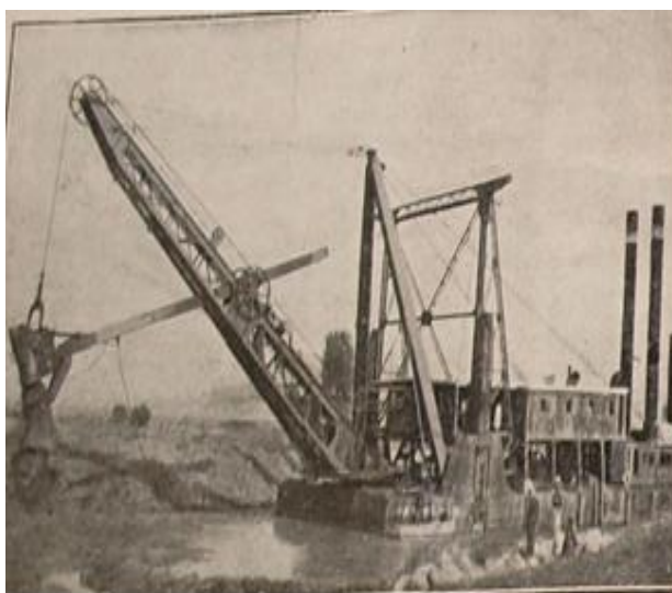
Εικόνα 281. Τα υδραυλικά έργα Σερρών και Δράμας. Πλωτή κοχλιάρα. 1 Φεβρουαρίου 1932.
