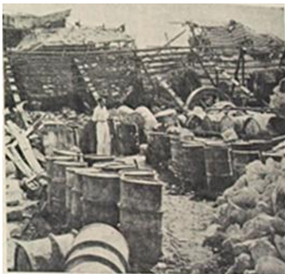
Εικόνα 382. Ότι απέμεινε από το εργοστάσιο ηλεκτροπαραγωγής της ελληνικής ηλεκτρικής εταιρείας στην Ζάκυνθο. Σεπτέμβριος 1953.
