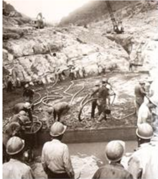
Εικόνα 156. Υδροηλεκτρικός σταθμός Κρεμαστών, Αχελώος, 1964. Φωτογραφικό Αρχείο ΔΕΗ.
