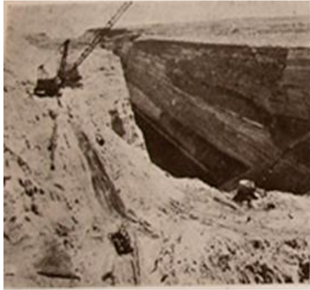
Εικόνα 334. Διώρυξ Κορίνθου. Εργασία εις την κατάπτωση Ποσειδωνίας. Απρίλιος 1949.
