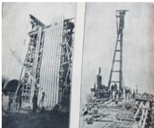
Εικόνα 201. Ικρίωμα κατασκευής και καραβιβάσεως πασάλου. // ατμοκίνητος ανύψωση χαλυβδοσωλήνα. Ιούλιος 1910.
