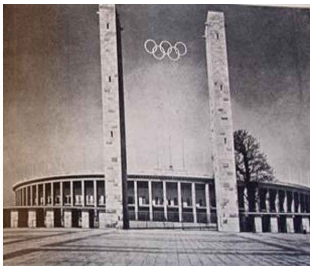
Εικόνα 311. Το Ολυμπιακό Αθλητικό Συγκρότημα εν Βερολίνω. Είσοδος του μεγάλου σταδίου δια πλατείας πλάτους 500 μ. 1 Σεπτεμβρίου 1936.
