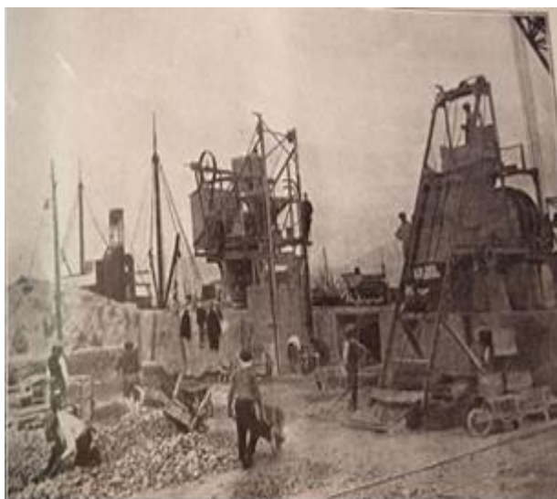
Εικόνα 285. Λιμενικά έργα Πατρών. Συνεργείο τεχνητών ογκολίθων. Αναμικτήρες σκυροκονιάματος. 15 Μαρτίου 1932.
