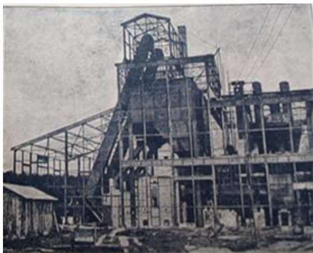
Εικόνα 251. Το εργοστάσιο αποστάξεως λιγνίτου εν Lalouque. Το ξηραντήριο κατά την κατασκευή του. 15 Ιανουαρίου 1928.
