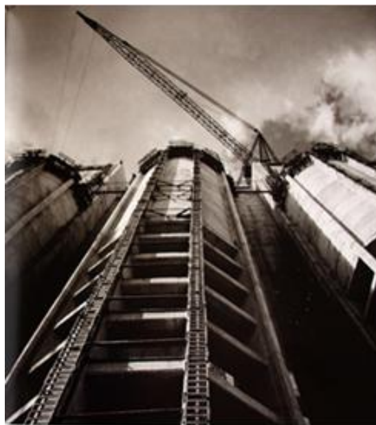
Εικόνα 148. Υδροηλεκτρικός Σταθμός Κρεμαστών. Αχελώος 1964. Φωτογραφικό αρχείο ΔΕΗ.
