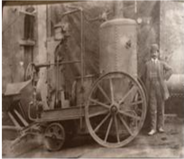
Εικόνα 133β. Ο μηχανικός Αχιλλέας Κούπας ποζάρει δίπλα σε φορητή αντλία οίνου κατασκευασμένη στο μηχανουργείο του. Πειραιάς, περίπου 1900. Φωτογράφος άγνωστος.
