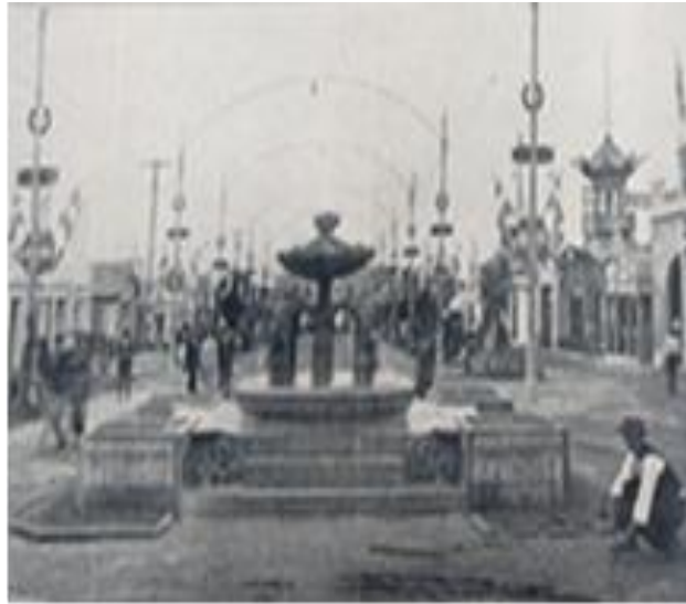
Εικόνα 179. V Διεθνής Έκθεση Θεσσαλονίκης. Μια άποψη της κεντρικής λεωφόρου εις το μέσο της οποίας εγκατεστάθη ωραίο αναβρυτήριο υπό της Γενικής Εταιρείας Τσιμέντων. Περιοδικό Έργα. 15 Σεπτεμβρίου 1930.
