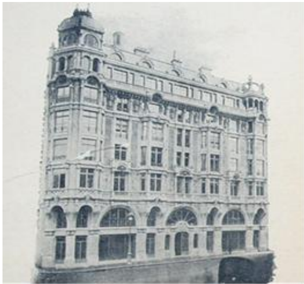
Εικόνα 184. Οικία ενδεκαόροφος εν Παρισίους, του Hennebique κατασκευασθείσα ολόκληρος δια σκυροκονιάματος σιδηροπαγούς. Ιανουάριος 1903.
