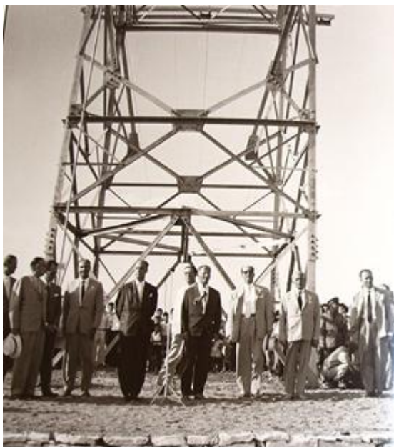
Εικόνα 157. Ατμοηλεκτρικός σταθμός Πτολεμαΐδας. Επίσκεψη επισήμων. 1954. Φωτογραφικό αρχείο ΔΕΗ.
