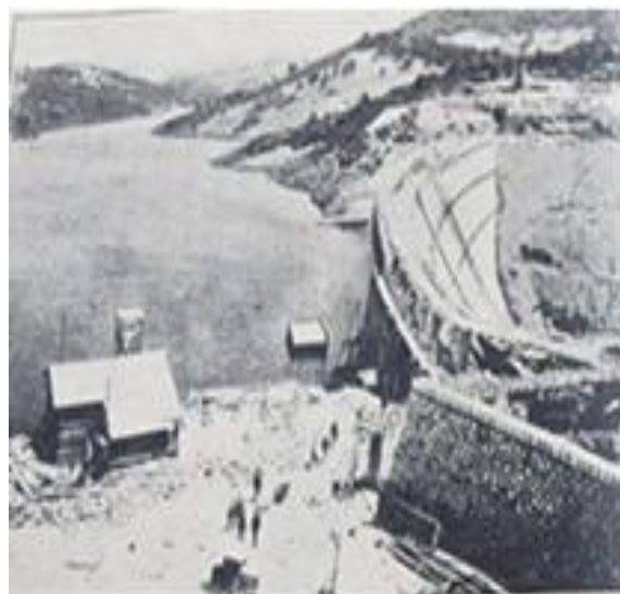
Εικόνα 10. Το φράγμα του Μαραθώνα. Περιοδικό Έργα. 15 Ιουνίου 1929.
