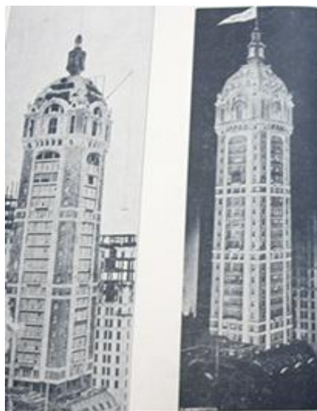
Εικόνα 253. Ο πύργος Singer κατά την αποπεράτωση. Ο πύργος Singer φωτιζόμενος την νύκτα. 29 Φεβρουαρίου 1928.
