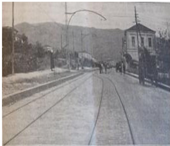
Εικόνα 280. Γρανιτοασφαλτικό οδόστρωμα μετά ασφαλτοπλίνθων παρά τας τροχιοδρομικές γραμμάς οδού Αριστομένους-Καλαμών. 15 Μαΐου 1932.
