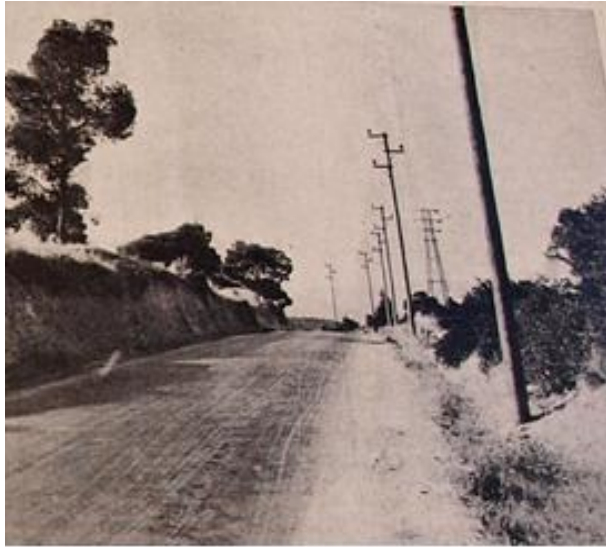
Εικόνα 288. Προσωρινή γραμμή ηλεκτρικού δικτύου παρά την θέση Γέρακας, 15 Ιανουαρίου 1933.
