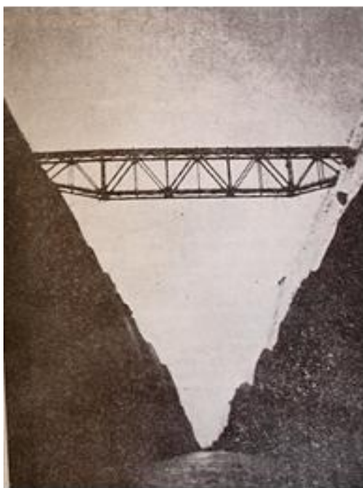
Εικόνα 335. Η νέα σιδηροδρομική γέφυρα του Ισθμού της Κορίνθου. Ιούνιος 1949.
