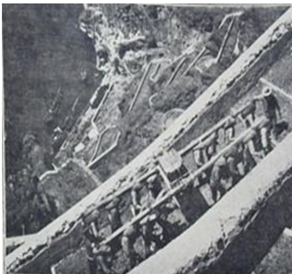
Εικόνα 264. Ανύψωσης μηχανήματος βάρους 1500 χιλιόγραμμων δια εργατών. Οδός από παραλίας εις Φηρά Θήρας. 30 Ιουλίου 1929.
