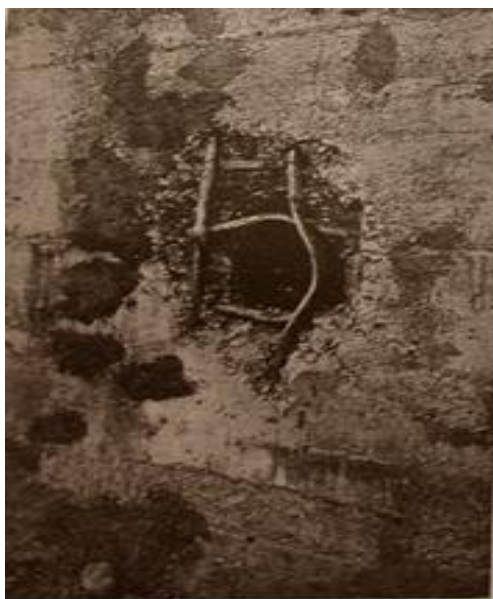
Εικόνα 320. Οπή διατρήσεως πλακός οπλισμένου σκυροδέματος υπό βόμβας 100 χλγ. 15 Νοεμβρίου 1-15 Δεκεμβρίου 1940.
