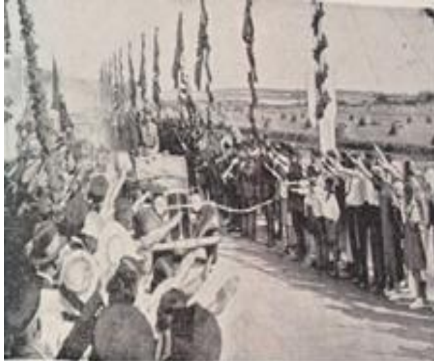
Εικόνα 362. Το συνδέον την ανατολική ακτή του Σλέσβιγκ με την νήσο Νόρδστρανν φράγμα μήκους σχεδόν τριών χιλιομέτρων αποπερατώθη ήδη. Ιούλιος 1937.
