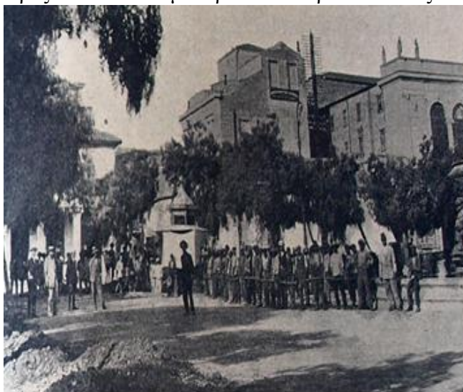
Εικόνα 245. Τοποθέτηση υπογείου καλωδίου υψηλής τάσεως επί της πλατείας Γεωργίου. 30 Μαΐου 1927.
