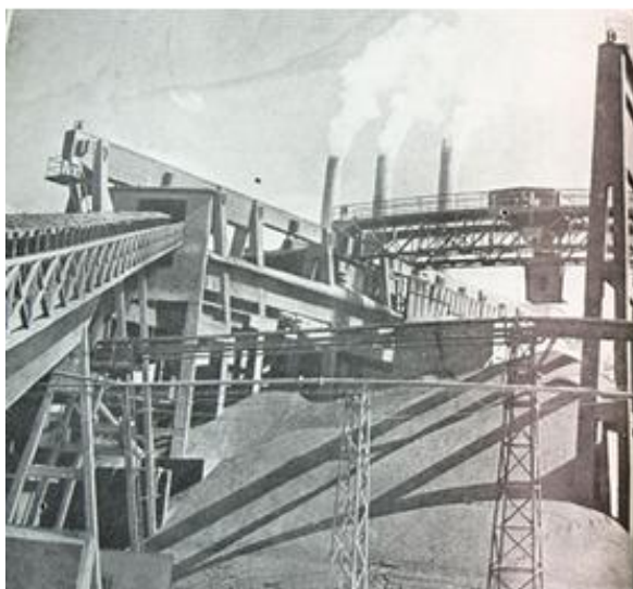
Εικόνα 385. Εισ την ανώνυμον εταιρεία τσιμέντων ο ο Τιτάν . Αποθήκη των πρώτων υλών παραγωγής του τσιμέντου και μεταφορά αυτών εις τους περιστροφικούς κλιβάνους όπου γίνεται η παραγωγική των επεξεργασία. Νοέμβριος 1956.
