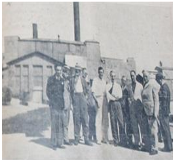
Εικόνα 216. Εργοστάσιο τσιμέντων Χαλκίδας. Μάρτιος 1937.
