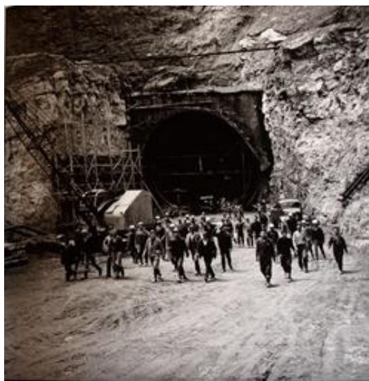
Εικόνα 16β. Υδροηλεκτρικός Σταθμός Αχελώου. 1963. Φωτογραφικό αρχείο ΔΕΗ.
