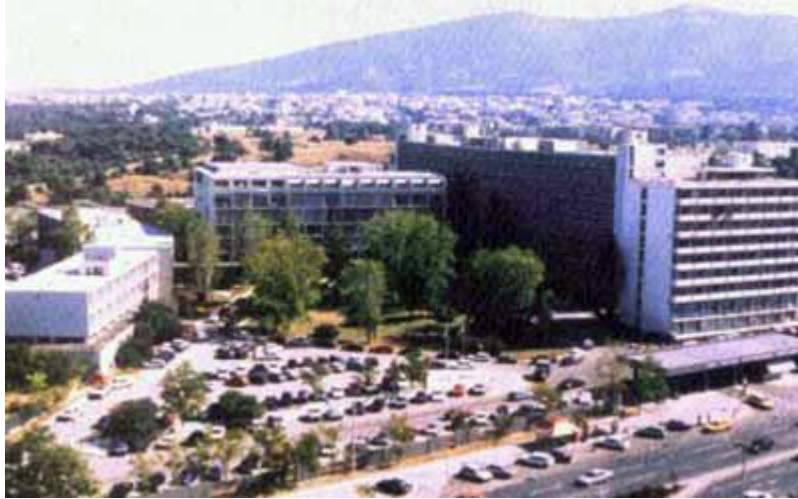
Εικόνα 10. 251 Γενικό Νοσοκομείο Αεροπορίας
