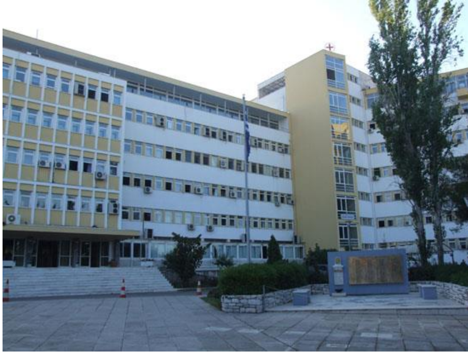
Εικόνα 4.. Το κτίριο του 401 ΓΣΝΑ στη σημερινή του μορφή.
