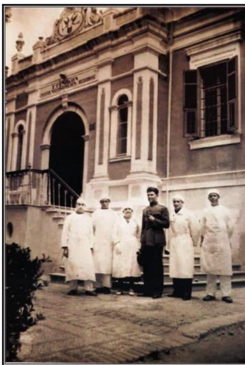
Εικόνα 6. Το πρώτο κτίριο του 424 ΓΣΝΕ
