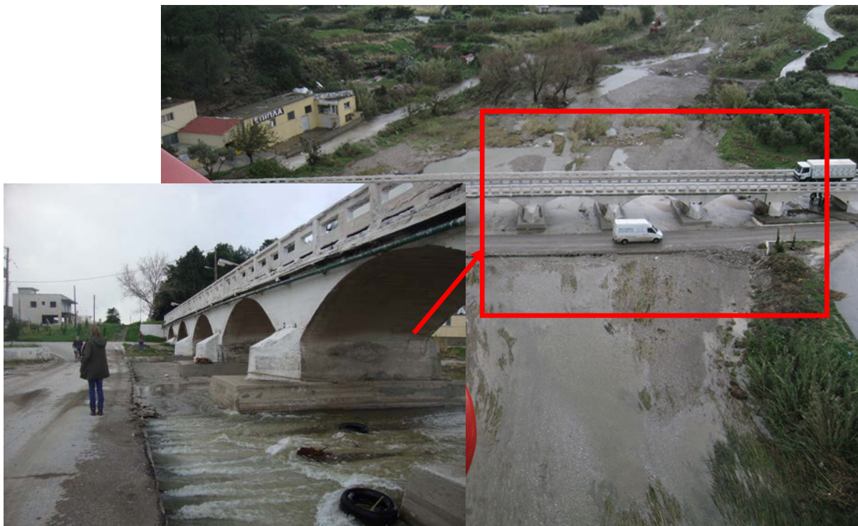
Εικ. 6. 7 Ιρλανδική διάβαση του ρέματος της Κρεμαστής μετά την πλημμύρα του Νοεμβρίου 2013.
