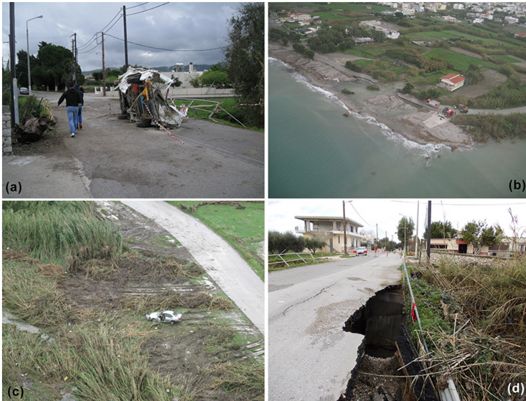
Εικ. 6. 19 Επιπτώσεις από την πλημμύρα της 22ας Νοεμβρίου 2013 στην υδρολογική λεκάνη της Κρεμαστής.
