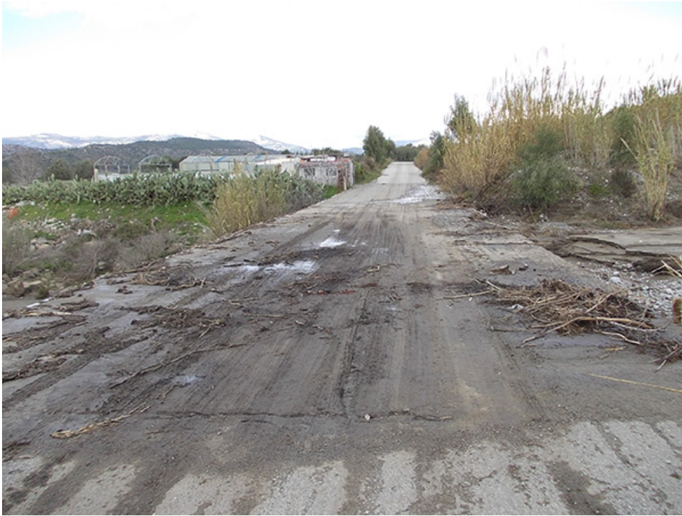
Εικ. 6. 6 Ιρλανδική διάβαση από την περιοχή της Απολακκιάς στο νότιο τμήμα του νησιού. Τα ίχνη θραυσμάτων βλάστησης και εδαφικού υλικού (debris) δείχνουν πως η συγκεκριμένη υποδομή καταλήφθηκε από πλημμυρικά ύδατα.
