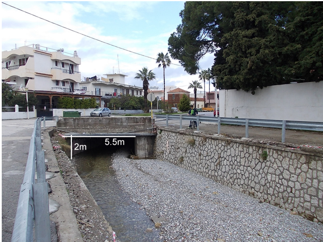
Εικ. 6. 21 Διατομή στην είσοδο του πλακοσκεπούς αγωγού.
