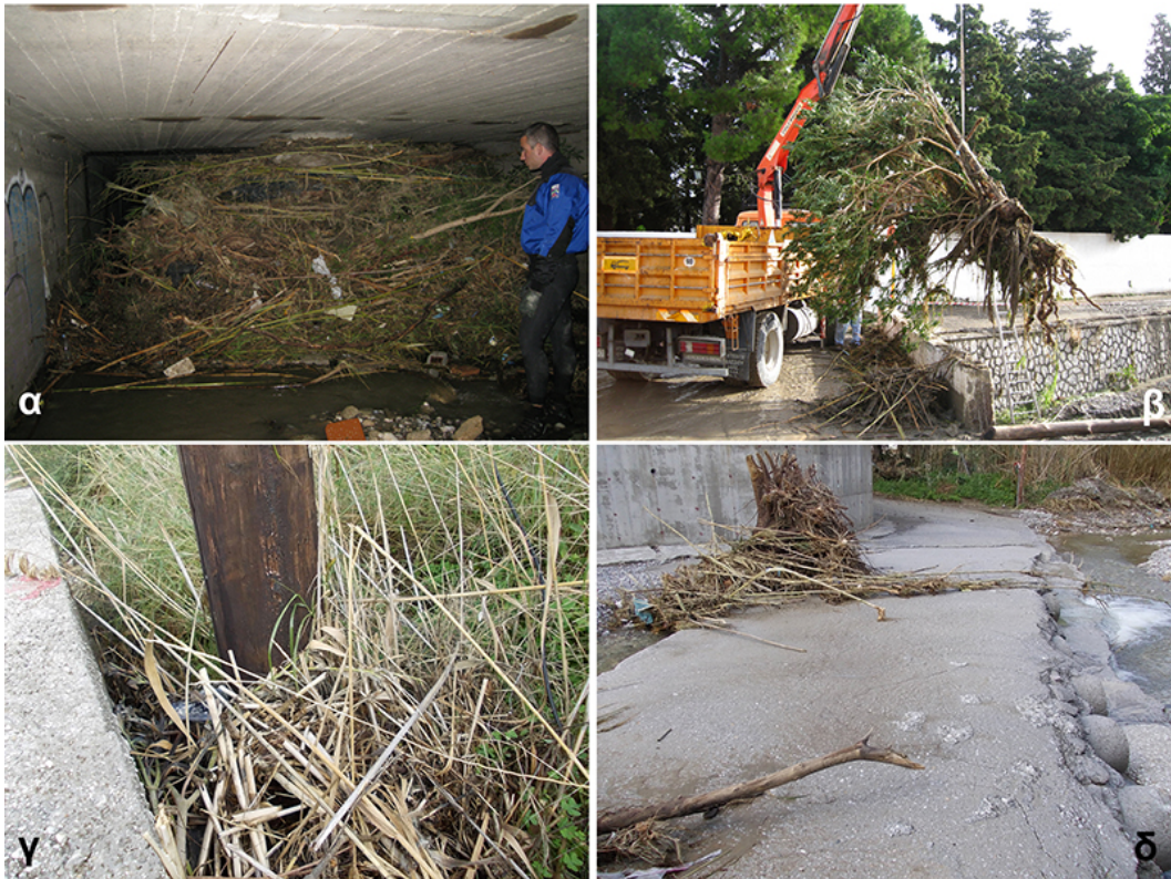
Εικ. 4. 7 Θραύσματα βλάστησης παγιδευμένα σε τμήματα του υδρογραφικού δικτύου μετά από την πλημμύρα του Νοεμβρίου 2013 στην περιοχή της Ιαλυσού και της Κρεμαστής.
