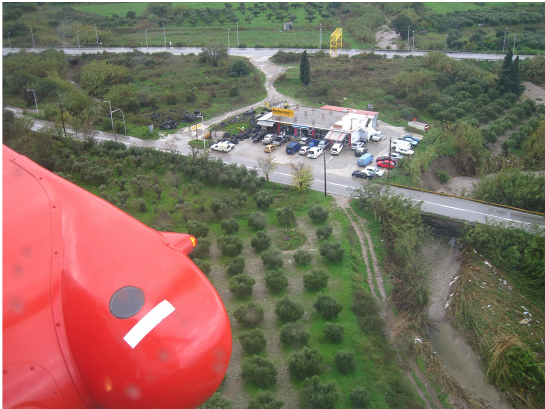
Εικ. 6. 2 Μια από τις γέφυρες στην υδρολογική λεκάνη της Κρεμαστής η οποία υπέστη κατάκλυση κατά τη διάρκεια της πλημμύρας του Νοεμβρίου 2013, χωρίς να παρουσιάσει υλικές ζημιές σε κάποιο από τα τμήματά της.
