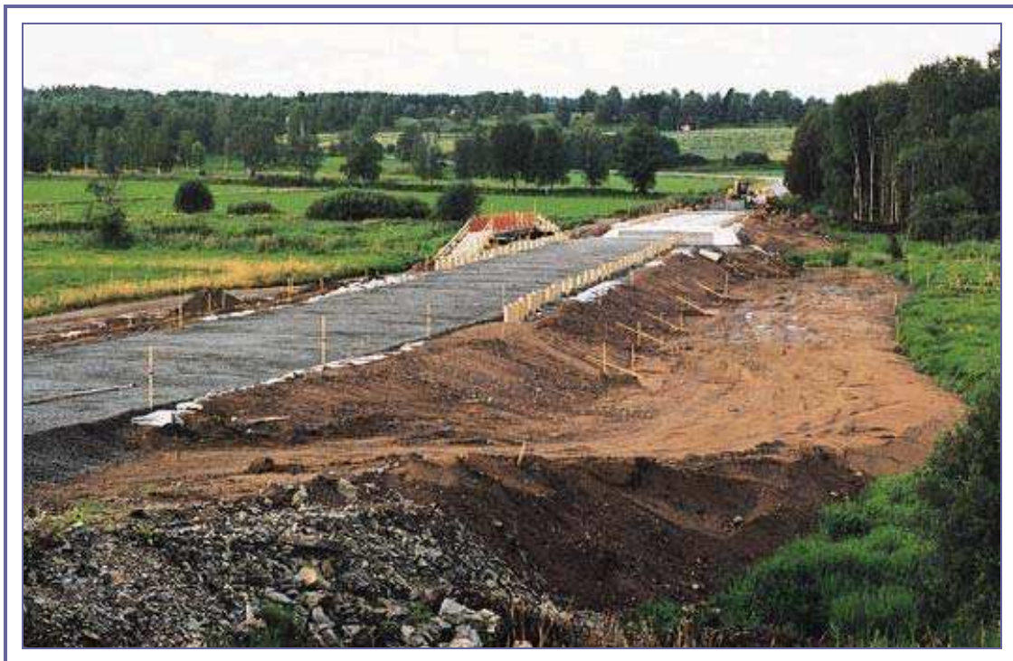
Εικόνα 8.4: Ελαφροβαρή αδρανή μειώνουν τις μηχανικές πιέσεις από τα διακινούμενα φορτία σε γέφυρες, δρόμους και σιδηρόδρομους (MAXIT Group AB).
