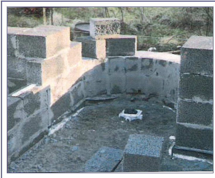
Εικόνα 8.9: Χρήση ελαφροβαρών αδρανών (LWA) σε εσωτερικούς και εξωτερικούς τοίχους (MAXIT Group AB).
