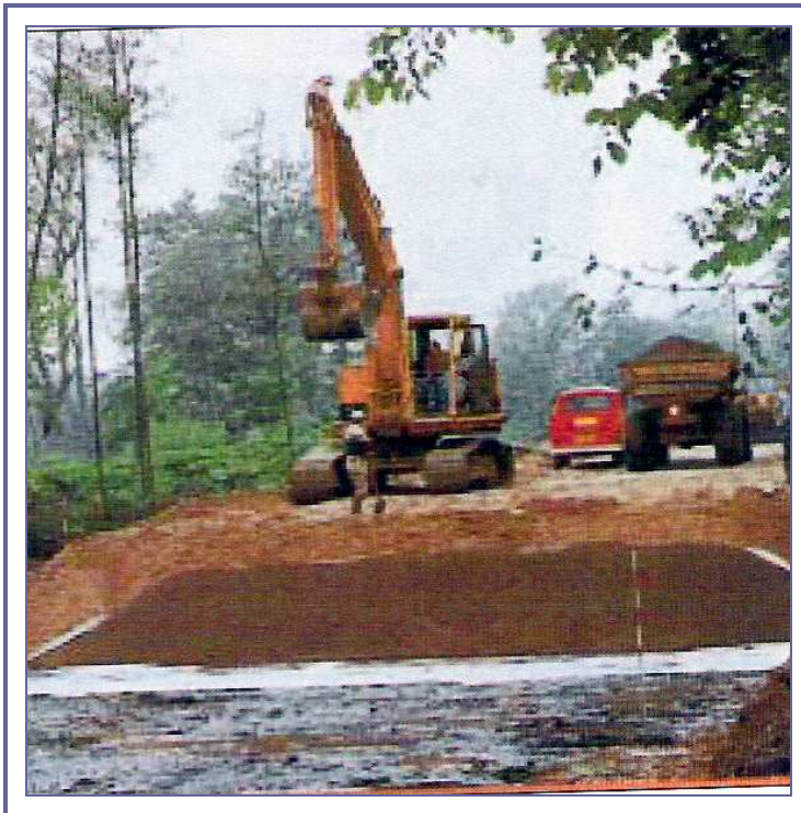
Εικόνα 8.8: Χρήση ελαφροβαρών αδρανών (LWA) ως πληρωτικό υλικό (MAXIT Group AB).
