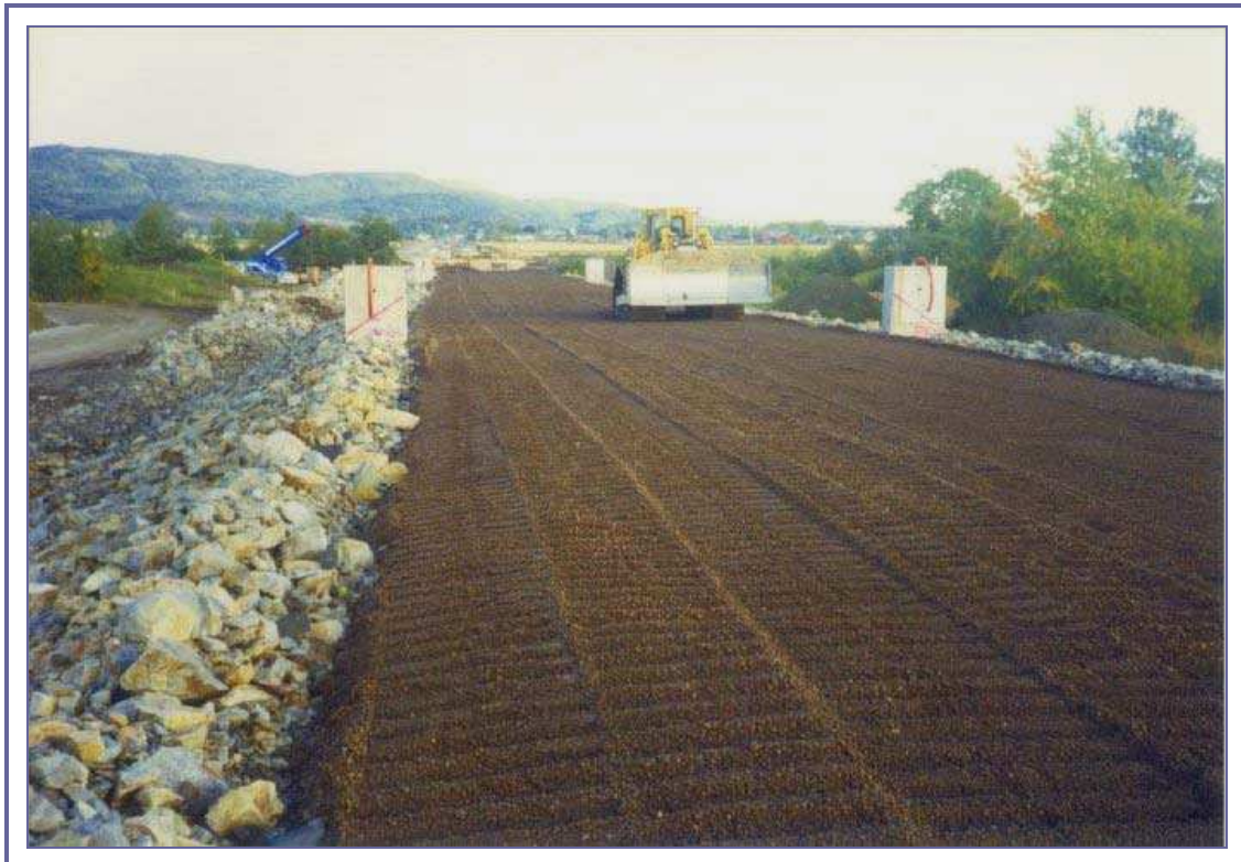
Εικόνα 8.1: Χρήση ελαφροβαρών αδρανών σε σιδηρόδρομους στην Νορβηγία για να αποτραπεί η διείδυση παγετού (MAXIT Group AB).
