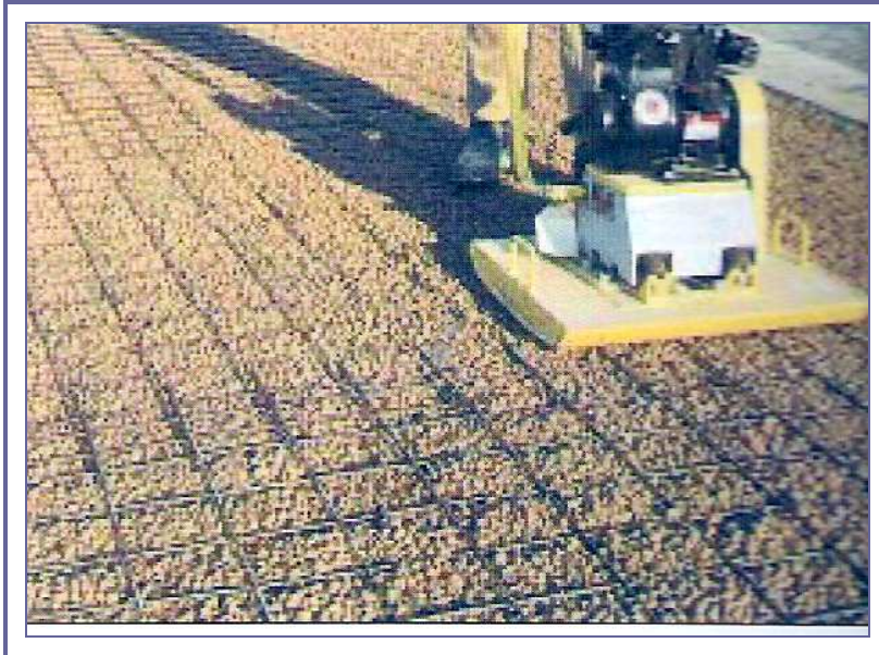
Εικόνα 8.5: Ελαφροβαρή αδρανή σε δάπεδα. Λειτουργούν ως θερμομονωτικά και μονωτικά από το νερό (MAXIT Group AB).
