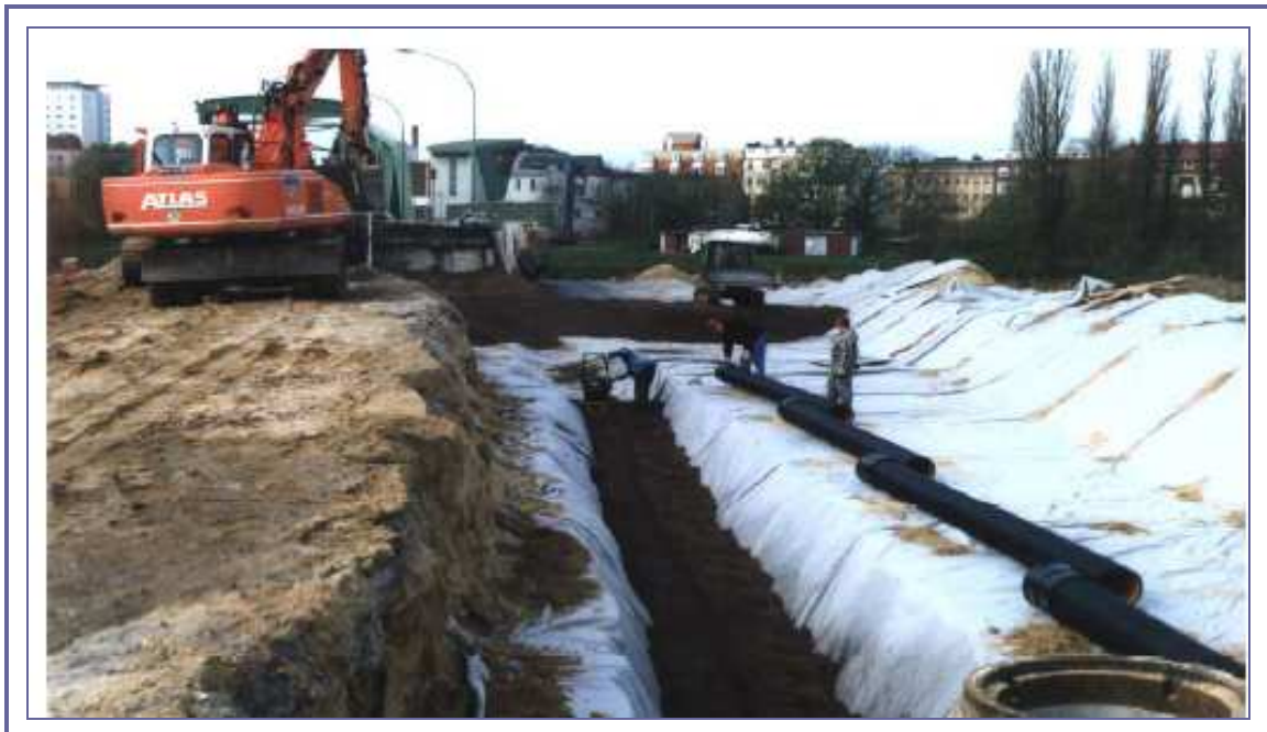
Εικόνα 8.3: Ελαφροβαρή αδρανή σε αποχετευτικά συστήματα (MAXIT Group AB).
