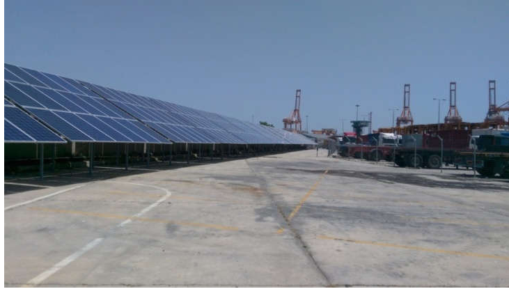
Σχήμα 3.25.: Εικόνα Εγκατάστασης του Φωτοβολταϊκού Σταθμού στο χώρο της ΡCT.
