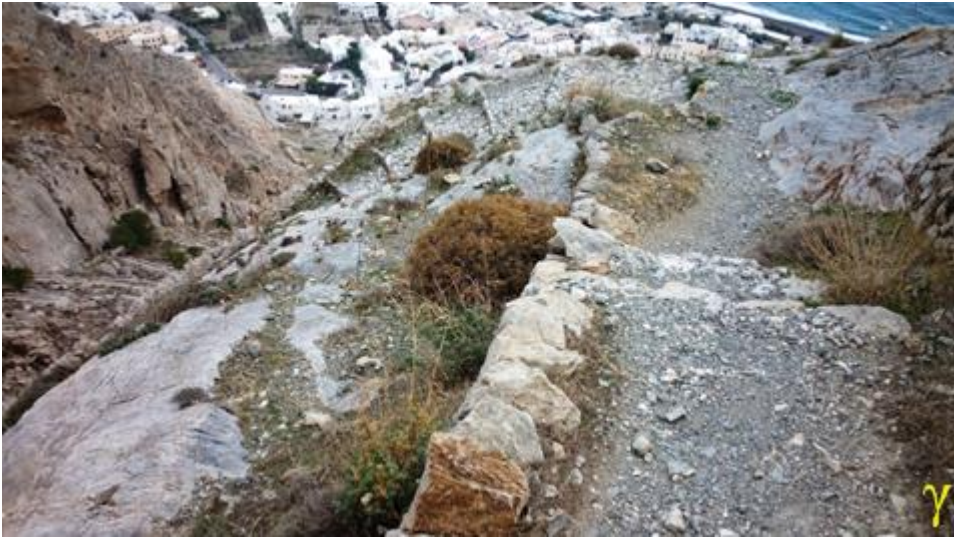
Εικόνα 44: α), β) Σημεία πιθανής ολίσθησης λόγω αποθέσεων του υποβάθρου, γ) σημεία αυξημένης κλίσης.
