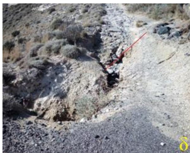
Εικόνα 48: α), β), γ) Σημεία πιθανής ολίσθησης λόγω πυροκλαστικών αποθέσεων και λαβών, δ) σημεία διάβρωσης του μονοπατιού.
