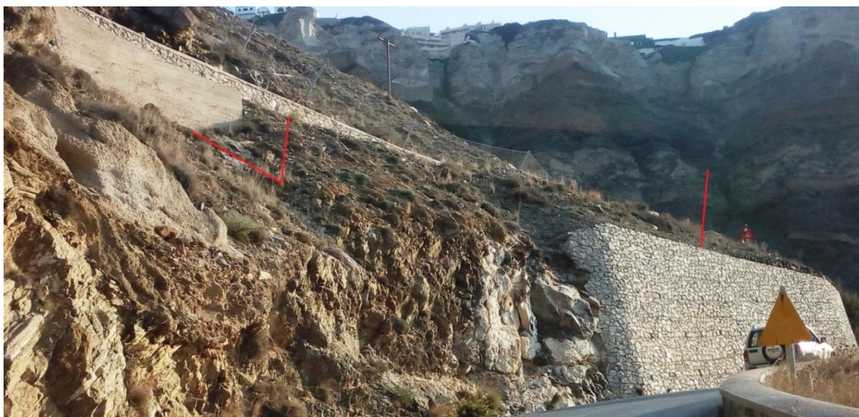
Εικόνα 27: Τοιχία αντιστήριξης ως έργα πρόληψης και αντιμετώπισης κατολισθητικών φαινομένων.
