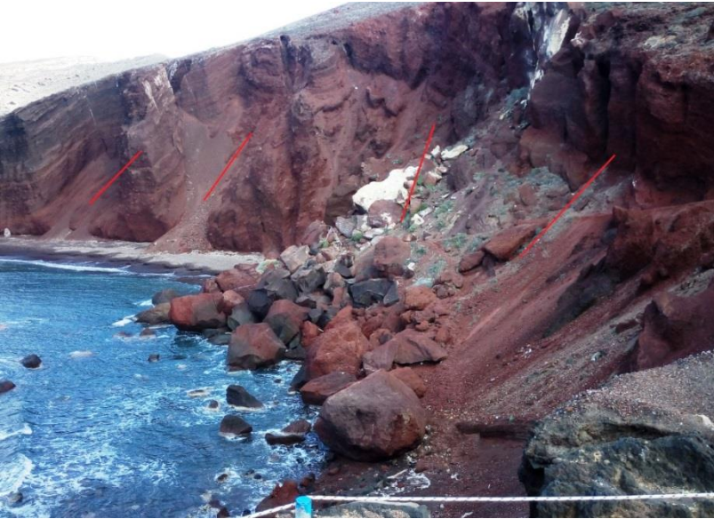
Εικόνα 43: Προηγούμενες κατολισθήσεις στο παραλιακό τμήμα.
