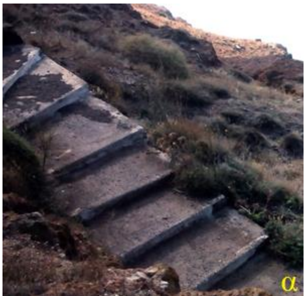
Εικόνα 31: α), β) Σημεία πιθανής ολίσθησης λόγω πυροκλαστικών αποθέσεων και λαβών.
