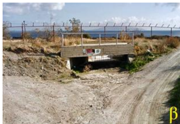
Εικόνα 53: α), β) Τεχνικά έργα στη διαδρομή του βρόχινου νερού από το φαράγγι του Βόθωνα (γέφυρα - αντιπλημμυρικό έργο κάτω από την επαρχιακή οδό Μεσσαριάς - Αρχαίας Θήρας) προς την παραλία Καμαριού (αντιπλημμυρικό κανάλι) κατά το 2011 35 .
