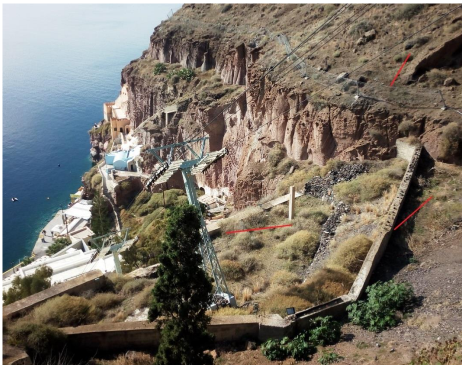
Εικόνα 33: Τοιχεία και δίκτυα αντιστήριξης ως έργα πρόληψης και αντιμετώπισης κατολισθητικών φαινομένων.
