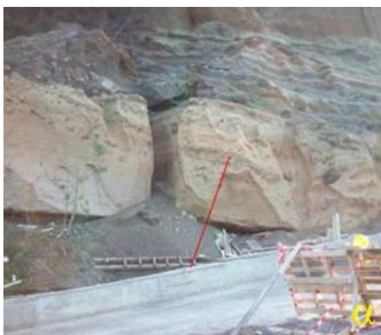
Εικόνα 39: α) Τοιχίο συγκράτησης κορημάτων που έχουν διαβρωθεί, β) αγωγός έκχυσης υγρών αποβλήτων στην παραλία.
