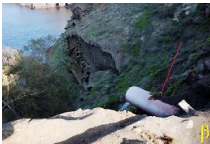
Εικόνα 39: α) Τοιχίο συγκράτησης κορημάτων που έχουν διαβρωθεί, β) αγωγός έκχυσης υγρών αποβλήτων στην παραλία.
