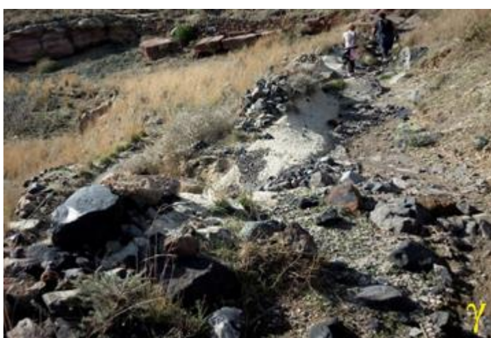
Εικόνα 48: α), β), γ) Σημεία πιθανής ολίσθησης λόγω πυροκλαστικών αποθέσεων και λαβών, δ) σημεία διάβρωσης του μονοπατιού.
