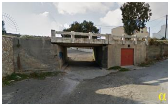
Εικόνα 53: α), β) Τεχνικά έργα στη διαδρομή του βρόχινου νερού από το φαράγγι του Βόθωνα (γέφυρα - αντιπλημμυρικό έργο κάτω από την επαρχιακή οδό Μεσσαριάς - Αρχαίας Θήρας) προς την παραλία Καμαριού (αντιπλημμυρικό κανάλι) κατά το 2011 35 .
