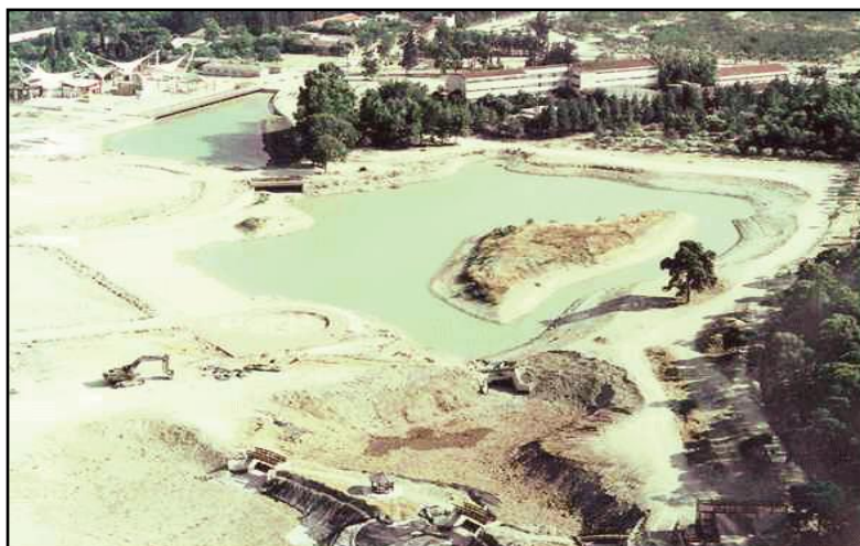
Εικόνα 7: Φωτογραφίες από την κατασκευή του Πάρκου «Α. Τρίτσης» και των τεχνητών λιμνών
