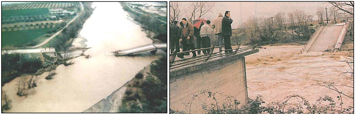
Εικόνες 3.4 & 3.5: Η πτώση της γέφυρας του Σπερχειού στη θέση Λουτρά Υπάτης κατά την μεγάλη πλημμύρα του 1997 (Πηγή: URL 3.1) - ΤΑ ΝΕΑ, 15/1/1997, σελ.17, Αρχείο ΚΕΡΕΑ).
