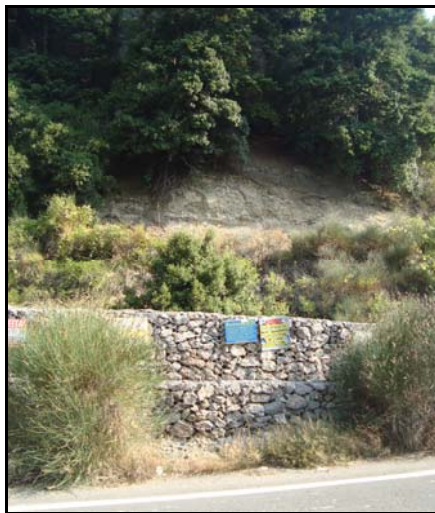
Εικόνες 5.21 & 5.22: Αριστερά, κατολίσθηση πρανούς έξω από τη Παύλιανη και τοιχίο ανάσχεσης του φαινομένου. Δεξιά, Εκτεταμένη κατολίσθηση στο οδικό δίκτυο έξω από την Οίτη. Διαφάνεται η κεφαλή της τοξοειδούς θραύσης.
