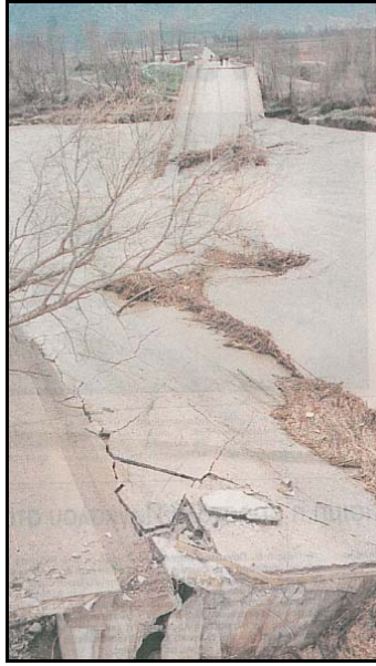
Εικόνες 3.6 & 3.7: Η γέφυρα παλαιάς εθνικής οδού Λαμίας – Καρπενησίου – Υπάτης η οποία καταστράφηκε ολοκληρωτικά από τη πλημμύρα Ιανουαρίου του 1997 (Πηγή: ΕΛΕΥΘΕΡΟΤΥΠΙΑ, 15/1/1997, σελ.16-17, Αρχείο ΚΕΡΕΑ).
