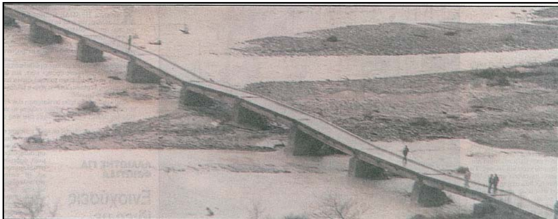
Εικόνα 3.8: Ζημίες στη γέφυρα της Αλαμάνας (Πηγή: Ελευθεροτυπία Φύλλο 15/1/1997, σελ.16-17, Αρχείο ΚΕΡΕΑ)
