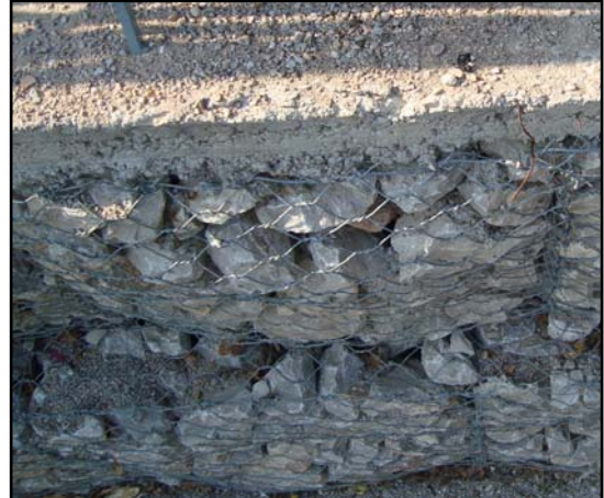
Εικόνες 5.19 & 5.20: Κατολίσθηση στον κοινοτικό χώρο της Άνω Παύλιανης, Αριστερά η θέση που έλαβε χώρα. Δεξιά, έργο ενίσχυσης και αποστράγγισης της πλατείας με υδροπερατά συρματοκιβώτια.
