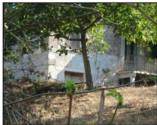
Εικόνες 5.23 & 5.24: Ρωγμή σε παλαιά κατοικία στον Σκαμνό, αποτέλεσμα κατολίσθησης τοπικής κλίμακας.
