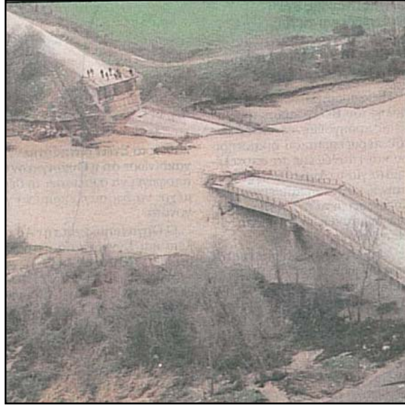
Εικόνες 3.6 & 3.7: Η γέφυρα παλαιάς εθνικής οδού Λαμίας – Καρπενησίου – Υπάτης η οποία καταστράφηκε ολοκληρωτικά από τη πλημμύρα Ιανουαρίου του 1997 (Πηγή: ΕΛΕΥΘΕΡΟΤΥΠΙΑ, 15/1/1997, σελ.16-17, Αρχείο ΚΕΡΕΑ).
