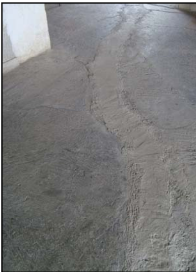
Εικόνες 5.27, 5.28 & 5.29: Ρωγμές στο δάπεδο και την τοιχοποιία σε οικία και ρωγμές στο τοιχίο αρκετά μέτρα κατάντη αυτής λόγω ερπυστικών φαινομένων στην Υπάτη.
