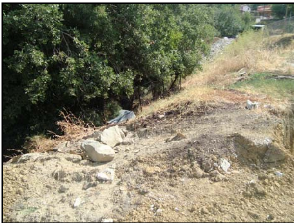
Εικόνες 5.32 & 5.33: Δεξιά, κατολίσθηση στο πρηνές ρέματος που διασχίζει το Μεσοχώρι, και αριστερά εδαφική θραύση πρηνούς στο οδικό δίκτυο αυτού.
