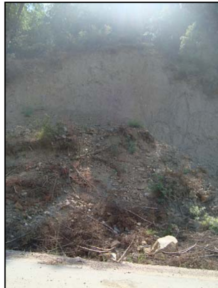
Εικόνες 5.32 & 5.33: Δεξιά, κατολίσθηση στο πρηνές ρέματος που διασχίζει το Μεσοχώρι, και αριστερά εδαφική θραύση πρηνούς στο οδικό δίκτυο αυτού.
