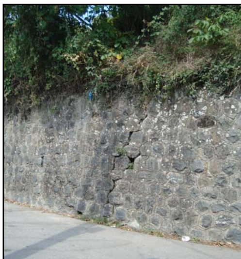
Εικόνες 5.30 & 5.31: Αριστερά, ρωγμές σε τοιχίο στον Πύργο Υπάτης. Δεξιά, κατολίσθηση στο οδικό δίκτυο έξω από το Περιστέρι.
