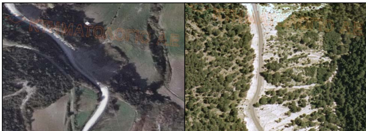
Εικόνες 5.33 & 5.34: Αριστερά, κατολίθωση στο οδικό δίκτυο Άγναντης – Αγίου Κωνσταντίνου. Δεξιά, κατολίθωση στο οδικό δίκτυο Τιθορέας - Παρνασσού (Πηγή: Κτηματολόγιο Α.Ε.).
