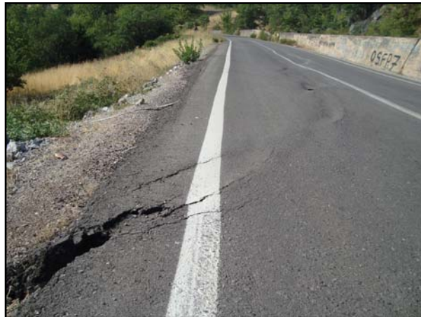
Εικόνες 5.21 & 5.22: Αριστερά, κατολίσθηση πρανούς έξω από τη Παύλιανη και τοιχίο ανάσχεσης του φαινομένου. Δεξιά, Εκτεταμένη κατολίσθηση στο οδικό δίκτυο έξω από την Οίτη. Διαφάνεται η κεφαλή της τοξοειδούς θραύσης.
