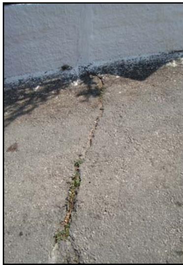
Εικόνες 5.27, 5.28 & 5.29: Ρωγμές στο δάπεδο και την τοιχοποιία σε οικία και ρωγμές στο τοιχίο αρκετά μέτρα κατάντη αυτής λόγω ερπυστικών φαινομένων στην Υπάτη.
