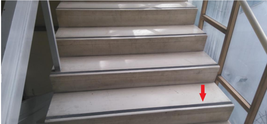
Εικόνα 6-2 Σκαλοπάτια κλιμακοστασίου με την προβλεπόμενη αντιολισθητική λωρίδα
