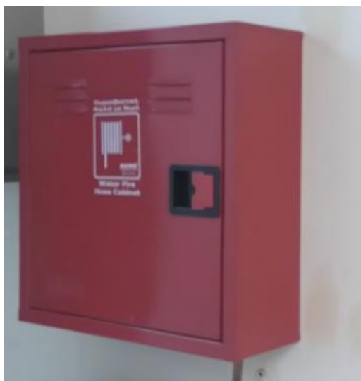
Εικόνα 6-4 Τα μέσα πυρόσβεσης στους ορόφους του κτηρίου στη Χρ. Λαδά 6 είναι φορητοί πυροσβεστήρες και πυροσβεστικές φωλιές
