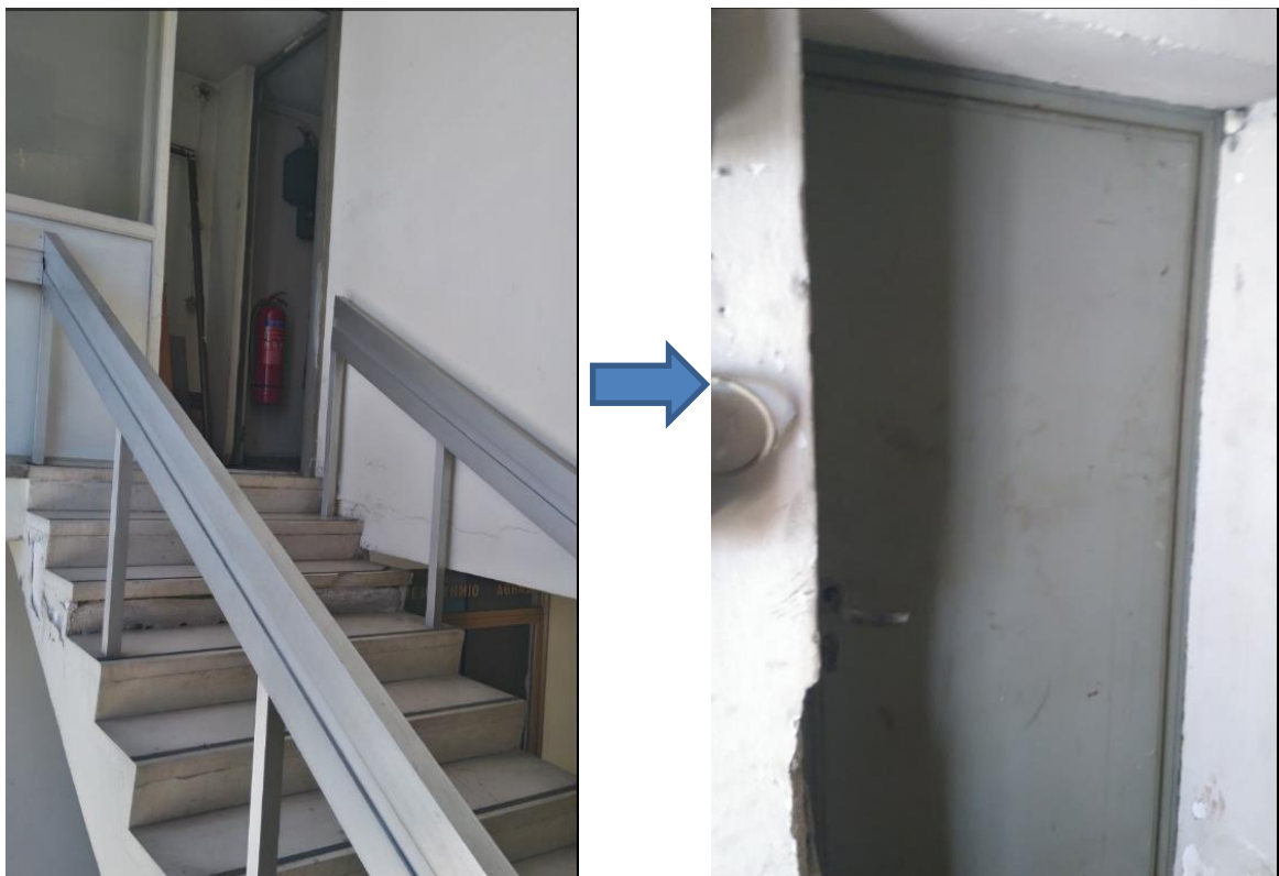
Εικόνα 6-3 Η οδός διαφυγής που οδηγεί στην κλειδωμένη θύρα της ταράτσας
