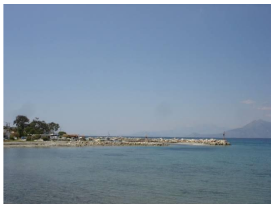
Σχήμα 5.21: Λιμενοβραχίονας - λιμανάκι στο αλεποχώρι (428430, 4215746 el.2m).
