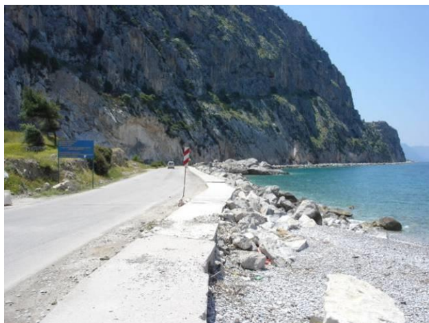
Σχήμα 5.17: Απόρριψη ογκολίθων για διαμόρφωση και προστασία από τη διάβρωση του παραλιακού δρόμου Ψάθας- Αλεποχωρίου.
