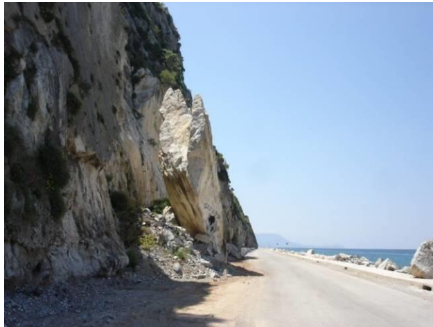
Σχήμα 5.24: Πολύ απότομες κλίσεις - κίνδυνος κατολισθήσεων στον παραλιακό δρόμο Ψάθας- Αλεποχωρίου (429801, 4216323 el.2).
