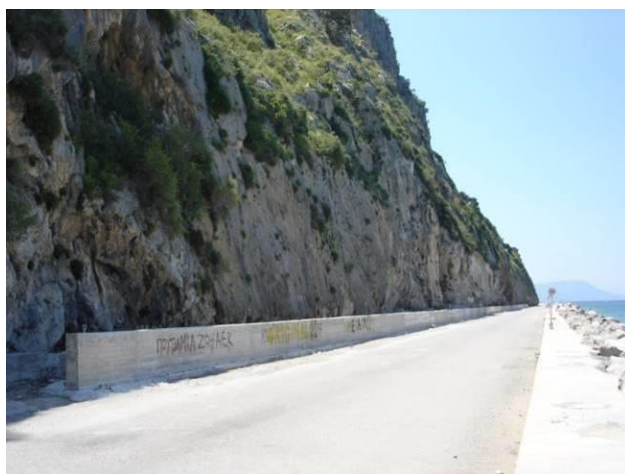
Σχήμα 5.18: Τοιχείο από οπλισμένο σκυρόδεμα για προστασία του δρόμου από κατολισθήσεις ( πλάτος= 30 cm, ύψος= 1,30 m και μήκος = 200 m).
