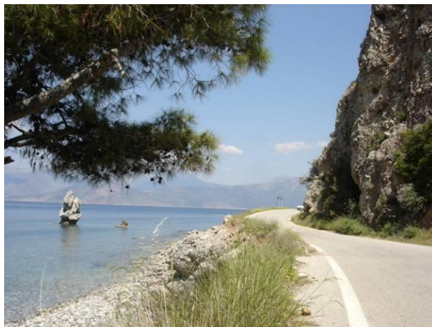
Σχήμα 5.26: Σαθρό έδαφος- κατολισθήσεις. Κατακερματισμένος σχηματισμός που έχει ολισθήσει μέχρι την κάτω πλευρά του δρόμου. Αποτελείται από διαφορετικά τεμάζια κ ίσως να είναι διάπλαση. (423880, 4213110 alt.= 8).
