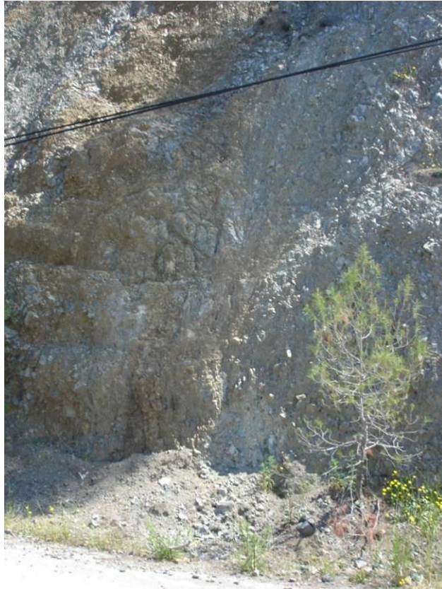
Σχήμα 5.31: Στον δρόμο Βαμβακές – Σχίνος, κίνδυνος κατολισθήσεων. Σύγχρονα πλευρικά κορήματα και κώνοι κορημάτων: ασύνδετα υλικά που αναπτύσσονται στις πλαγιές. (417781, 4211868 alt.=44m)
