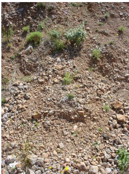
Σχήμα 5.27: Σαθρό έδαφος- κατολισθήσεις. Κατακερματισμένος σχηματισμός που έχει ολισθήσει μέχρι την κάτω πλευρά του δρόμου. Αποτελείται από διαφορετικά τεμάχια. (423880, 4213110 alt.= 8).
