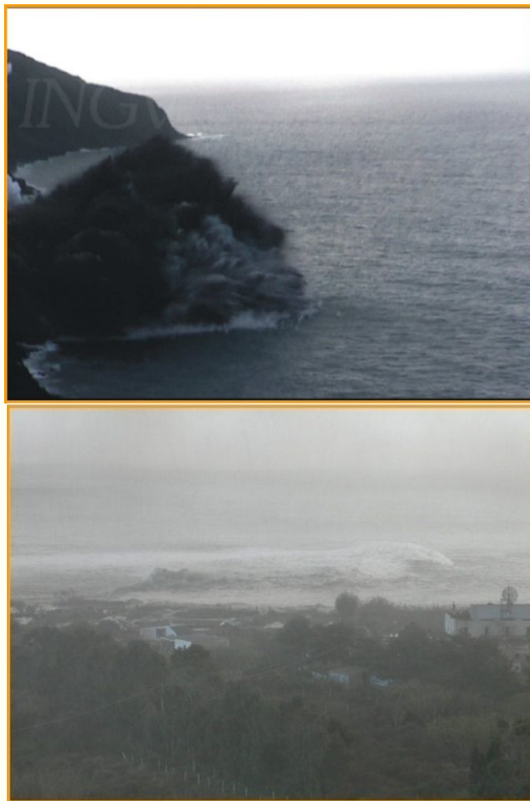
Εικόνα 11.2 – 11.3: Φωτογραφίες από την κατολίσθηση του 2002
