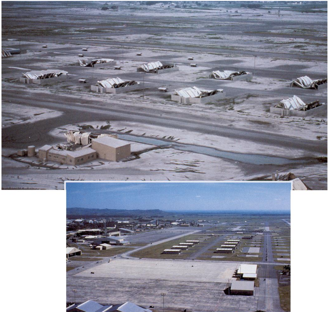
Εικόνα 39. Υπόστεγα στην πολεμική αεροπορική βάση Clark, Philippines, πριν (10 Ιουνίου 1991) και μετά (24 Ιουνίου 1991) από την έκρηξη της 15ης Ιουνίου 1991 (Casadewall, 1993).
