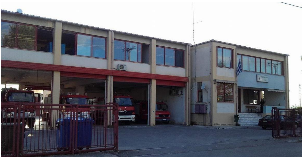
Εικόνα 19. Πυροσβεστική Υπηρεσία Καρδίτσας και χώρος οχημάτων Πηγή : Προσωπικό Αρχείο
