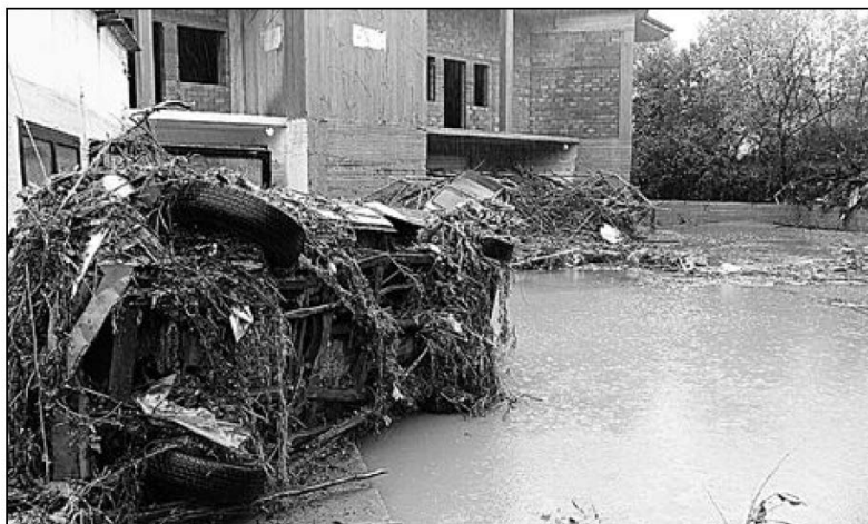
Εικόνα 31. Καταστροφές από την πλημμύρα του Νοεμβρίου 2001 (Πηγή: Εφημερίδα Χαραυγή)
