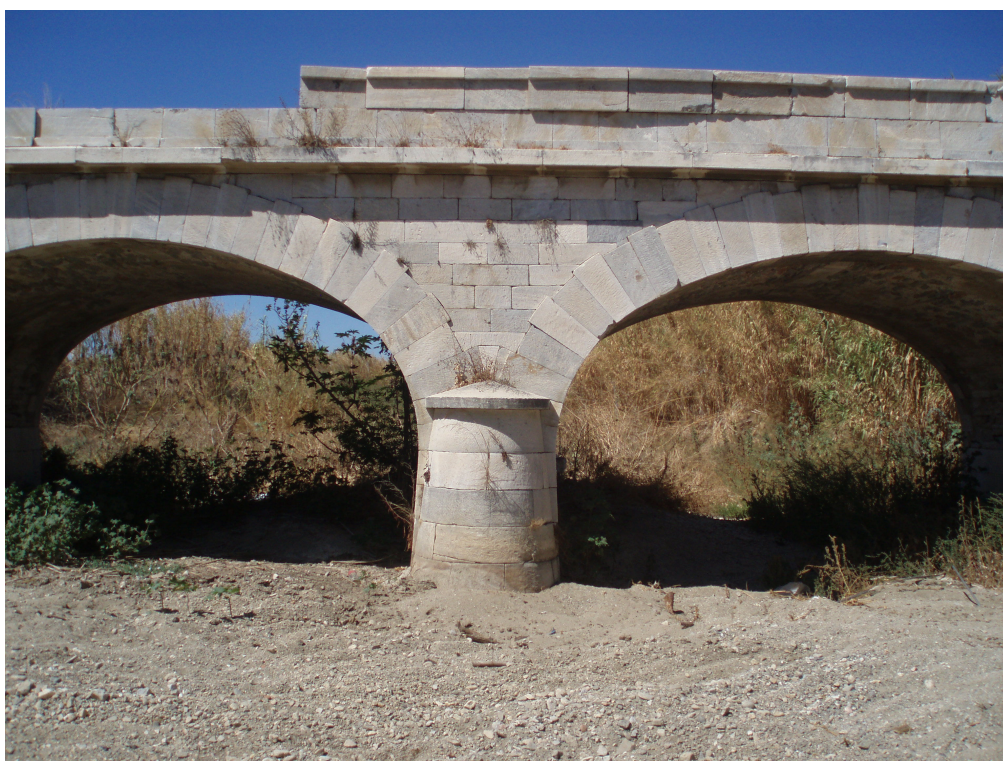
Εικόνα 41. Ανάντη παλαιάς λιθόκτιστης γέφυρας Περίτσι, περιοχή Λιβάδια (2011).
