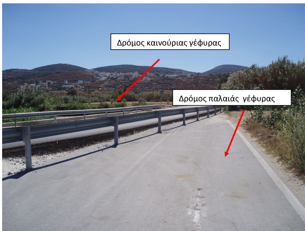
Εικόνα 44. Επαρχιακός δρόμος παλαιάς και καινούριας γέφυρας Περίτσι (2011).
