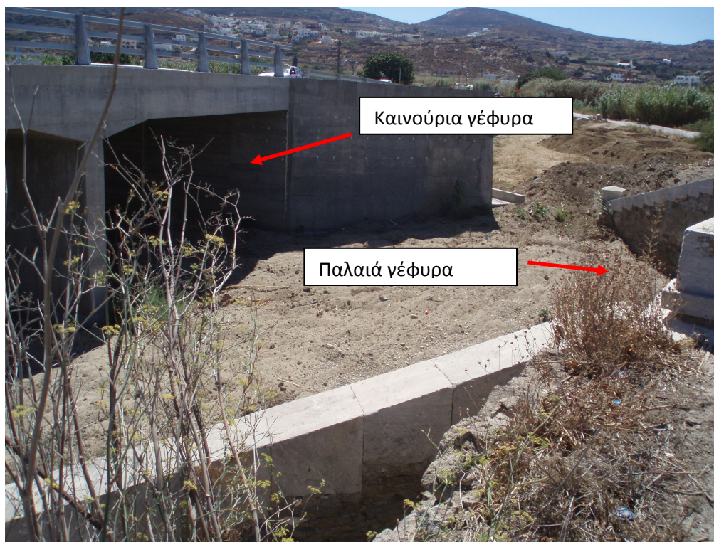
Εικόνα 43. Παλαιά και καινούρια γέφυρα Περίτσι (2011).
