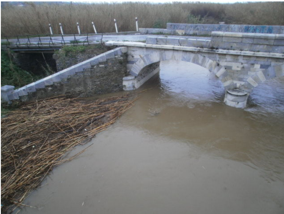
Εικόνα 40. Ανάντη λιθόκτιστης γέφυρας Περίτσι, περιοχή Λειβάδια (2003).
