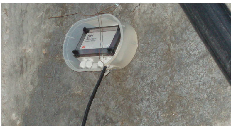
Εικόνα 26. Σημείο πάνω στη γέφυρα όπου τοποθετήθηκε ο μετρητής (2011).
