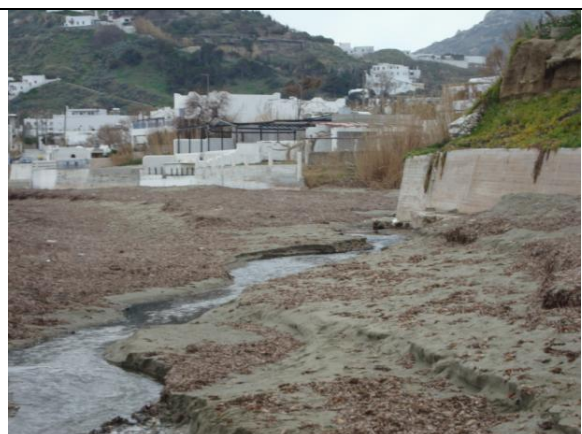
Φωτογραφία 32: Η κοίτη που καταλήγει στην παραλία των Μαγαζιών, όπου φαίνονται και κτίσματα που έχουν χτιστεί παραπλεύρως αυτής
