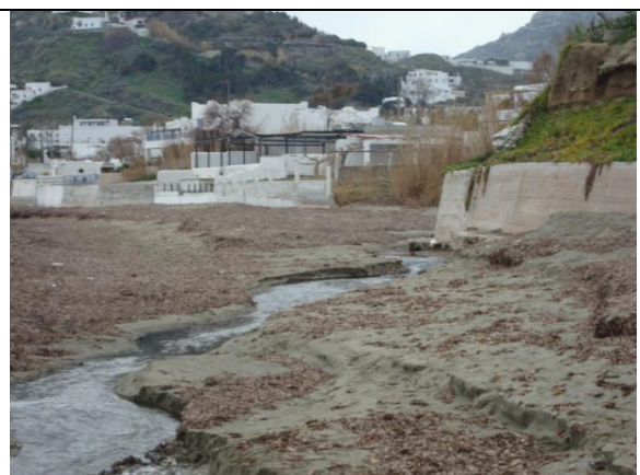
Φωτογραφία 32: Η κοίτη που καταλήγει στην παραλία των Μαγαζιών, όπου φαίνονται και κτίσματα που έχουν χτιστεί παραπλεύρως αυτής
