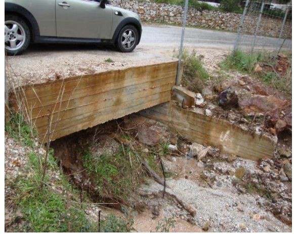
Φωτογραφία 72: Ανθρωπογενής διαμόρφωση για το ρέμα, προκειμένου να περάσει ο δρόμος
