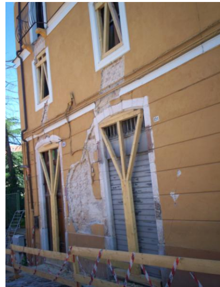
Φωτογραφίες 6.31 και 6.32: Υποστυλώσεις με μεταλλικά ικριώματα και με καδρόνια (Φ.Α. Μ. Δανδουλάκη & Β. Αγιάνογλου)
