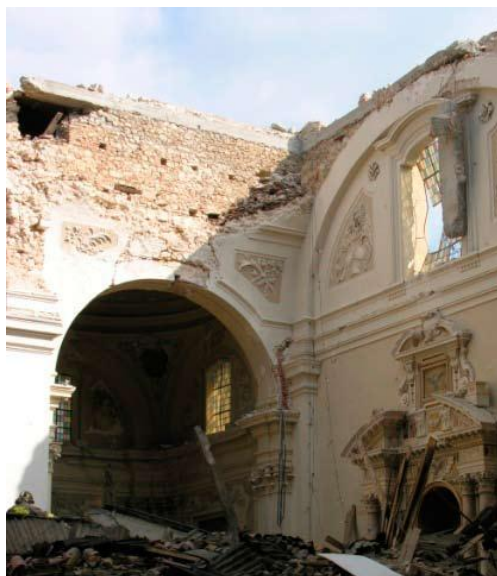
Φωτογραφία 6.27: Η εκκλησία Santa Maria di Collemaggio. Είναι εμφανές το περιμετρικό σενάζ που οδήγησε στην κατάρρευση. (E.E.R.I., 2009)
