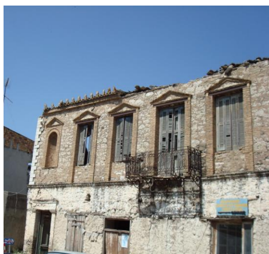
Φωτογραφίες 3.5 & 3.6: Εντυπωσιακή κατάρρευση του πίσω τμήματος κτιρίου στην Αχαΐα χωρίς βλάβες στην πρόσοψη (Φ.Α. Φ. Διαμαντόπουλου)
