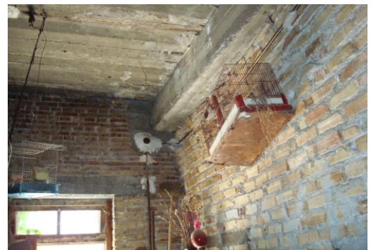
Φωτογραφίες 3.14 και 3.15: Καταστροφικές βλάβες σε διώροφο κτίσμα με προσθήκη οπτοπλινθοδομής πάνω στην οποία εδράζεται δοκός και πλάκα Ο/Σ (Φ.Α. Φ. Διαμαντόπουλου)
