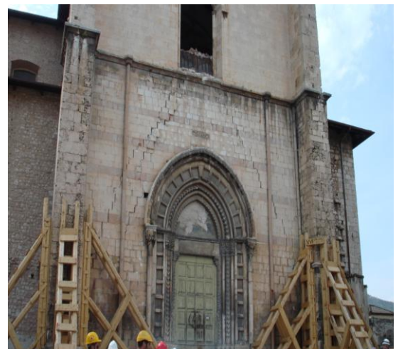
Φωτογραφίες 6.29 και 6.30: Αντιστήριξεις από το Εθνικό Σώμα Πυροσβεστών (Φ.Α. Β. Αγιάνογλου)
