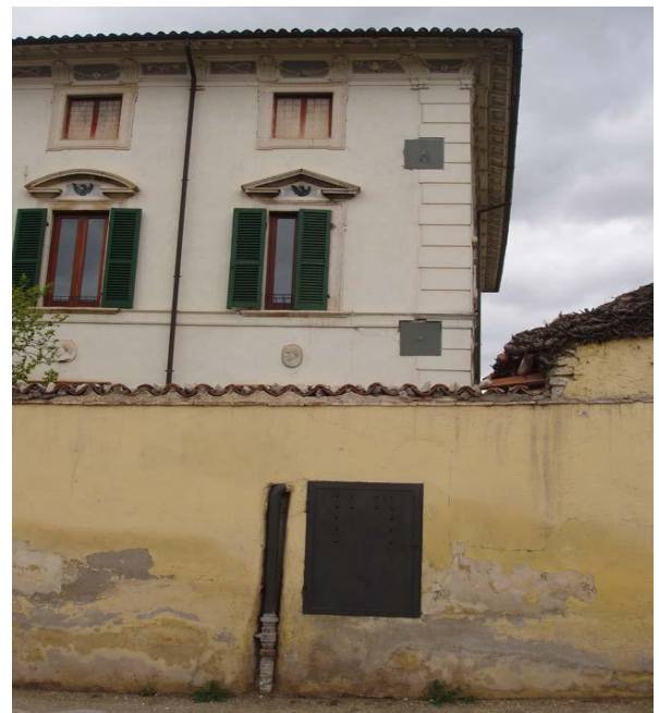
Φωτογραφίες 6.13 και 6.14: Τριώροφα κτίσματα με ελάχιστες επιφανειακές βλάβες. Είναι εμφανείς οι αγκυρώσεις των αντισεισμικών επεμβάσεων (C.C.P.M., 2009 & G.S.I., 2010)
