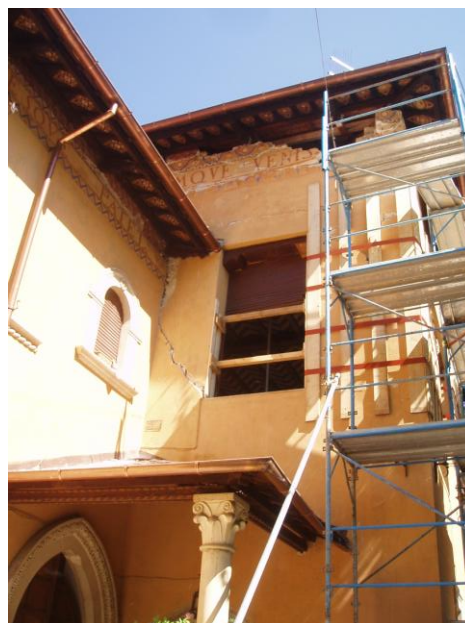
Φωτογραφία 6.8: Διώροφο κτίριο από φέρουσα τοιχοποιία (Φ.Α. Μ. Δανδουλάκη)
