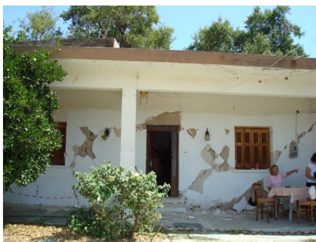
Φωτογραφίες 3.11 & 3.12: Πλάκα Ο/Σ σε ισόγεια κατοικία μικτής κατασκευής. Οι βλάβες είναι εμφανείς τόσο στο στοιχείο όσο και στο εξωτερικό του κτίσματος (Φ.Α. Φ. Διαμαντόπουλου)
