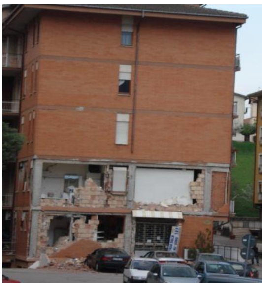
Φωτογραφίες 6.19 και 6.20: Καταρρεύσεις τοίχων πλήρωσης σε κτίρια από Ο/Σ (Karlan et al., 2010, Φ.Α. Β. Αγιάνογλου)
