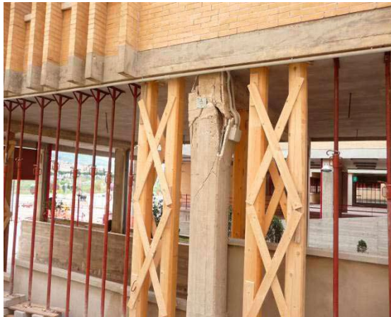
Φωτογραφία 6.25: Υποσύλωση στο Νοσοκομείο San Salvatore λόγω θραύσης κόμβου (Ε.Ε.Ρ.Ι., 2009)
