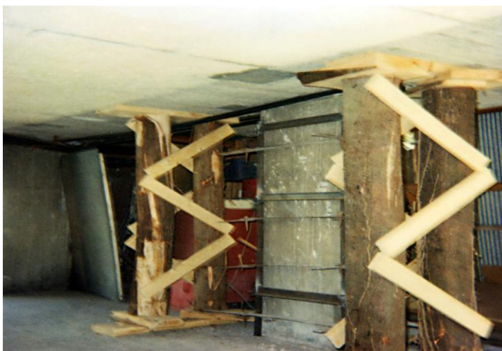
Φωτογραφία 2.1: Υποστύλωση με κορμούς δέντρων
