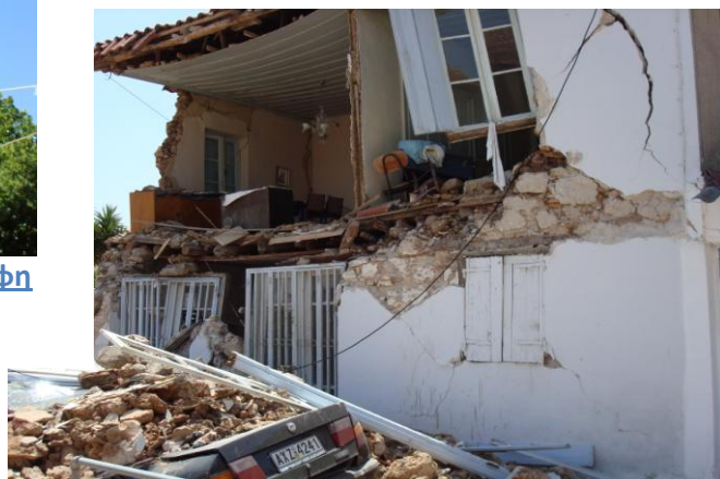
Φωτογραφία 3.4: Μερική κατάρρευση δώροφης κατοικίας από λιθοδομή με ακατέργαστους λίθους (Φ.Α. Φ. Διαμαντόπουλου)
