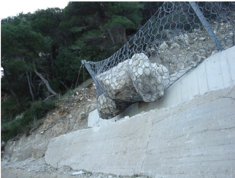
Φωτογραφία 2.7: Αποτελεσματική λειτουργία έργων αντιστήριξης (Φ.Α. Φ. Διαμαντόπουλου)
