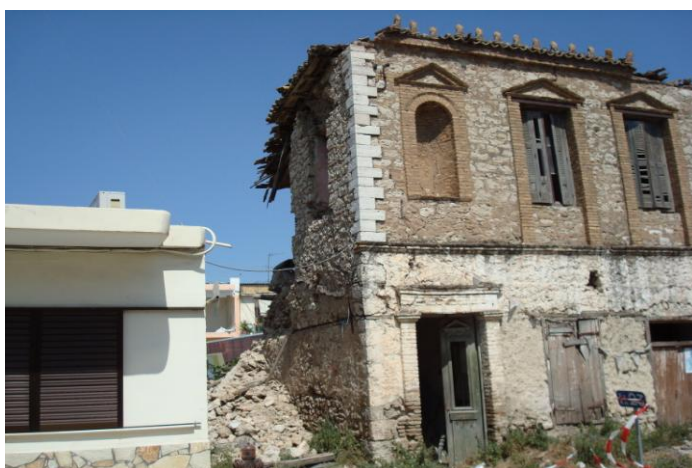
Φωτογραφίες 3.5 & 3.6: Εντυπωσιακή κατάρρευση του πίσω τμήματος κτιρίου στην Αχαΐα χωρίς βλάβες στην πρόσοψη (Φ.Α. Φ. Διαμαντόπουλου)
