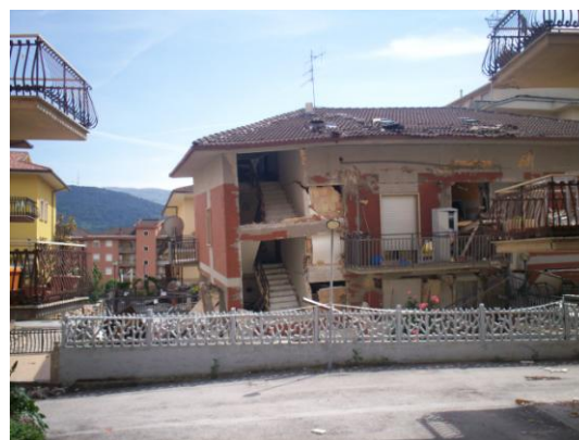
Φωτογραφία 6.18: Τριώροφο κτίριο με κλίμακα και στοιχεία Ο/Σ (Φ.Α. Β. Αγιάνογλου)
