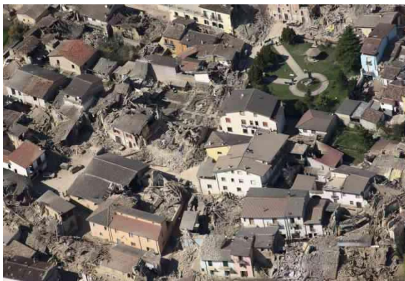
Φωτογραφία 6.6: Αεροφωτογραφία τμήματος της L'Aquila μετά το σεισμό της 6 ης Απριλίου 2009 (Corpo Forestale)
