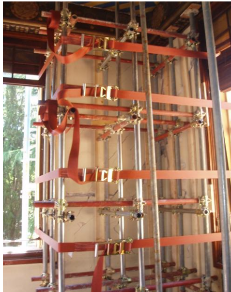
Φωτογραφίες 6.31 και 6.32: Υποστυλώσεις με μεταλλικά ικριώματα και με καδρόνια (Φ.Α. Μ. Δανδουλάκη & Β. Αγιάνογλου)
