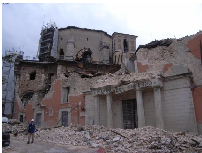
Φωτογραφία 6.1: Το κτίριο της Περιφέρειας (Palazzo del Governo) (C.C.P.M., 2009)
