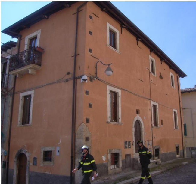
Φωτογραφίες 6.13 και 6.14: Τριώροφα κτίσματα με ελάχιστες επιφανειακές βλάβες. Είναι εμφανείς οι αγκυρώσεις των αντισεισμικών επεμβάσεων (C.C.P.M., 2009 & G.S.I., 2010)
