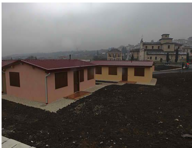
Φωτογραφία 5.4: Κατοικίες Μ.Α.Ρ.
