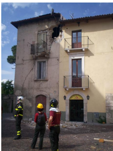
Φωτογραφία 6.11: Αποδιοργάνωση υλικού και μετακίνηση ορόφου
