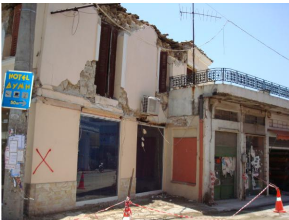
Φωτογραφίες 3.14 και 3.15: Καταστροφικές βλάβες σε διώροφο κτίσμα με προσθήκη οπτοπλινθοδομής πάνω στην οποία εδράζεται δοκός και πλάκα Ο/Σ (Φ.Α. Φ. Διαμαντόπουλου)
