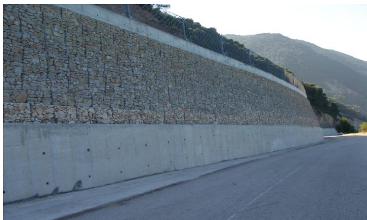
Φωτογραφία 2.4: Κατασκευή τοίχου αντιστήριξης πρανών
