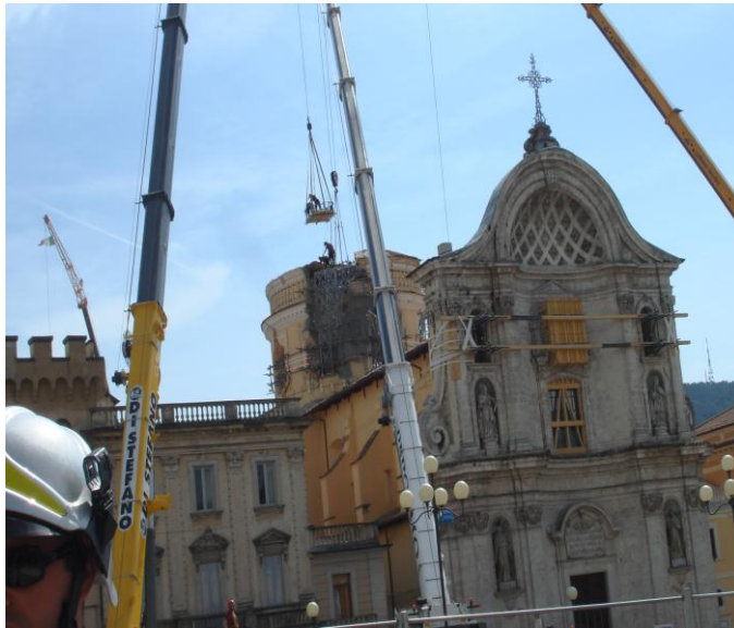
Φωτογραφία 6.28: Εργασίες στον Καθεδρικό Ναό της Λ' Aquila (Φ.Α. Β. Αγιάνογλου)
