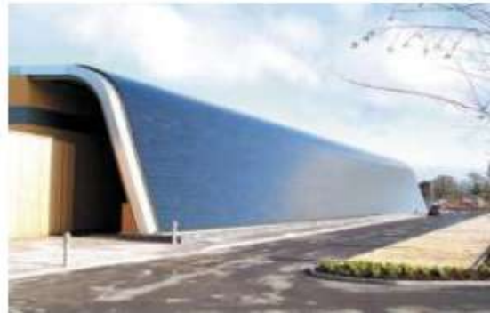
Εικόνα 3.7. Ενσωμάτωση φωτοβολταϊκών σε δημόσιο κτίριο. ( http://www.env-edu.gr )
