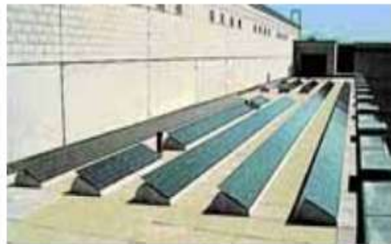
Εικόνα 3.6 Εφαρμογή φωτοβολταϊκών σε ταράτσα κτιρίου. ( http://www.env-edu.gr )
