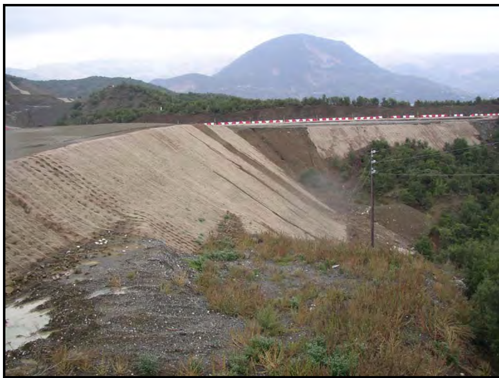
Φωτογραφία 6-6 Κατασκευή επιχώματος στην περιοχή του Α/Κ Ζαγορίου
