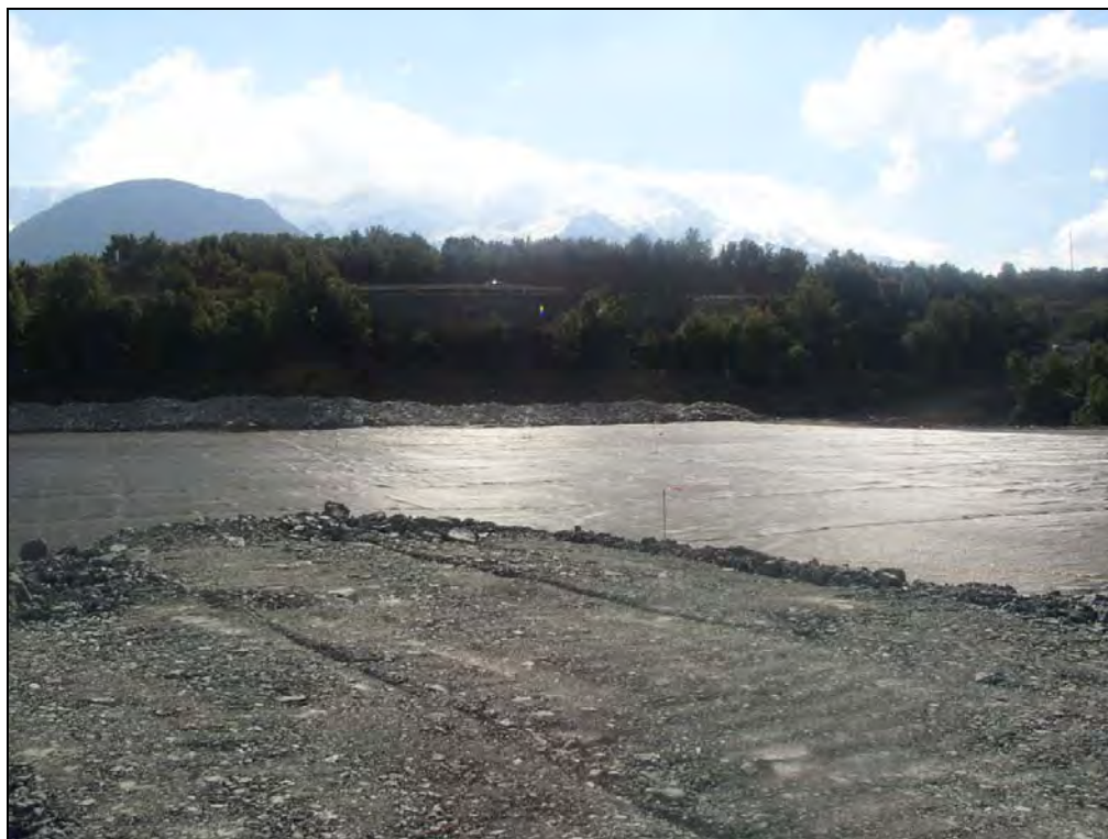
Φωτογραφία 6-14 Διάστρωση γεωπλεγμάτων στην περιοχή του επιχώματος του κλάδου C στον Α/Κ Ζαγορίου.
