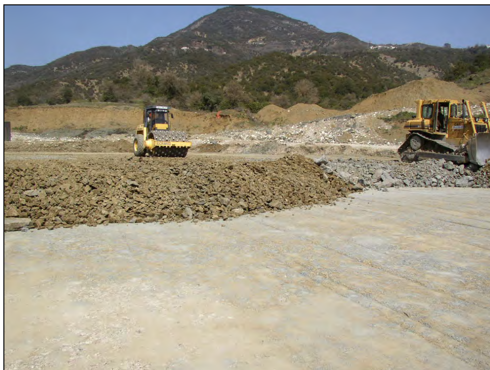
Φωτογραφία 6-14 Διάστρωση γεωπλεγμάτων στην περιοχή του επιχώματος του κλάδου C στον Α/Κ Ζαγορίου.
