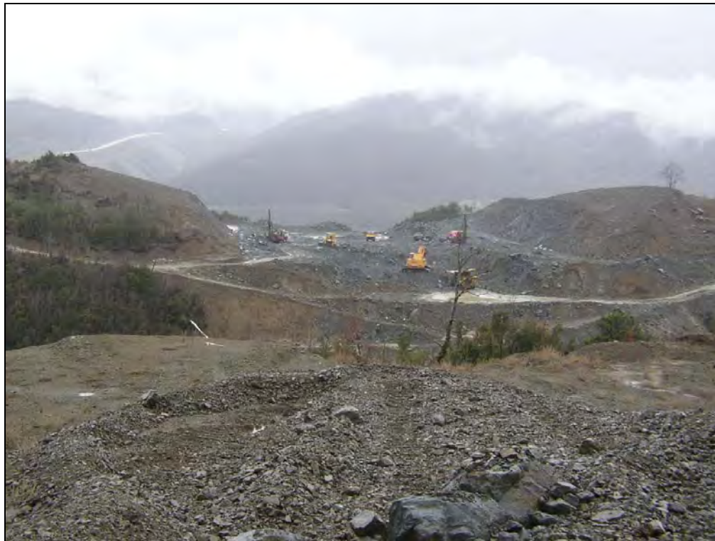
Φωτογραφία 6-1 Γενική άποψη του ορύγματος T1 κατά την φάση των εκσκαφών.
