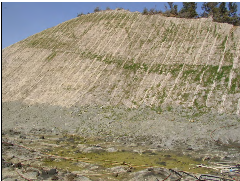
Φωτογραφία 6-10 Διακρίνεται η επιλεκτική κυκλοφορία του υπόγειου νερού δια μέσου των ψαμμιτικών ενστρώσεων, σαν αποτέλεσμα της υδροσποράς.(Όρυγμα περί την χ.θ. 2+200)
