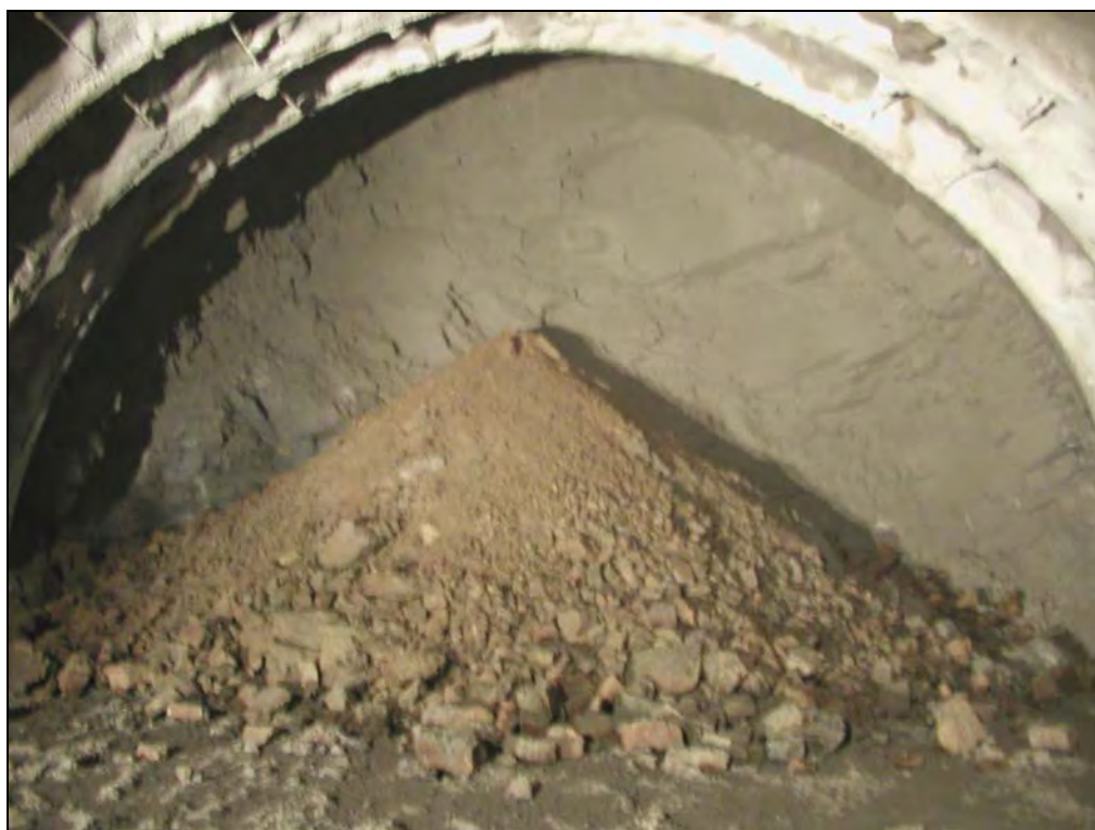
Φωτογραφία 6-16 Γεωλογική κατάπτωση στην σήραγγα T6
