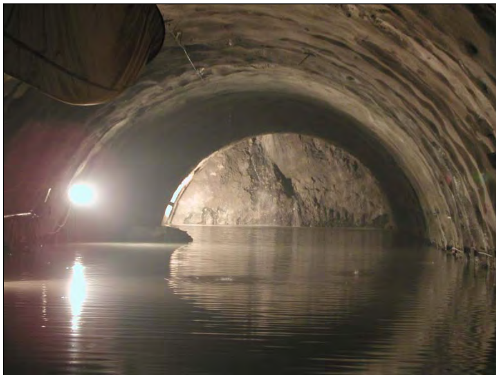
Φωτογραφία 6-23 Σήραγγα Τ8.Μεγάλη εισροή υδάτων στην χ.θ. 4+900 (25/7/2003)
