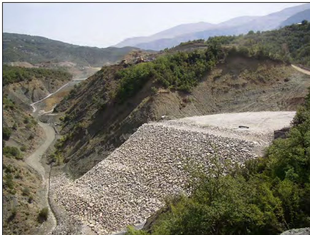
Φωτογραφία 6-5 Κατασκευή επιχώματος T2 (χ.θ. 0+630-χ.θ. 0+720)
