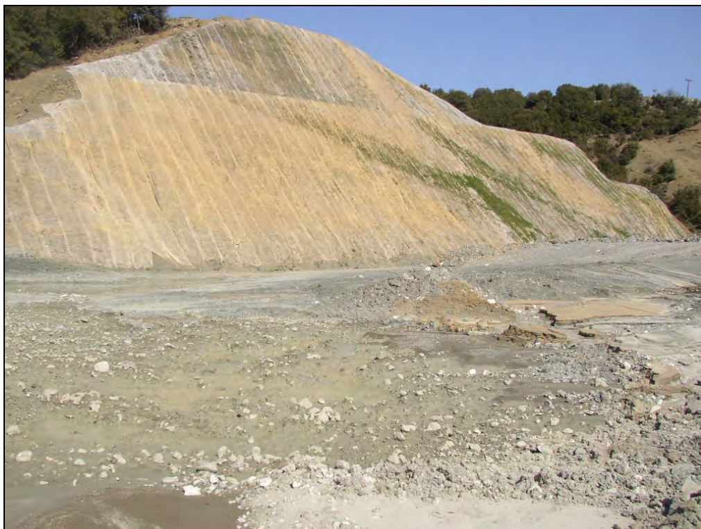
Φωτογραφία 6-11 Διακρίνεται η επιλεκτική κυκλοφορία του υπόγειου νερού δια μέσου των ψαμμιτικών ενστρώσεων, σαν αποτέλεσμα της υδροσποράς.(Όρυγμα 2+660)
