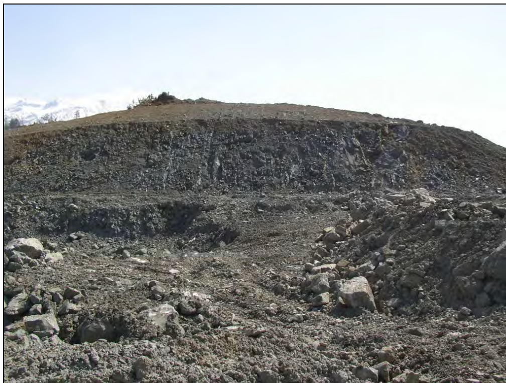
Φωτογραφία 6-2 Δεξιά όψη του ορύγματος T1 κατά το στάδιο κατασκευής.
