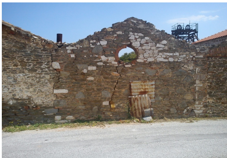
Εικόνα 6.3: Κτίσμα δίπλα στο μουσείο - Προτεινόμενος χώρος για parking
