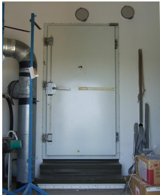
Εικόνα 5.2: Η είσοδος του πειραματικού χώρου, όπως φαίνεται από τον προθάλαμο
