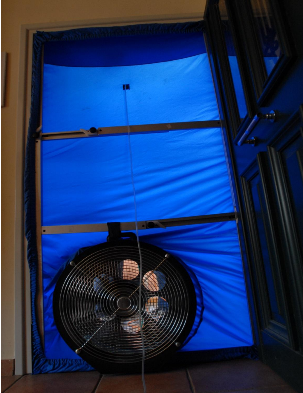
Εικόνα 3.8 : Συσκευή μέτρησης αεροστεγανότητας με τη μέθοδο υπερπίεσης πεπιεσμένου αέρα.
