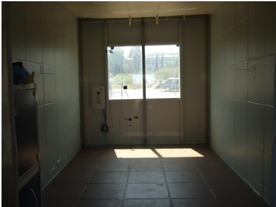
Εικόνα 5.4 : Ο πειραματικός χώρος του test cell. Νότια όψη.
