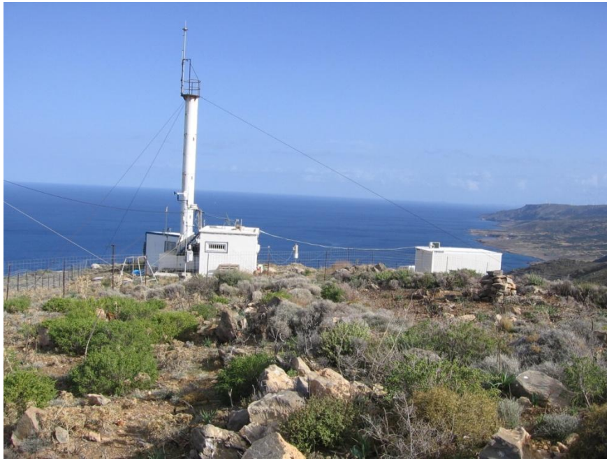
Εικόνα 6: Σταθμός Φινοκαλιάς στο Λασιθί της Κρήτης (Σταθμός Φινοκαλιάς)
