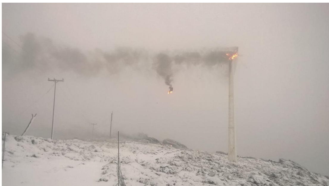
Εικόνα 4.2.3 Κεραυνός έχει χτυπήσει ανεμογεννήτρια στην Άνδρο, η οποία έχει πάρει φωτιά. Πηγή http://www.androsportal.gr/keravnos-cthipise-mia-apo-tis-anemogennitries-sto-kalivari/ Αναζήτηση στις 22/05/2016
