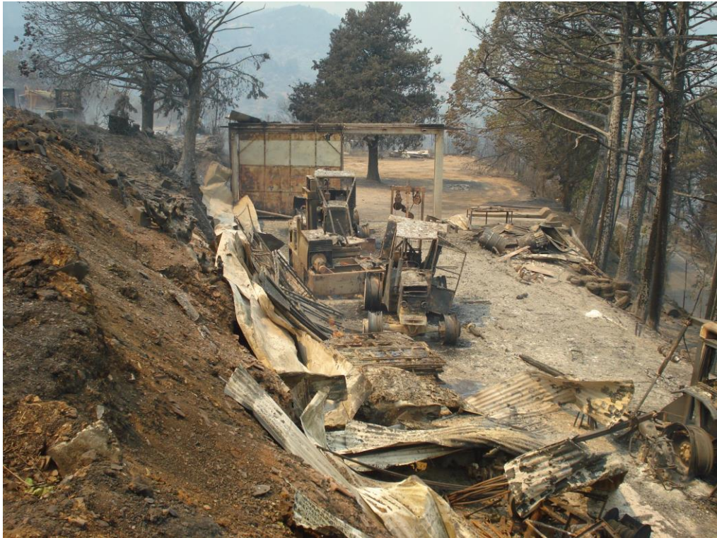
Φωτογραφία 11: “Καταστροφές μετά την κατάσβεση στο ξυλόπριστήριο Αρτεμηςίας ”
