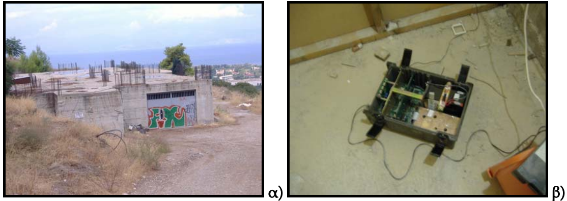
Εικόνα 4.21: α) Η δημοτική αποθήκη όπου έχει εγκατασταθεί ο σταθμός της Ακράτας και β) η θέση του επιταχυνσιογράφου μέσα στον ειδικά διαμορφωμένο χώρο της αποθήκης.
