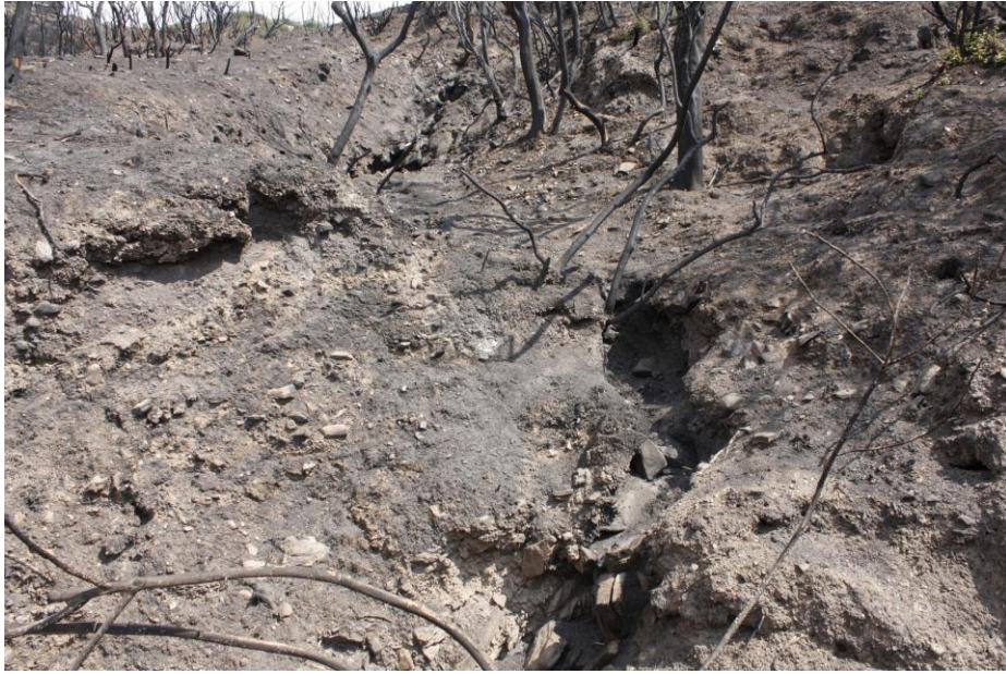
Εικόνα 3.36. Στην περιοχή κατάντη του Φαρακλού καταλήγουν απορροές από τον οικισμό και των ομβρίων του δόμου προς Καστανιά. Παρατηρείται διάβρωση του εδάφους που εντείνεται μετά την πυρκαγιά εφόσον αποσπάται πιο εύκολα ο εδαφικός μανδύας (Λέκκας et al., 2015).
