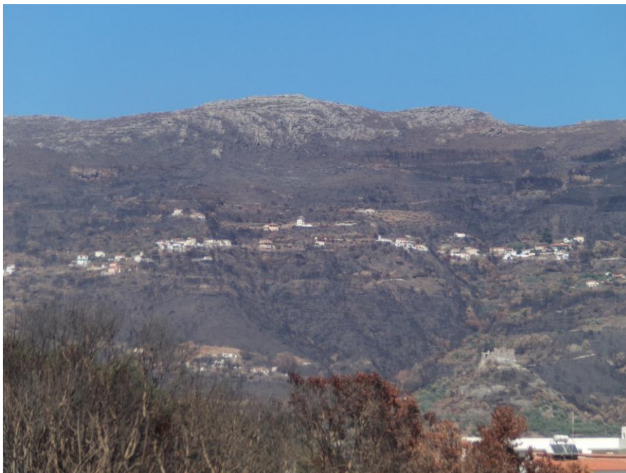
Εικόνα 3.30. Άποψη του Μεσοχωρίου, η κεντρική περιοχή είναι καλυμμένη από αναβαθμούς που προστατεύουν την περιοχή από την διάβρωση του εδάφους. Η περιοχή αυτή έχει προταθεί για συντήρηση των αναβαθμίδων ως αντιδιαβρωτικό μέτρο (Λέκκας et al., 2015).
