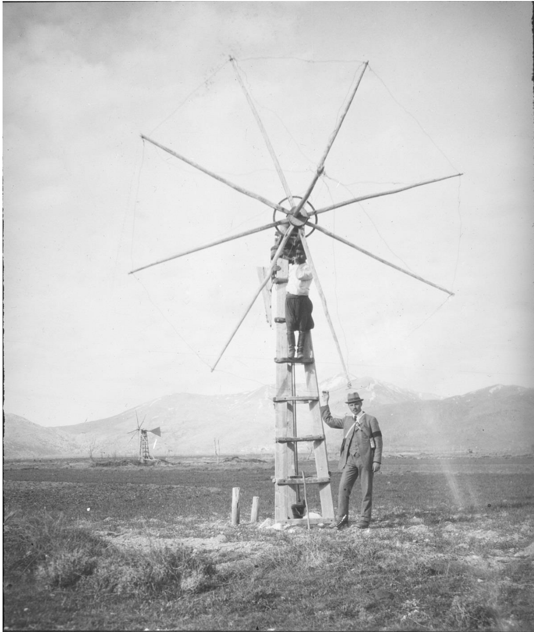
Εικόνα 2: Εγκατάσταση ξύλινου ανεμόμυλου το 1921, πηγή: ΕΤΗ Bibliothek Zurich
