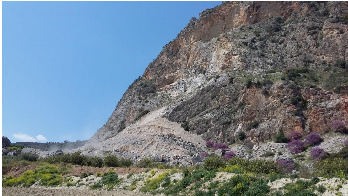
Εικόνα 3.2.1: Χώρος εκσκαφής/κονιοποίησης ασβεστόλιθων ενότητας Πίνδου, ΝΑ του ρηξιτεμάχους της Κούτσας. Προσανατολισμός λήψης φωτογραφίας προς ΝΔ.
