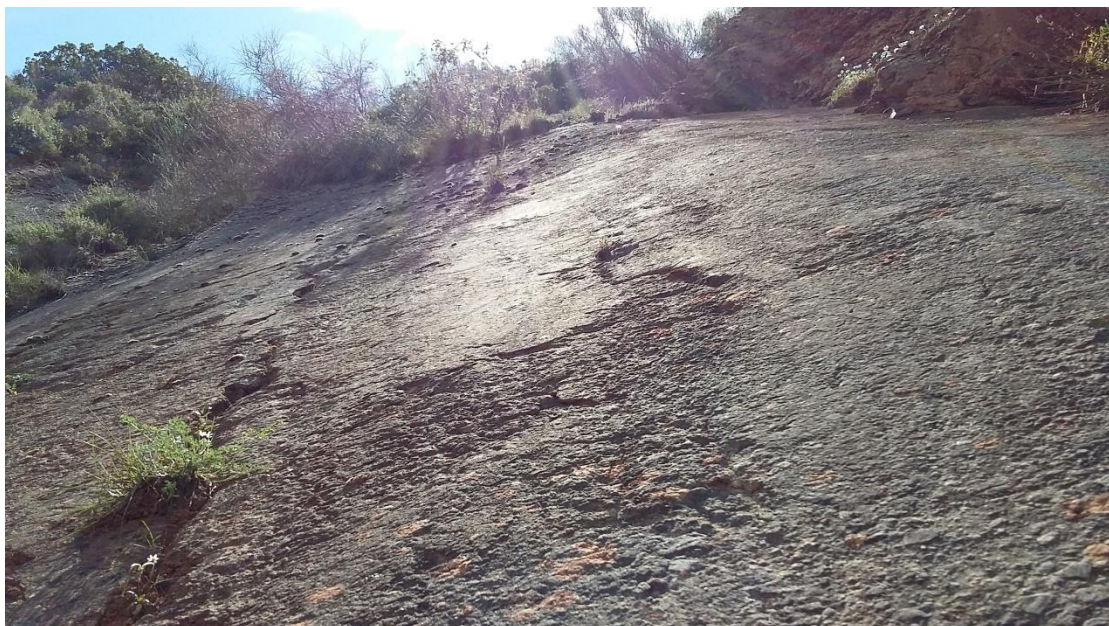
Εικόνα 3.3.9: Άποψη της προηγούμενης επιφάνειας προς τα πάνω. Παρατηρείται μια ελαφριά καμπύλωση της, ενώ η επίδραση της διάβρωσης και της αποσάθρωσης είναι εμφανής.
