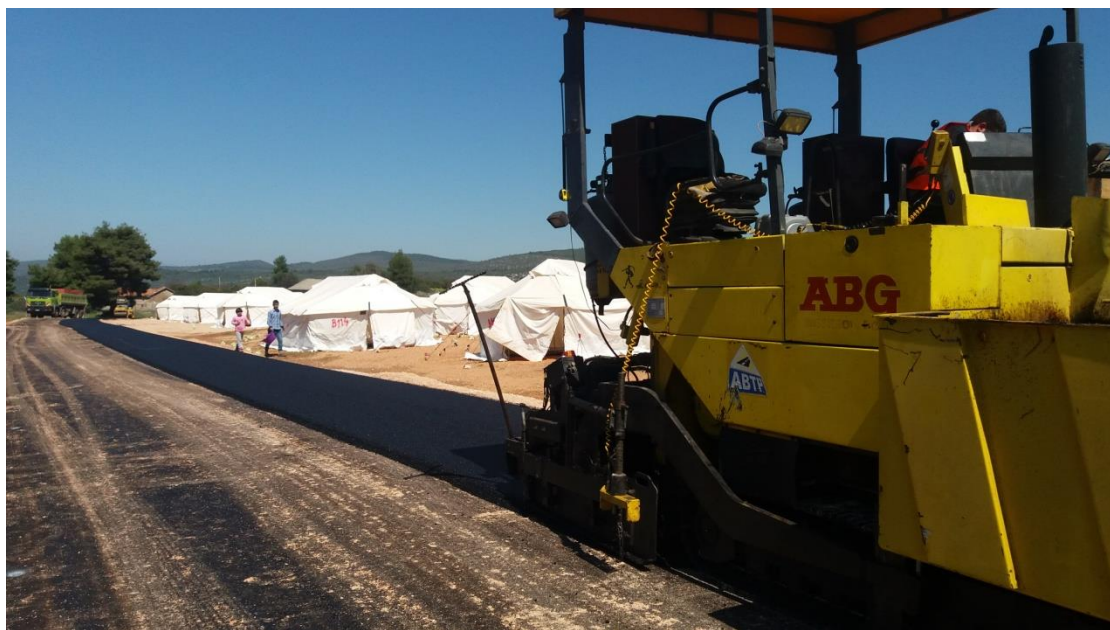
Εικόνα 5.1: Ασφαλτόστρωση δρόμων με χρήση finisher στο Hotspots στην περιοχή της Μαλακάσας
