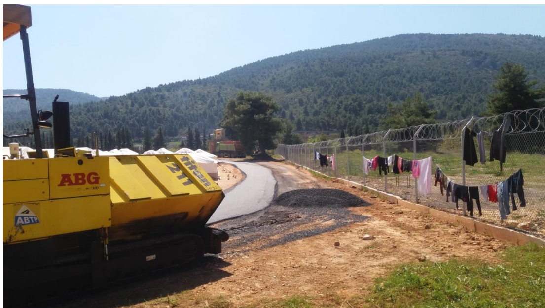
Εικόνα 5.2: Ασφαλτόστρωση δρόμων με χρήση finisher στο Hotspots στην περιοχή της Μαλακάσας
