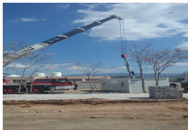
Εικόνα 2.6&2.7 : Τοποθέτηση Container με χρήση γερανού στον Ελαιώνα
