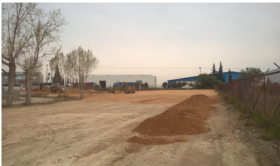
Εικόνα 5.3: Διάστρωση ισοπέδωση και συμπίεση θραυστών υλικών με μηχανήματα της εταιρίας ΑΚΤΩΡ
