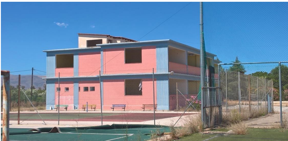
Εικόνα 6: Εξωτερικοί χώροι Λυκείου.
