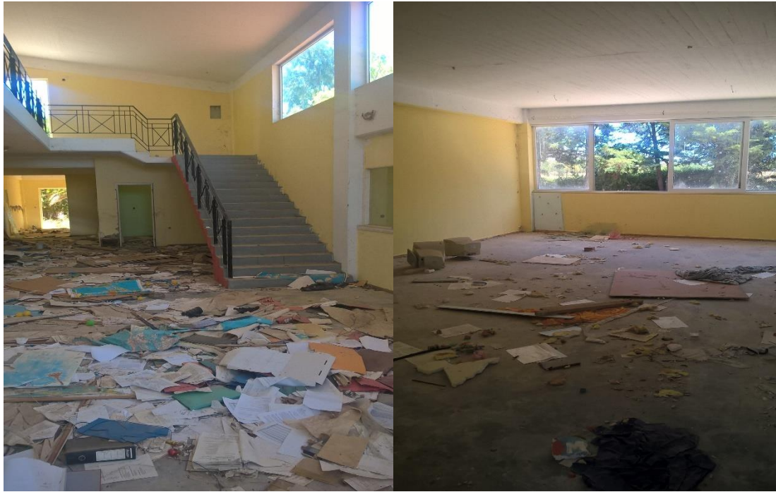
Εικόνες 4,5: Εσωτερικοί χώροι Δημοτικού Νηπιαγωγείου.
