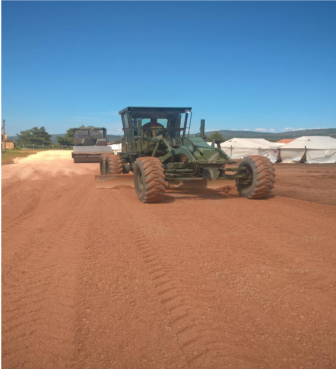
Εικόνα 3.13: Διάστρωση και συμπύκνωση θραυστών υλικών με χρήση Ι/Γ και οδοστρωτήρα.
