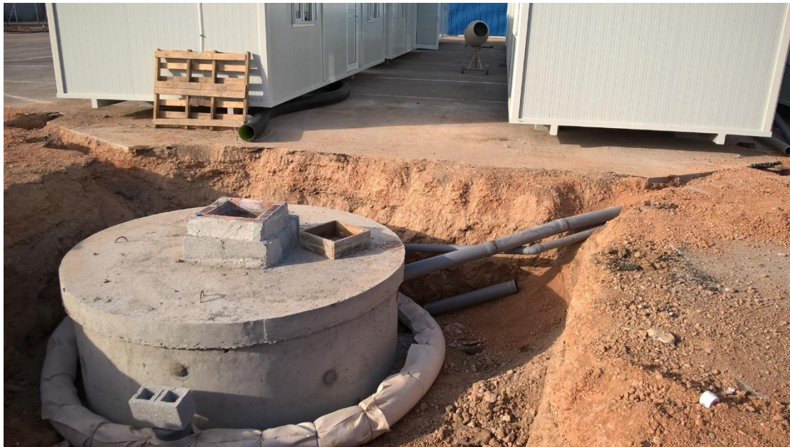
Εικόνα 3.19: Τοποθέτηση βόθρων συλλογής λημμάτων στο καταυλισμό προσφύγων στη περιοχή Σκαραμαγκά
