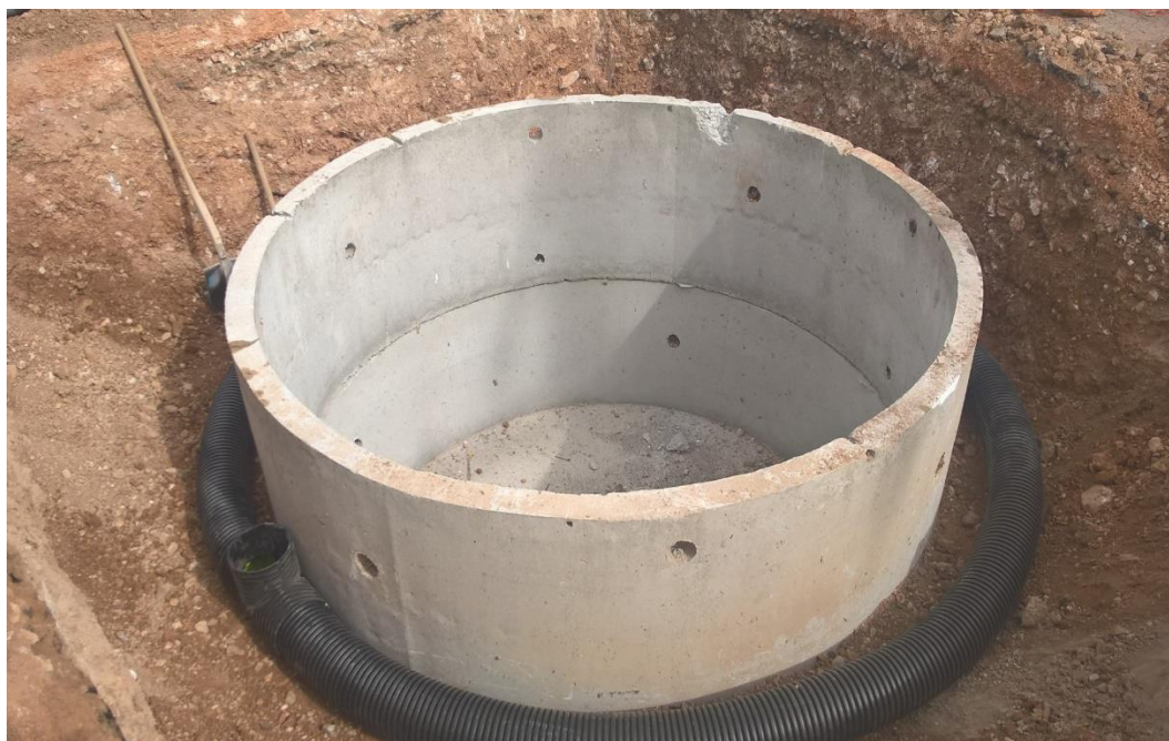
Εικόνα 3.12: Τοποθέτηση προκατασκευασμένων δεξαμεμών συλλογής λυμάτων
