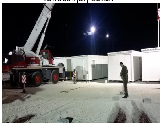
Εικόνα 2.6&2.7 : Τοποθέτηση Container με χρήση γερανού στον Ελαιώνα
