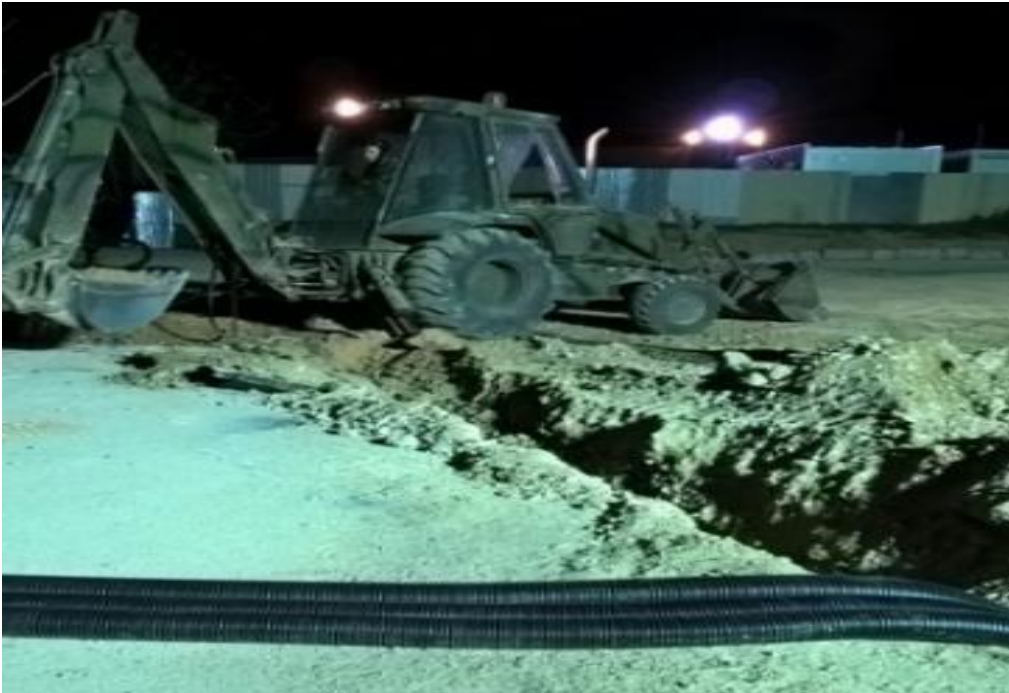
Εικόνα 3.27: Τοποθέτηση γραμμών ηλεκτροδότησης σε όρυγμα στον Ελαιώνα
