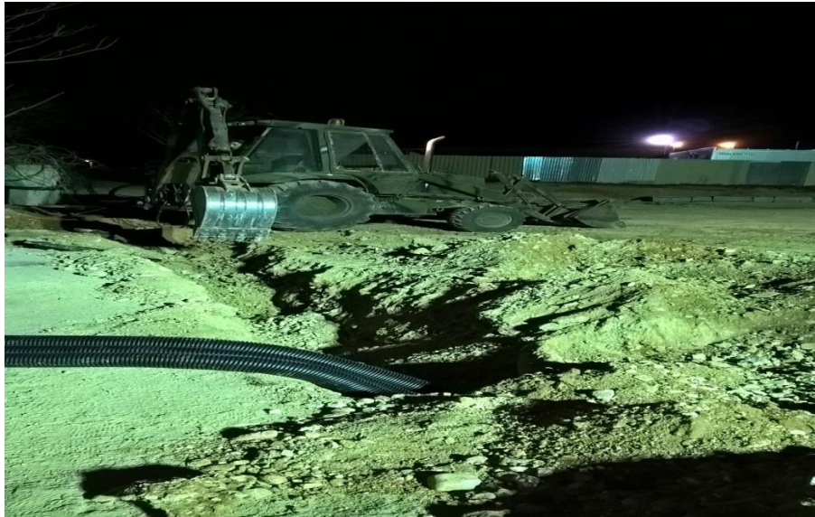
Εικόνα 2.3 : Εκσκαφή ορύγματος δικτύου ηλεκτροδότησης με χρήση Φ/Τ – Ε/Τ στον Ελαιώνα
