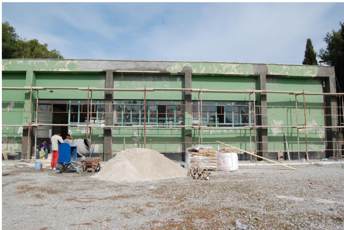
Εικόνα 3.7: Εργασίες επισκευής κτηρίου στο Στρατόπεδο «ΣΤΕΦΑΝΑΚΗ ΙΩΑΝΝΗ»
