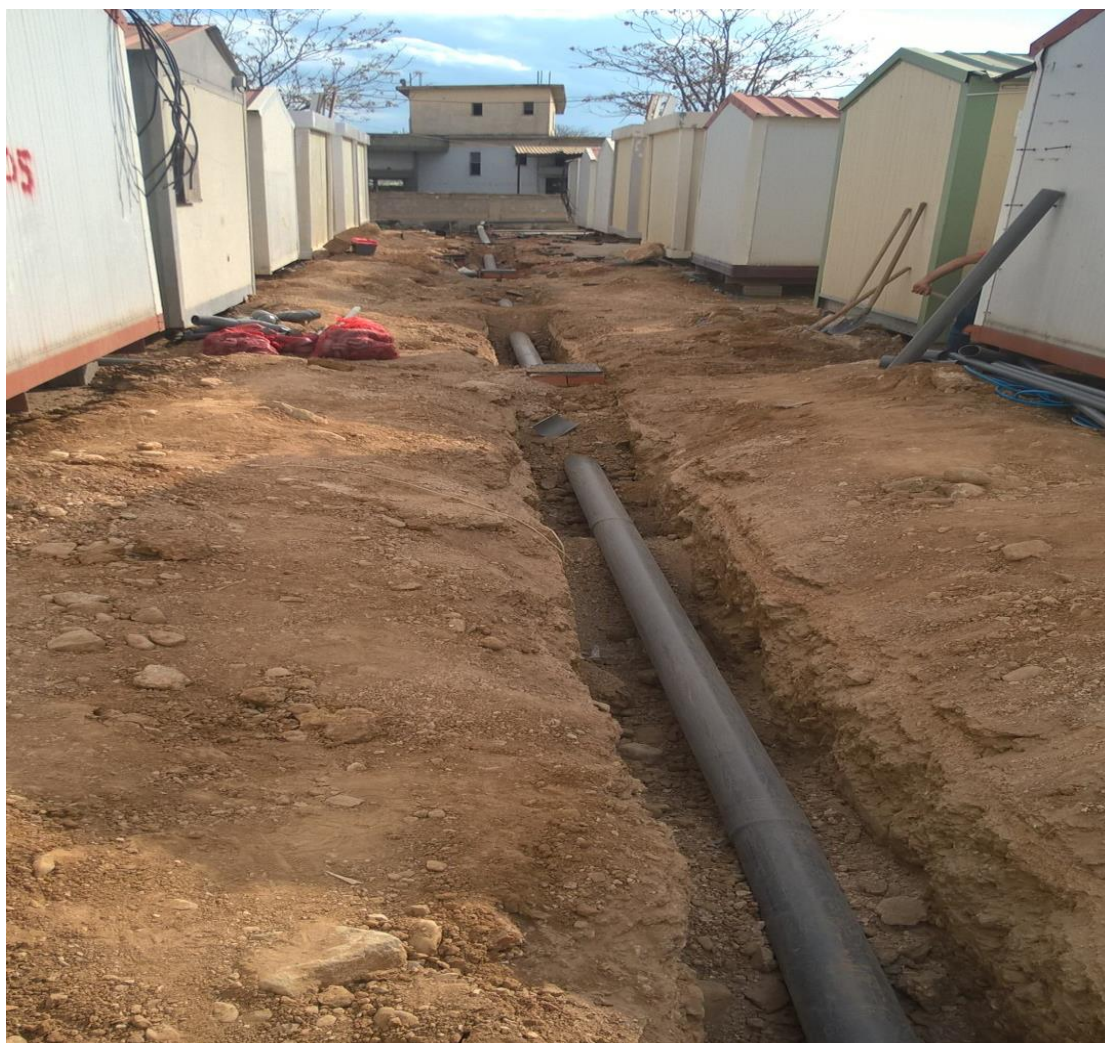
Εικόνα 2.4 : Τοποθέτηση σωλήνα και φρεατίων σε όρυγμα δικτύου αποχέτευσης στον Ελαιώνα
