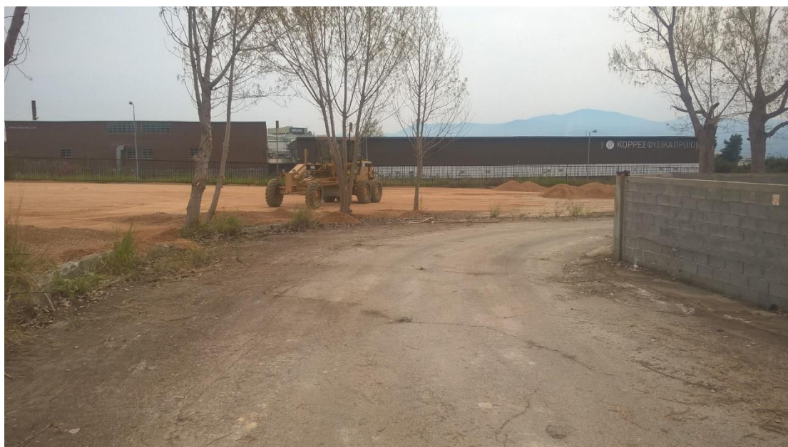
Εικόνα 5.4: Διάστρωση και ισοπέδωση θραυστών υλικών με χρήση Ι/Γ της εταιρίας ΑΚΤΩΡ
