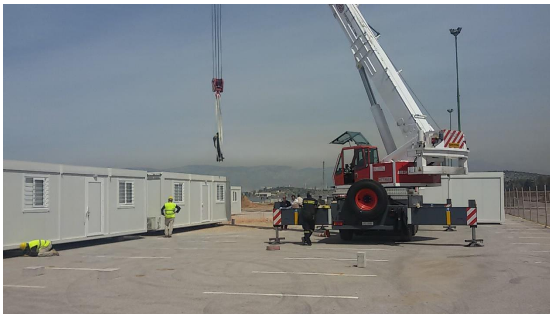
Εικόνα 3.18:Τοποθέτηση Container με χρήση Γερανού στο καταυλισμό προσφύγων στη περιοχή Σκαρμαγκά
