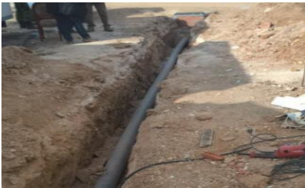
Εικόνα 3.26: Τοποθέτηση σωληνώσεων αποχέτευσης σε όρυγμα στον Ελαιώνα
