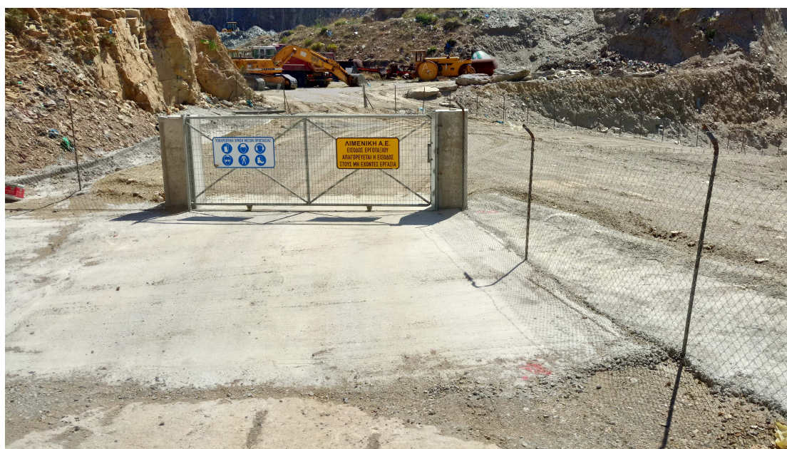
Εικόνα 5.12. Είσοδος του εργοταξίου
