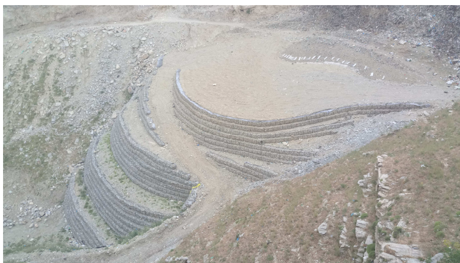
Εικόνα 5.11. Έργα Αποκατάστασης ΧΑΔΑ
