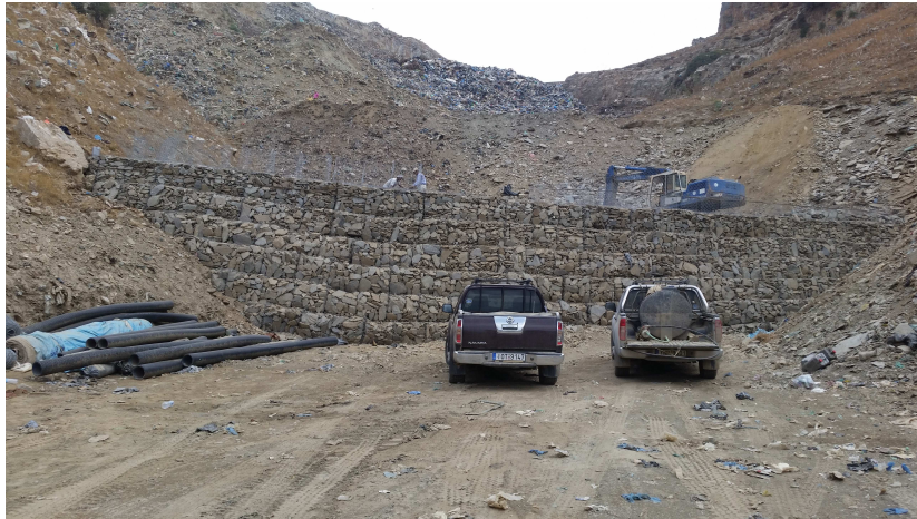
Εικόνα 5.8. Έργα Αποκατάστασης ΧΑΔΑ
