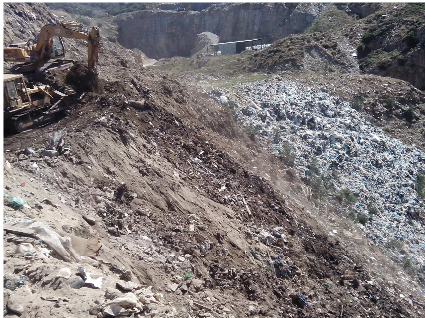
Εικόνα 5.14. Έργα Αποκατάστασης ΧΑΔΑ
