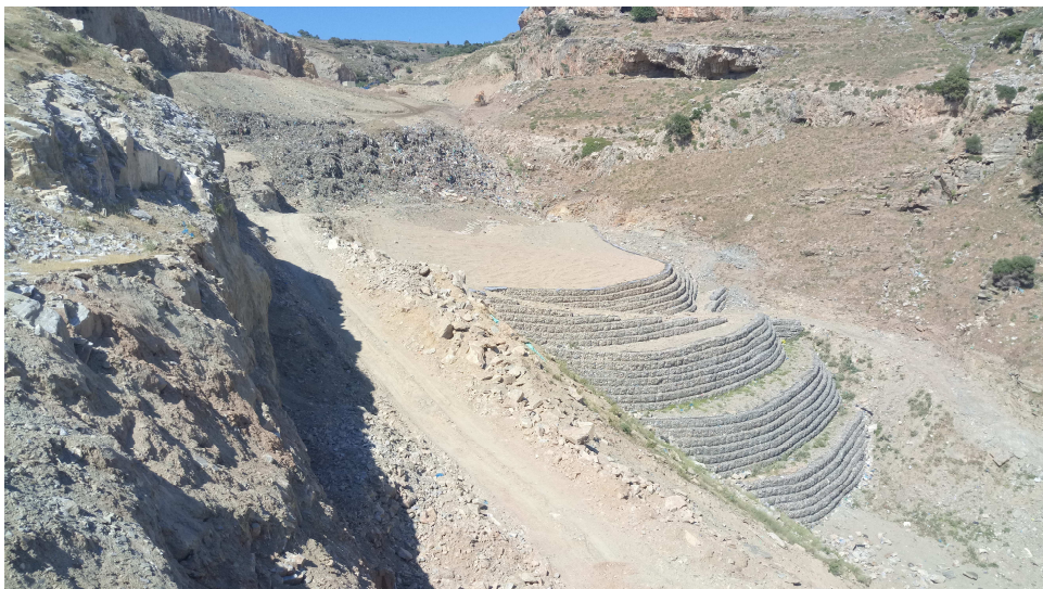
Εικόνα 5.10. Έργα Αποκατάστασης ΧΑΔΑ
