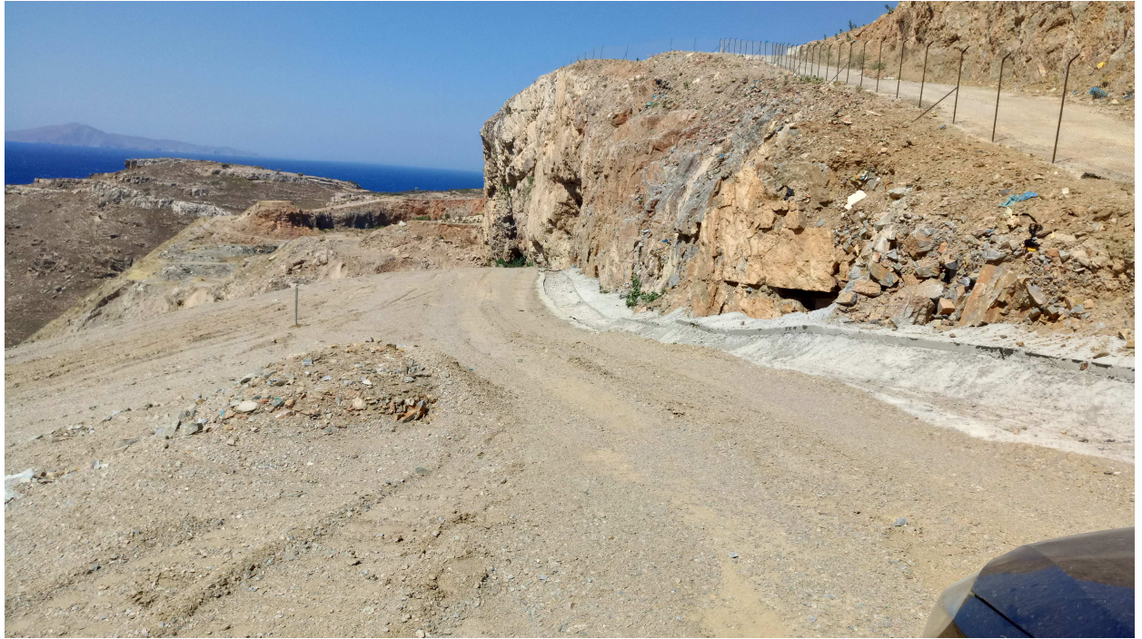
Εικόνα 5.13. Έργα Αποκατάστασης ΧΑΔΑ
