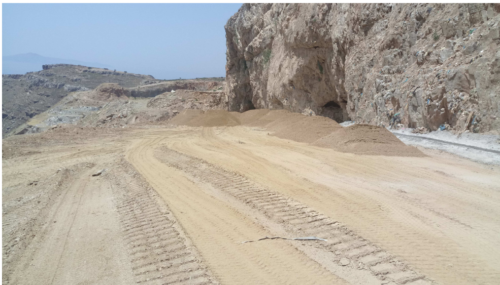
Εικόνα 5.9. Έργα Αποκατάστασης ΧΑΔΑ
