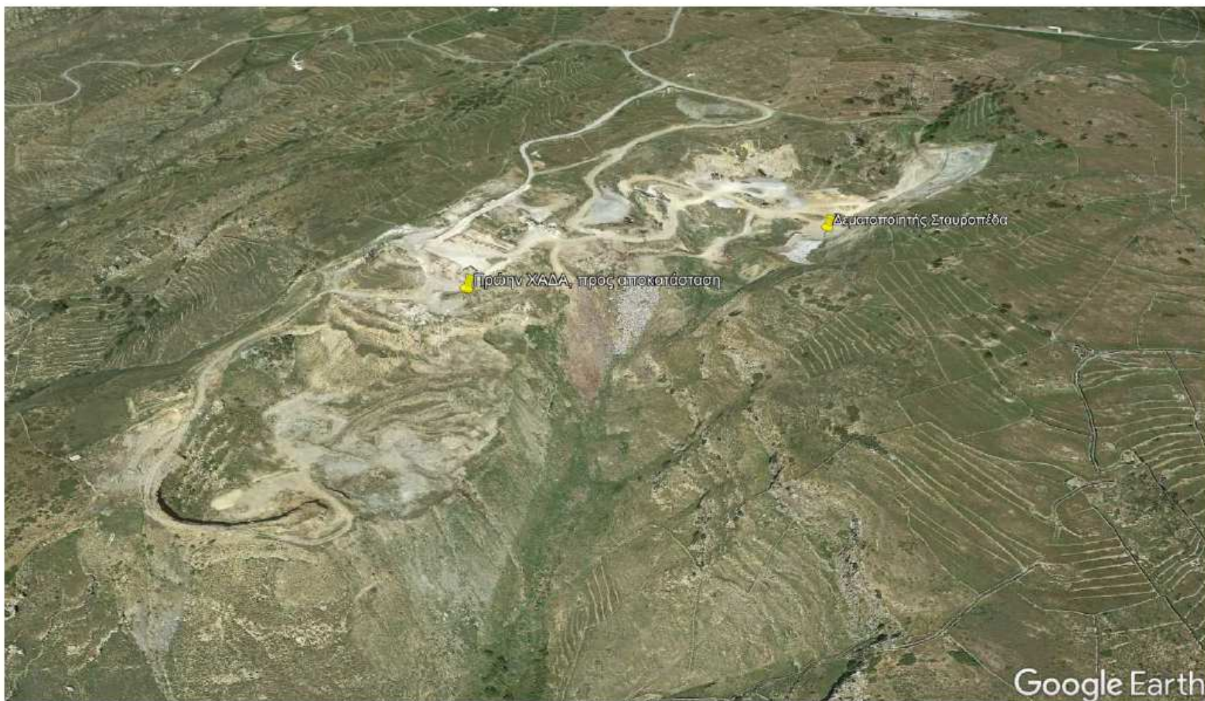
Εικόνα 5.1. Απεικόνιση του ΧΑΔΑ Σταυροπέδας και του Οικοπέδου στο οποίο βρίσκεται ο δεματοποιητής (Google Earth)
