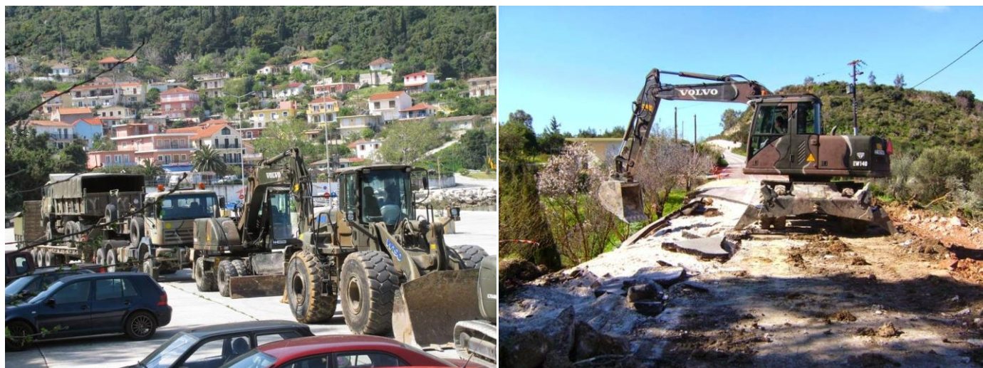
Εικόνα 25: Συνδρομή του ΣΞ στον σεισμό της Κεφαλονιάς (Πηγή 747 ΕΤΜΧ)
