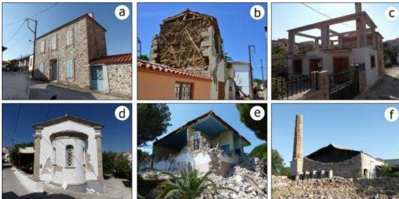
Εικ. 7 Κυρίαρχοι τύποι κτηρίων στη Βρίσα (α) πέτρινα κτήρια με υποστηρικτικά τοιχώματα (β) πετρόχτιστες οικίες με διπλό αντισεισμικό δομικό σύστημα πηγή : (Lekkas et al., 2017)
