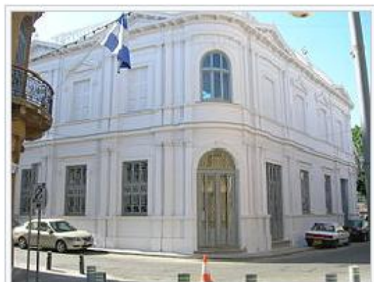
Εξωτερική άποψη του μεγάρου της Ιονικής Τράπεζας στην Λευκωσία.
