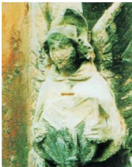
Εικόνα 11.3. Η όξινη βροχή προκαλεί γυψοποίηση των μαρμάρινων αρχιτεκτονικών μνημείων. (Πηγή, Αδαμαντιάδου Σ, 2015)
