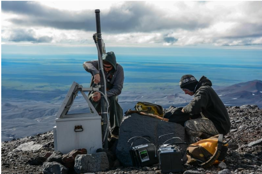
Εικόνα19. Πλήρωμα εργάζεται για εγκατάσταση οργάνων παρακολούθησης ηφαιστείου στην Αλάσκα.
