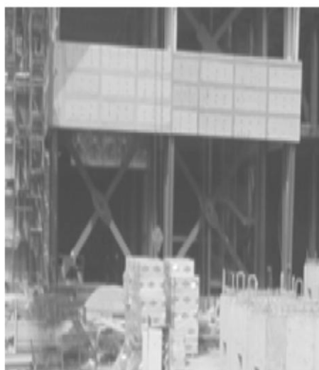
Σχήμα 4.28.: Αντισεισμική ενίσχυση κατασκευής με χιαστί διαγωνίους συνδέσμους.
