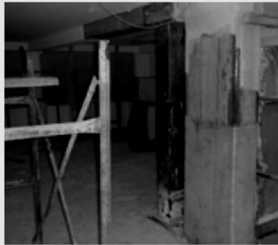
Σχήμα 4.9.: Μείωση του ανοίγματος δοκού με χρήση μεταλλικού υποστυλώματος.
