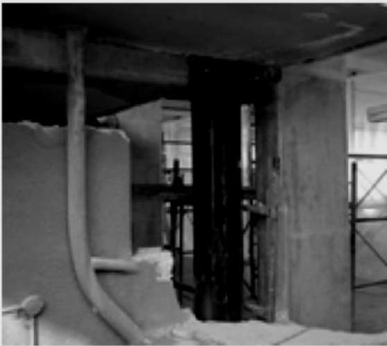
Σχήμα 4.9.: Μείωση του ανοίγματος δοκού με χρήση μεταλλικού υποστυλώματος.
