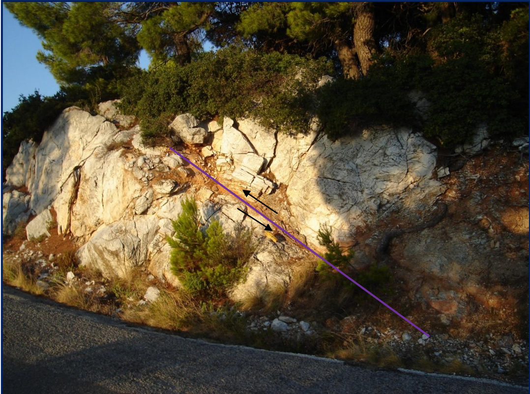
Εικόνα 172. Ρήγμα ανάστροφο, ~ 350 m νότια της διασταύρωσης Στάφυλου. Στοιχεία επιπέδου ρήγματος (μωβ γραμμή): 50/290.
