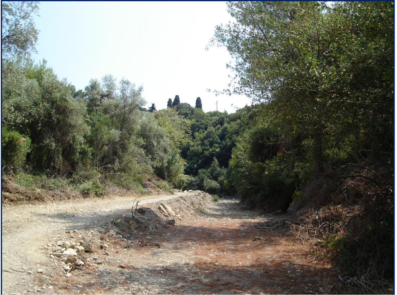
Εικόνα 40. Η είσοδος στο Ρέμα Τριπότη από την πεδιάδα. Φωτογράφιση του 2016. Λόγω της κατακλυσμιαίας βροχόπτωσης του Σεπτεμβρίου 2015 έχουν διαβρωθεί σε έντονο βαθμό οι πλευρές του αγροτικού δρόμου που υπήρχε εδώ παλαιότερα και συνέπιπτε με την κοίτη του χειμάρρου. Οι εμφανίσεις υπερβασιτών που φωτογραφήσαμε τον Αύγουστο του 2015 στα χαμηλότερα σημεία του τότε δρόμου έχουν τώρα καλυφθεί με μπάζα ή χαλίκι οδοποιίας. Η διεύθυνση της φωτογραφίας είναι προσεγγιστικά NE-SW.
