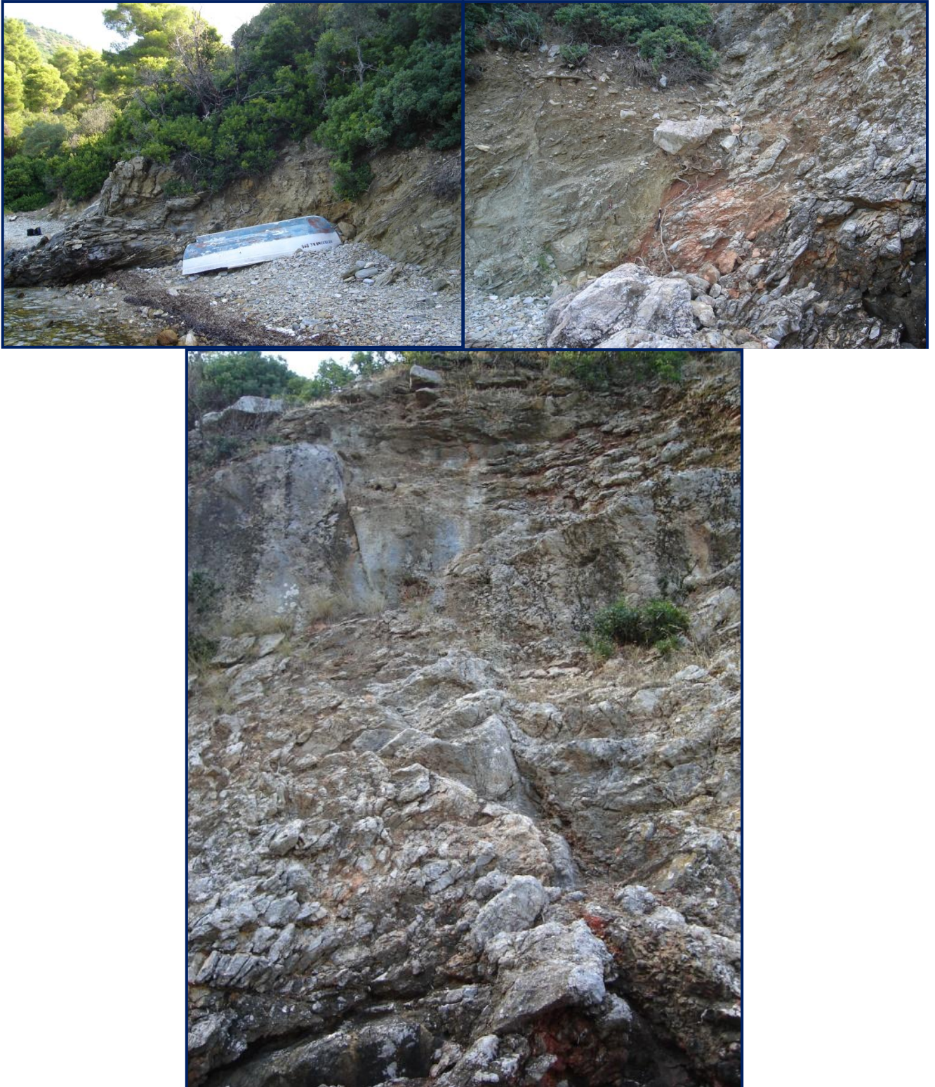
Εικόνα 57. Παρατηρώντας σε διαδοχή τις 3 αυτές φωτογραφίες, μπορούμε να αποκτήσουμε μια αίσθηση των έντονων τεκτονικών δυνάμεων που ασκήθηκαν στο παρελθόν στα πετρώματα αυτά, ώστε να υποστούν αυτού του βαθμού παραμορφώσεις και ρηγματώσεις. Οι φωτογραφίες έχουν διεύθυνση NE-SW.
