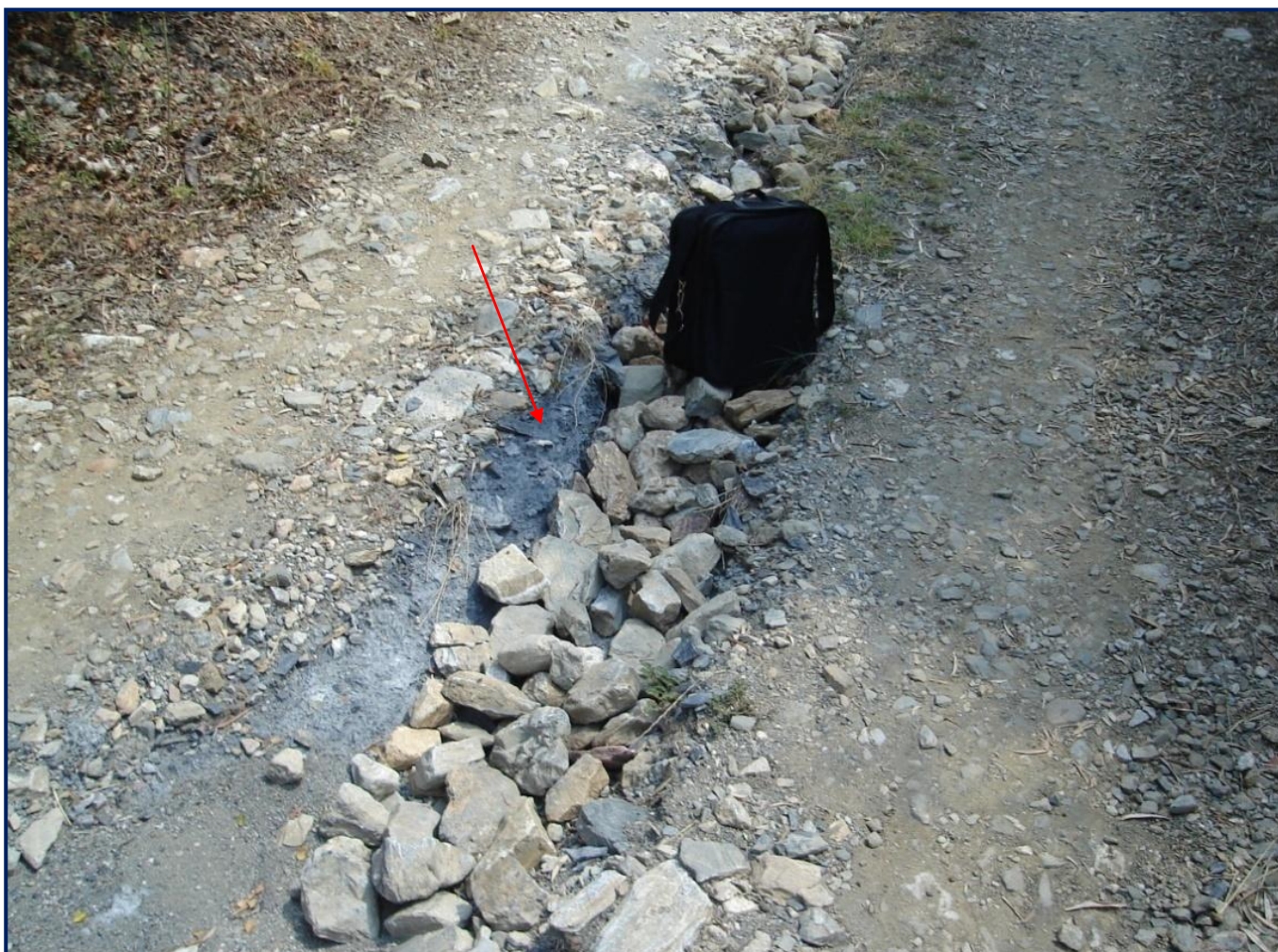
Εικόνα 39. Μικρή εμφάνιση μεταμαγματικών πετρωμάτων (βέλος) κάτω από τα κορήματα του χωματόδρομου, στην πεδινή έκταση μπροστά από το ρέμα Τριπότη. Η φωτογράφιση έγινε τον Αύγουστο του 2015.
