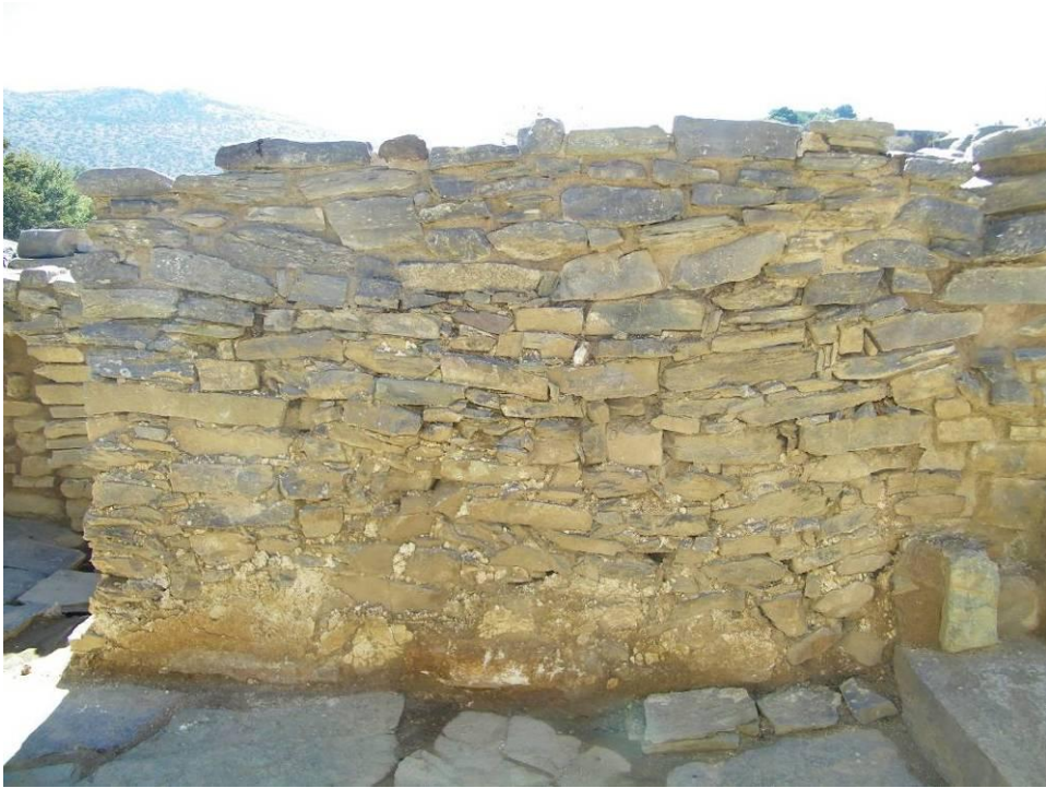
16α. Νότιος τοίχος Χώρου 7 με σωζόμενο κατά χώραν επίχρισμα ασβεστοκονιάματος.
