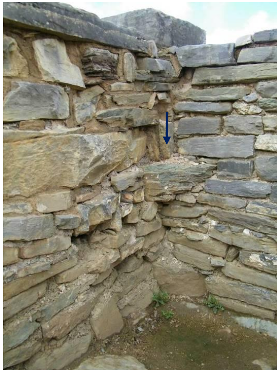
25β. Κλιμακοστάσιο Χώρου 20. Ενσωματωμένος στην τοιχοποιία λίθος που προεξέχει στη ΒΔ γωνία.
