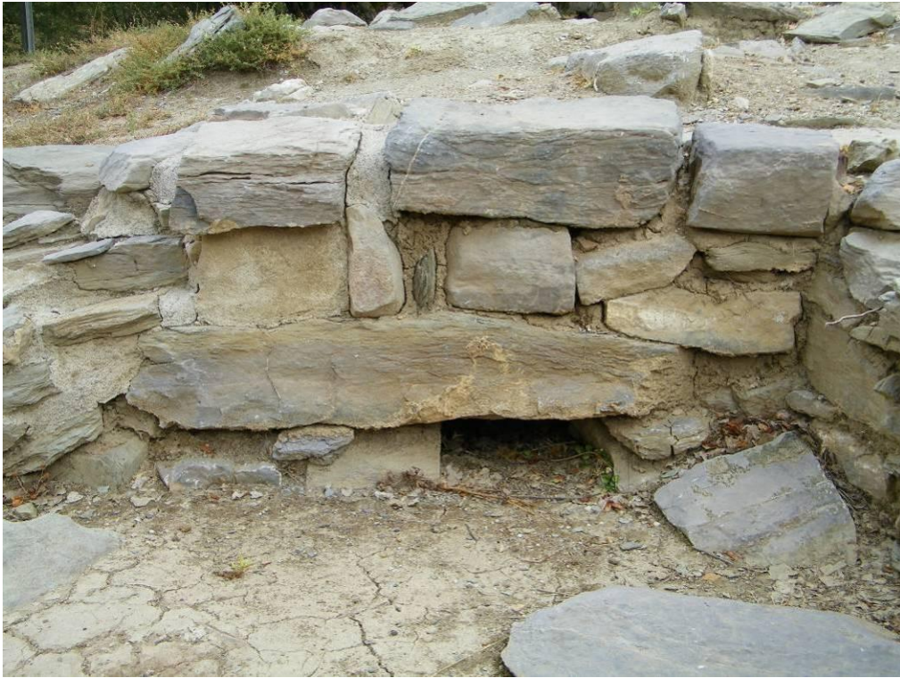
70α. Αγωγός Χώρου 56Α.
