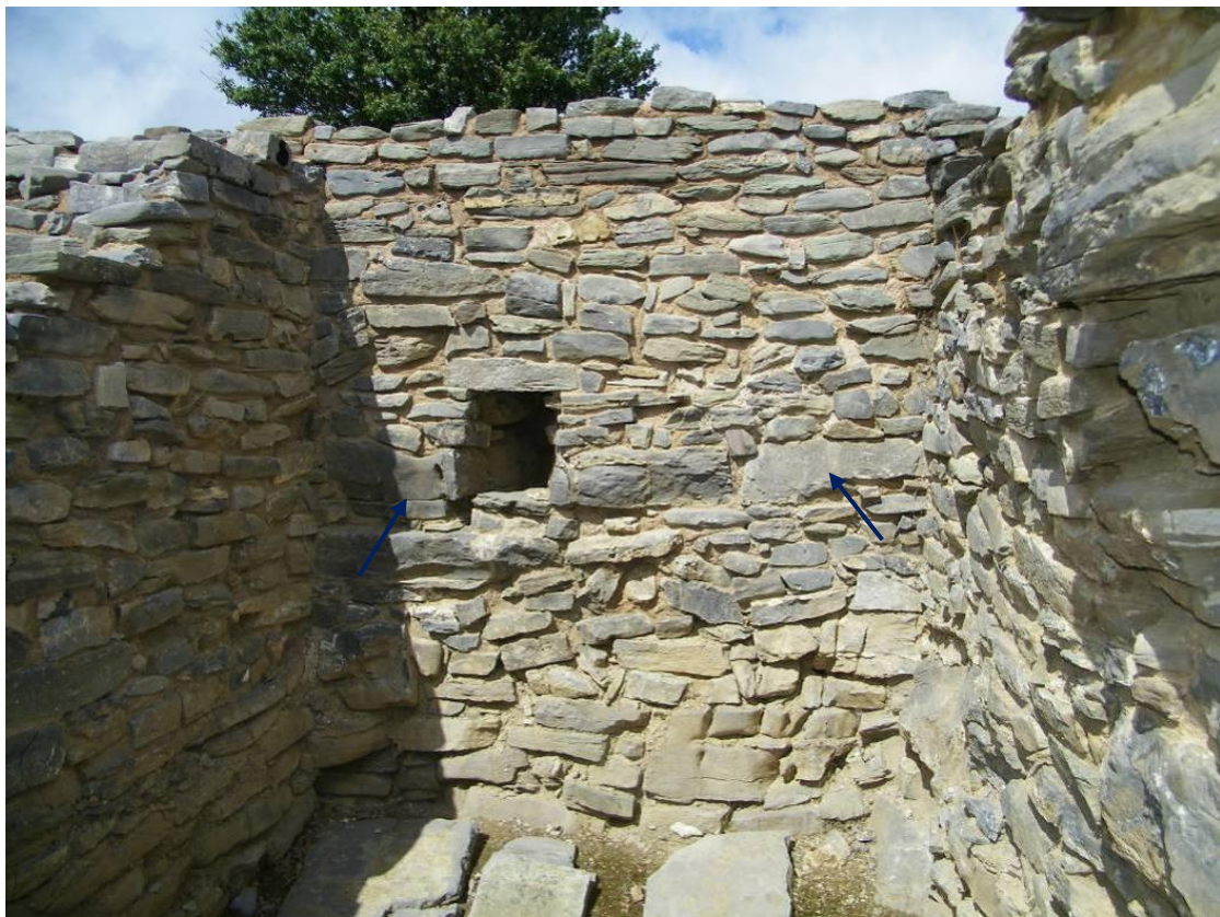
64β. Χώρος 11. Κόγχη και βόρειος τοίχος με ζώνη μεγάλου μεγέθους λίθων.
