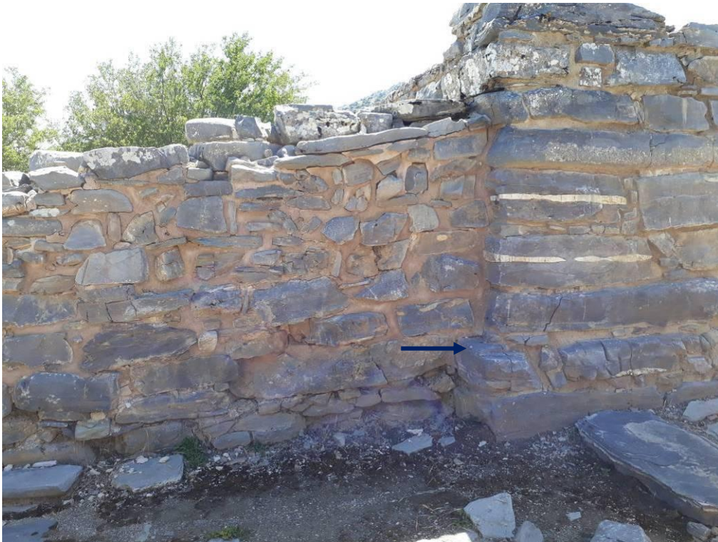
17β. Κρηπίδωμα και διαφορετικοί τρόποι δόμησης ανατολικού τοίχου Διαδρόμου 16.
