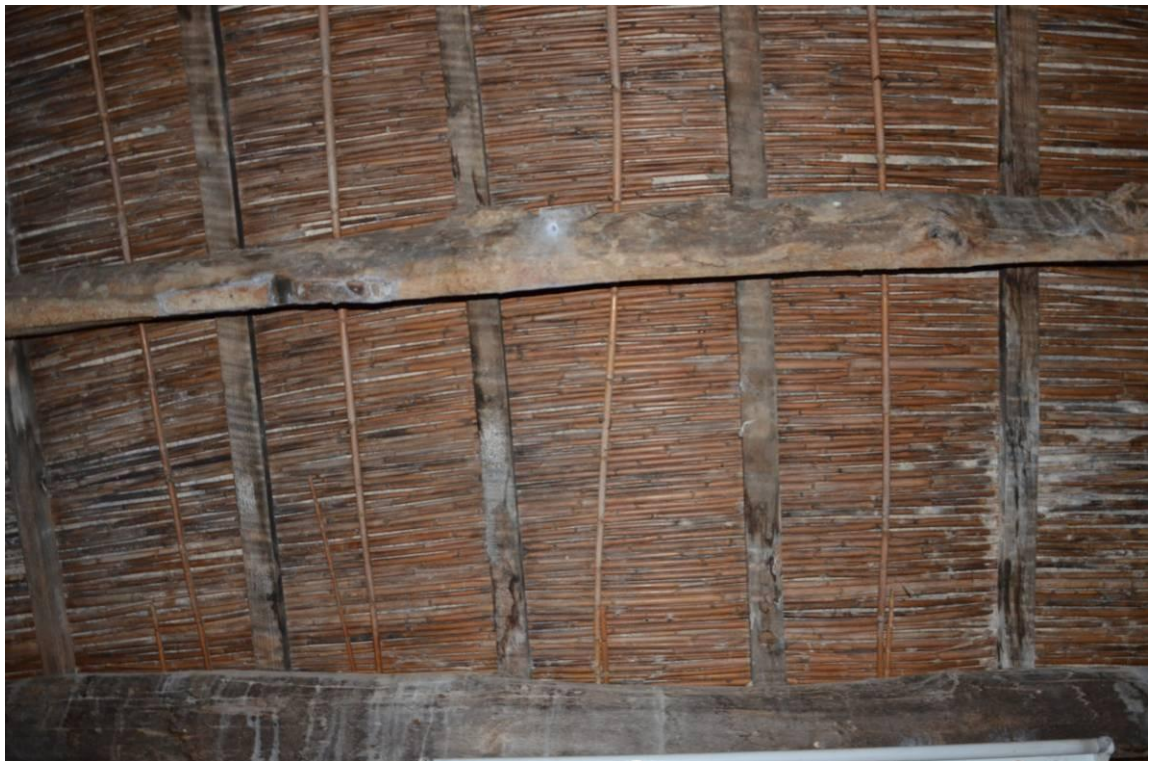
75β. Οροφή φάμπρικας δεκαετίας του 1940 στο Απεσωκάρι Μεσαράς Ηρακλείου (λεπτομέρεια).
