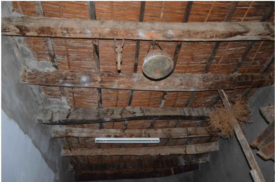
75α. Οροφή φάμπρικας δεκαετίας του 1940 στο Απεσωκάρι Μεσαράς Ηρακλείου.
