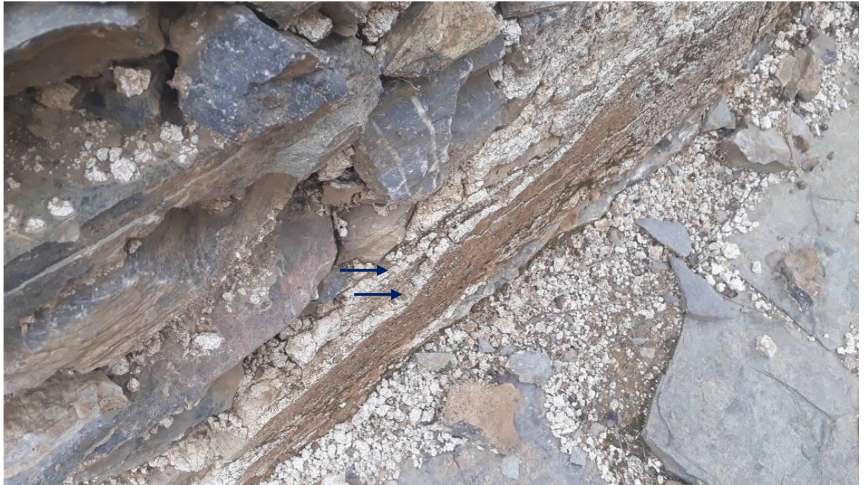
21α. Τρόπος επιχρίσματος δυο διαφορετικών στρωμάτων κονιάματος νότιου τοίχου Χώρου 7.
