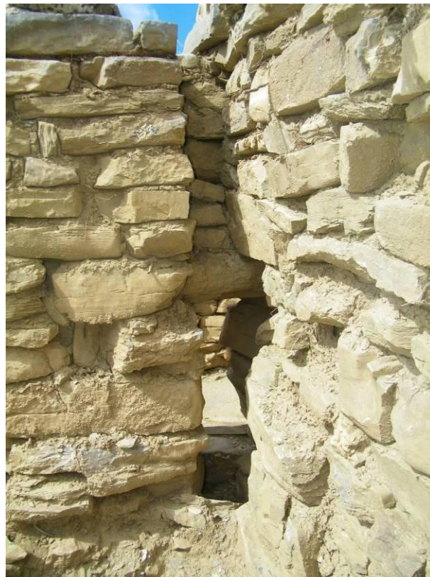
23β. Χώρος 41. Άνοιγμα δυτικού τοίχου προς το Διάδρομο 10.
