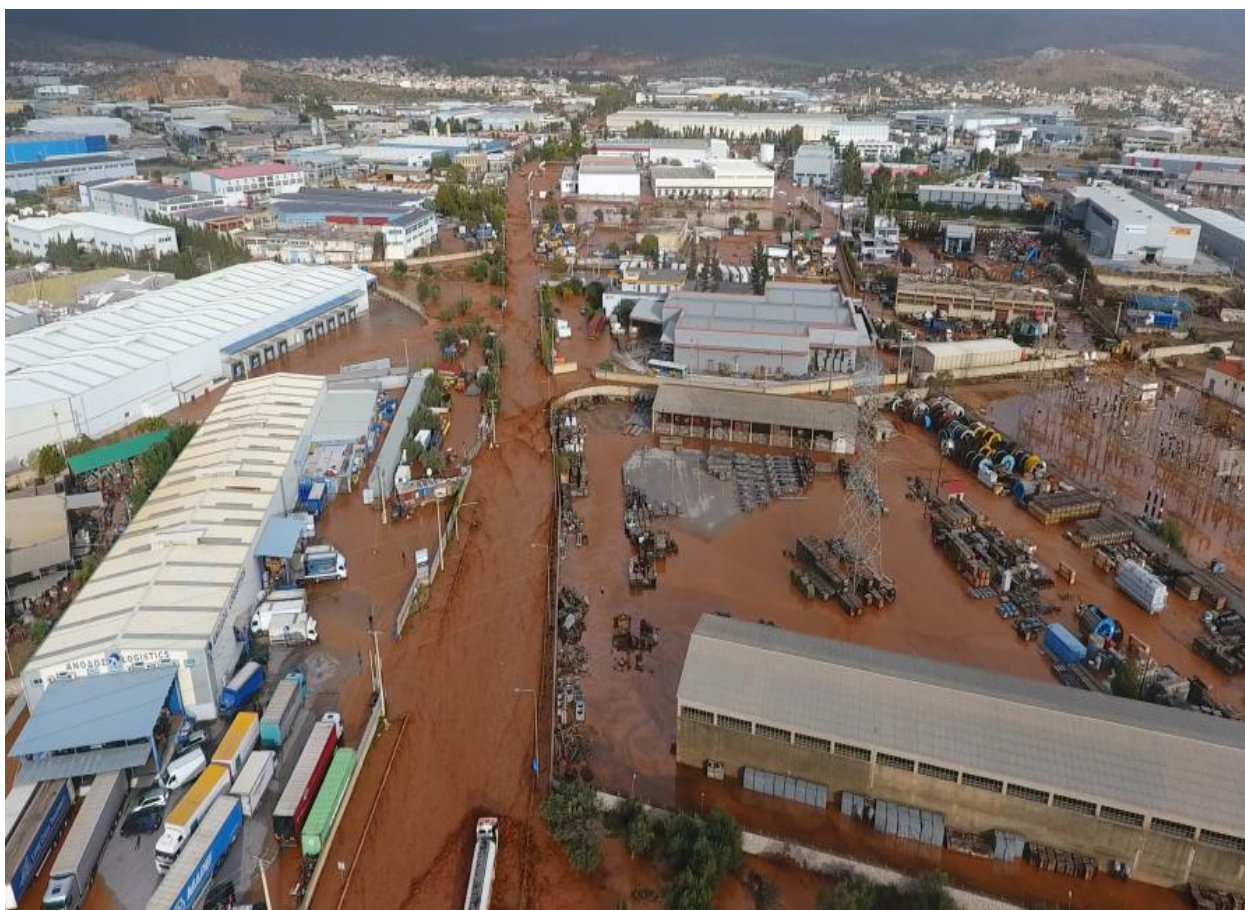
Εικόνα 5.6: Το μέγεθος της καταστροφής στην περιοχή της Μάνδρας. Πηγή: (Lekkas et al, 2017)
