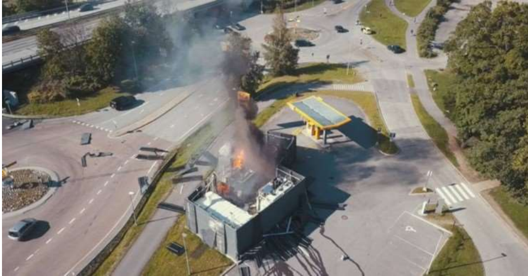
Εικόνα 2.21. Ατύχημα σε δεξαμενή αποθήκευσης Υδρογόνου πρατηρίου καυσίμων, Kjørbo, Sandvika, Νορβηγία, 10 Ιου. 2019. Πηγή: Loeffler, J. (2019).
